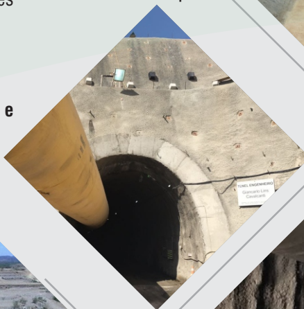
Túnel Eng. Giancarlo Lins Cavalcanti - Emboque
