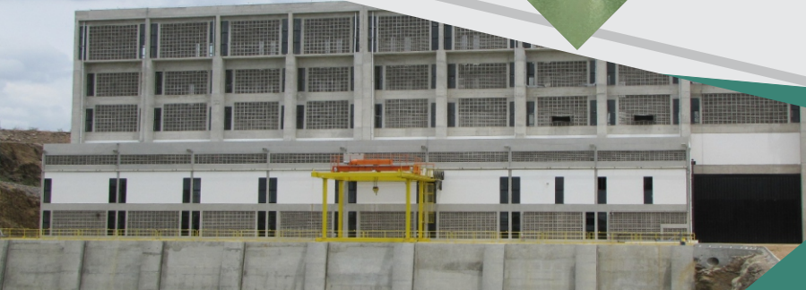
Estação de Bombeamento EBI-1
