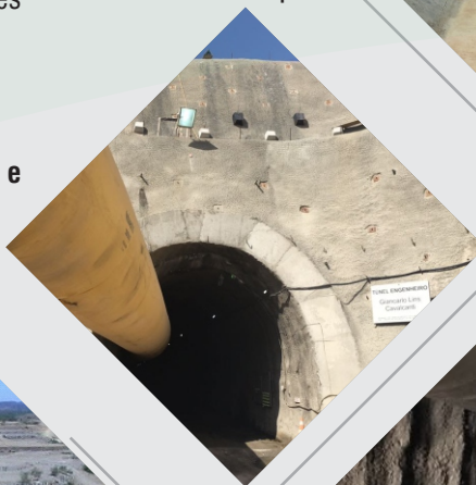
Túnel Eng. Giancarlo Lins Cavalcanti - Emboque
