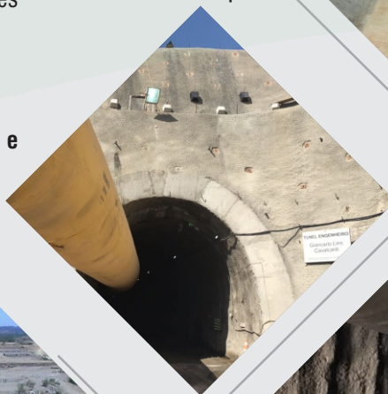
Túnel Eng. Giancarlo Lins Cavalcanti - Emboque
