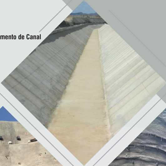
Túnel Eng. Giancarlo Lins Cavalcanti - Emboque
