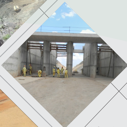
Estrutura de Controle Reservatório Boi I
