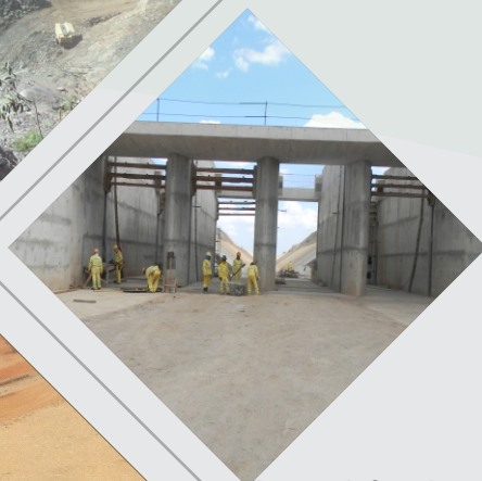
Estrutura de Controle Reservatório Boi I
