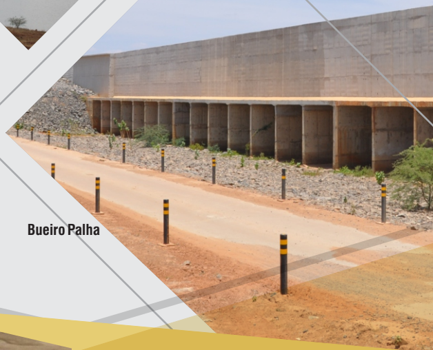
Estrutura de Controle Reservatório Boa Vista
