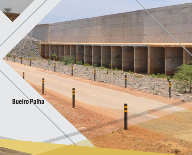
Estrutura de Controle Reservatório Boa Vista
