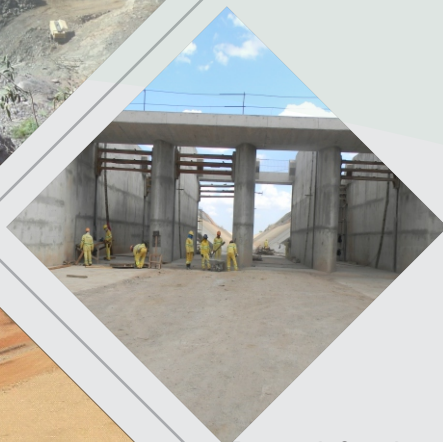
Estrutura de Controle Reservatório Boi I
