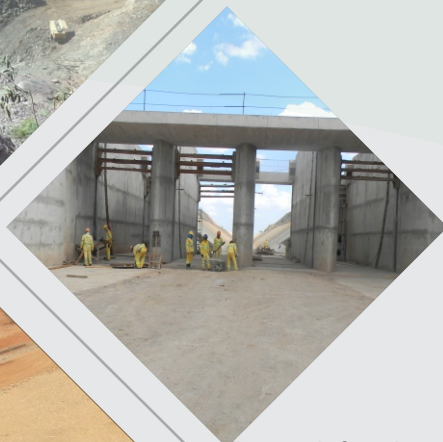
Estrutura de Controle Reservatório Boi I
