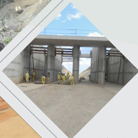
Estrutura de Controle Reservatório Boi I
