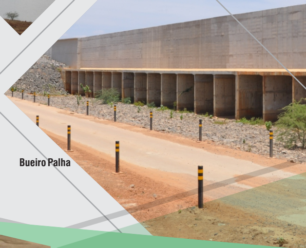
Estrutura de Controle Reservatório Boa Vista
