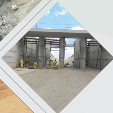
Estrutura de Controle Reservatório Boi I
