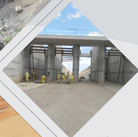
Estrutura de Controle Reservatório Boi I
