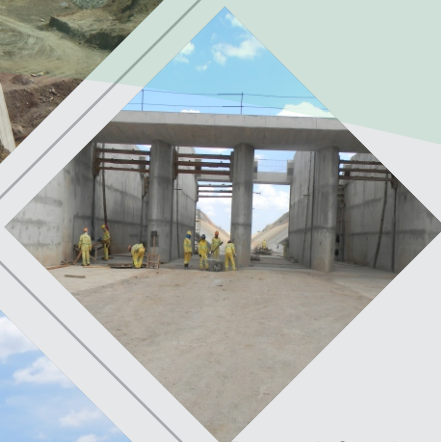
Estrutura de Controle Reservatório Boi I
