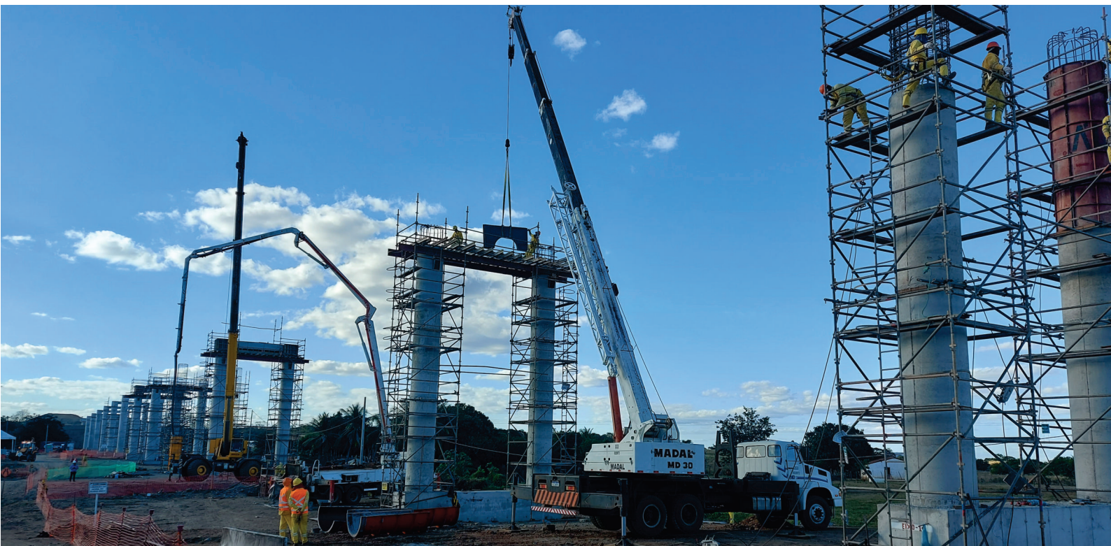
Execução de mesoestrutura (pilares) - Aqueduto Pitombeira.
