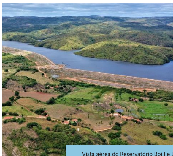
Vista aérea do Reservatório Boi I e Boi II, Brejo Santo-CE, Trecho II, Eixo Norte.
