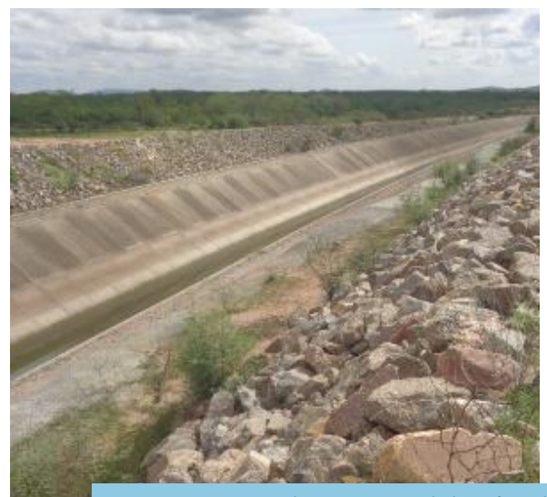
Enrocamento de proteção em talude na faixa de domínio do segmento de canal WBS 1208, Eixo Norte.
