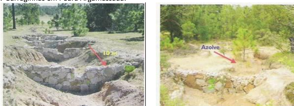
Figura 24.31. Barraginhas em Pedra Argamassada.
