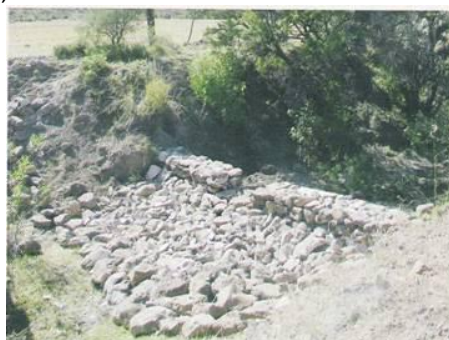
Figura 24.30. Barraginhas mistas, Gabiões com Pedra Arrumada a Jusante.
