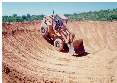
Figura 24.38. Execução de uma Barraginha de Terra Tipo EMBRAPA com Pá Carregadeira.
