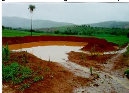
Figura 24.37. Barraginha de terra Tipo EMBRAPA.
