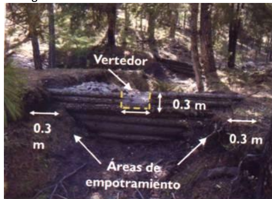
Figura 24.35. Barraginhas em Madeira Deitada Vertedouro Central.
