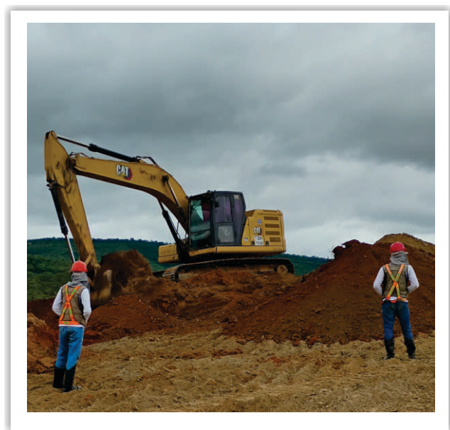
Técnico da Fumdhm/Inapas acompanhando escavação no Segmento de Canal 09.
