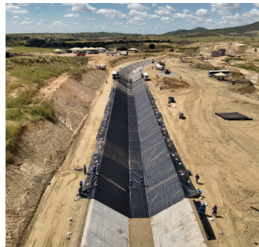
Avanço das atividades construtivas do Segmento de Canal 07.
