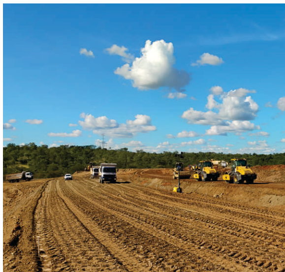
Avanço das atividades construtivas do Segmento de Canal 08 (Terraplenagem).
