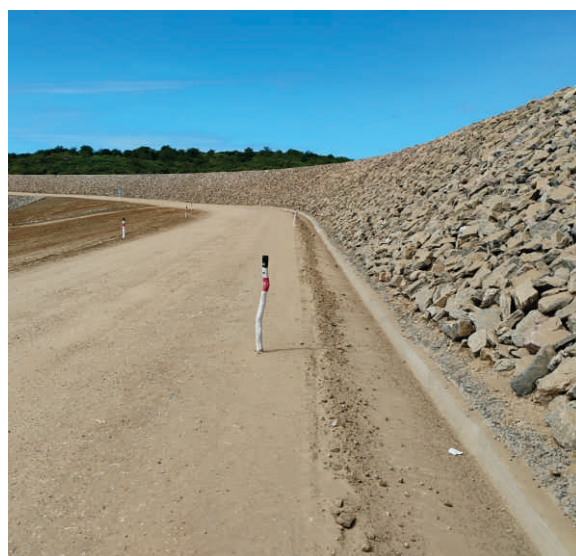
Implantação de medidas protetivas ao surgimento de processos erosivos em área adjacente ao Segmento de Canal 04.
