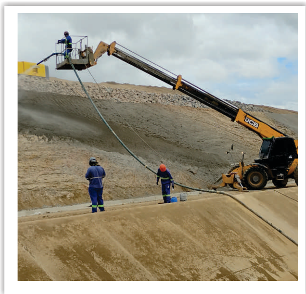
Avanço das atividades construtivas do Segmento de Canal 04.
