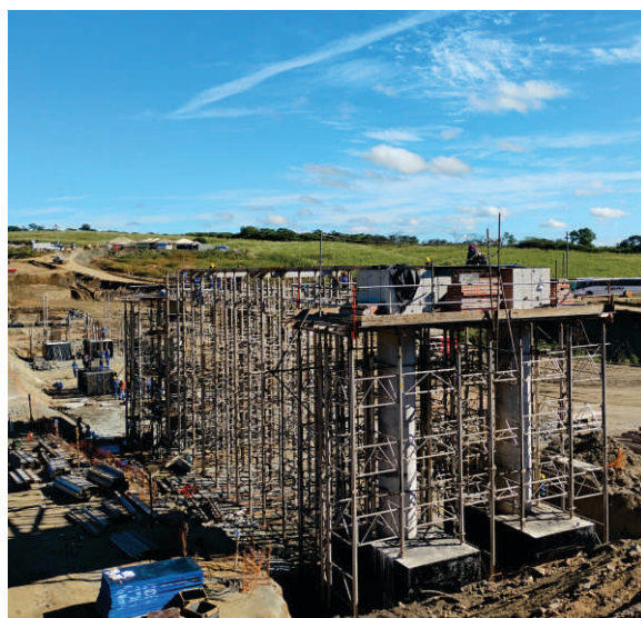
Avanço das atividades construtivas do Aqueduto Boa Vista.
