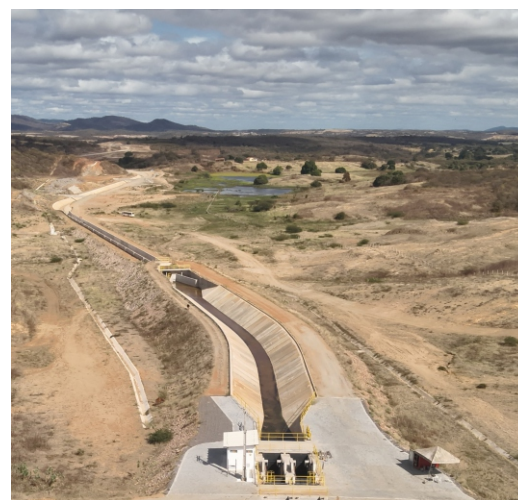
Trecho inicial do Ramal do Salgado, composto pela Estrutura de Controle km 30, Segmento de Canal 01 e Rápido Fazenda Pau Branco.
