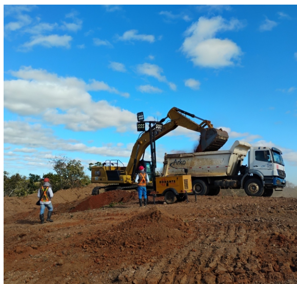
Escavação de caixa de empréstimo no Segmento de Canal 10.
