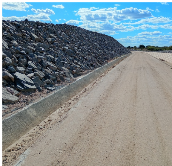
Estabilização e proteção do talude e canaleta de drenagem implantada para direcionamento de águas pluviais no Segmento de Canal 03.
