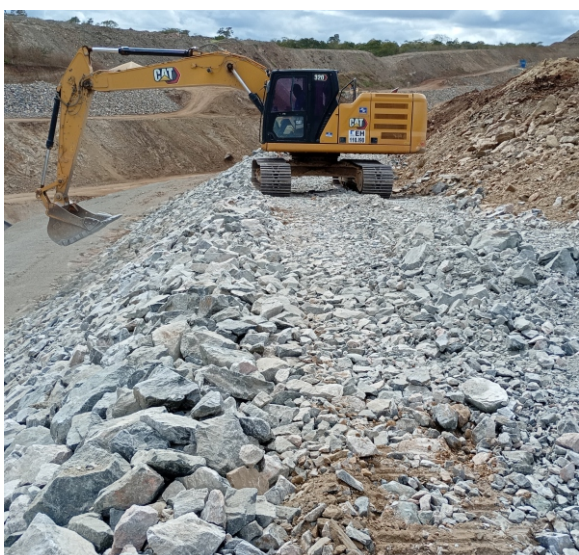
Enrocamento de talude no Segmento de Canal 05.
