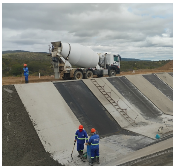
Revestimento de canal no Segmento de Canal 08.
