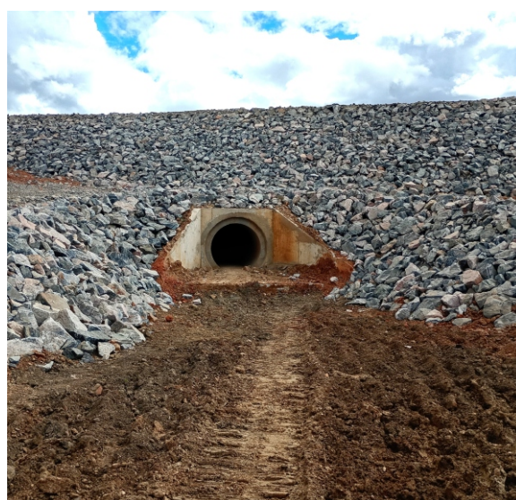
Medidas protetivas ao surgimento de processos erosivos (enrocamento do talude adjacente ao sistema de drenagem) no Segmento de Canal 06.
