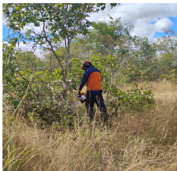
Supressão vegetal semimecanizada no Segmento de Canal 10.
