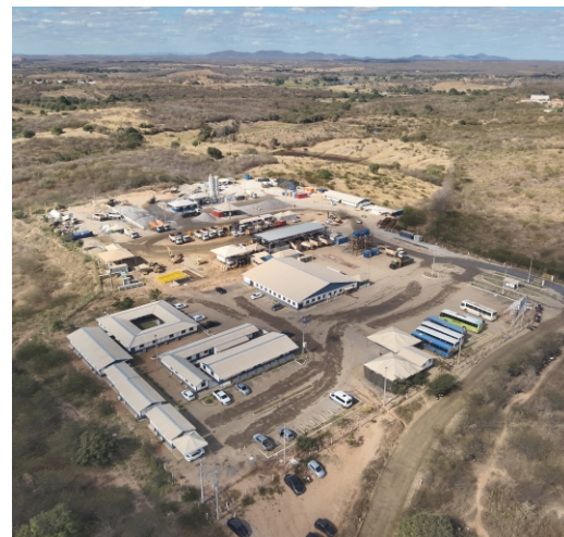
Canteiro de Obras do Consórcio ENGIBRAS/INSTALE – SALGADO.
