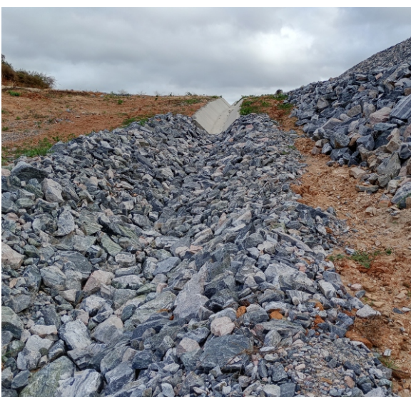
Medidas protetivas ao surgimento de processos erosivos (canaleta para direcionamento de águas pluviais e enrocamento do talude de aterro do canal adutor) em área adjacente ao Segmento de Canal 04.
