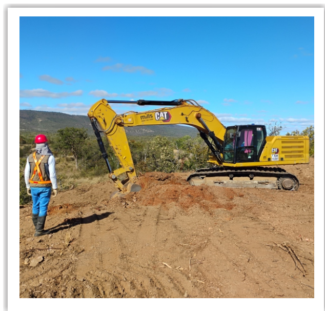
Técnico da Fumdhm/Inapas acompanhando a escavação de caixa de empréstimo no Segmento de Canal 10.
