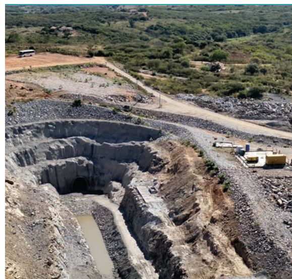
Concreto projetado e enrocamento de proteção em talude de corte no emboque do túnel Major Sales.
