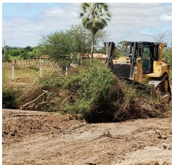
Execução de limpeza de rebrota na lateral do segmento de canal 13C.
