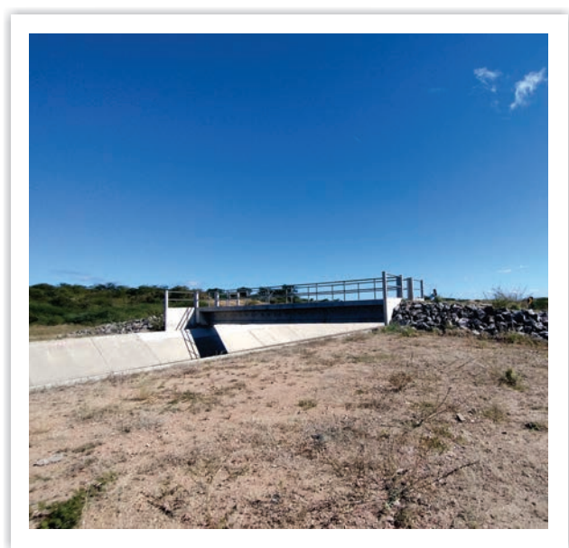
Vista parcial da Passarela 3, solução de engenharia para interferência viária no segmento de canal 6B.
