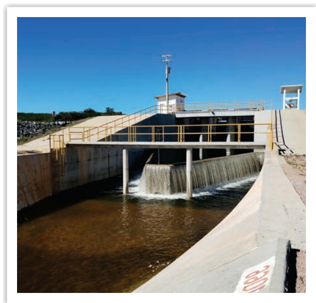
Vista parcial da estrutura de controle do reservatório Redondo.
