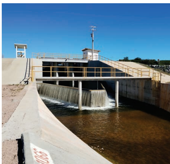
Montante da estrutura de controle do reservatório Redondo.
