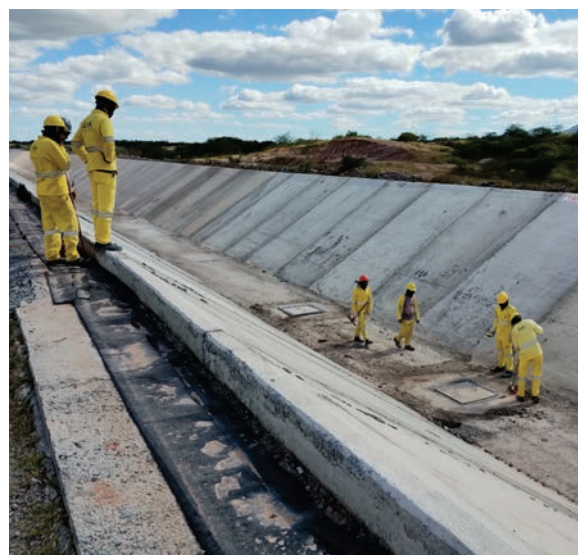
Execução de limpeza no segmento de canal 13B.
