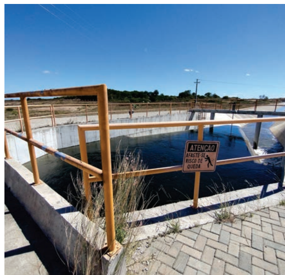
Vista parcial da estrutura de controle do km 30 e Derivação do Ramal do Salgado.
