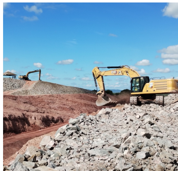
Execução de enrocamento de talude no segmento de canal 12C.
