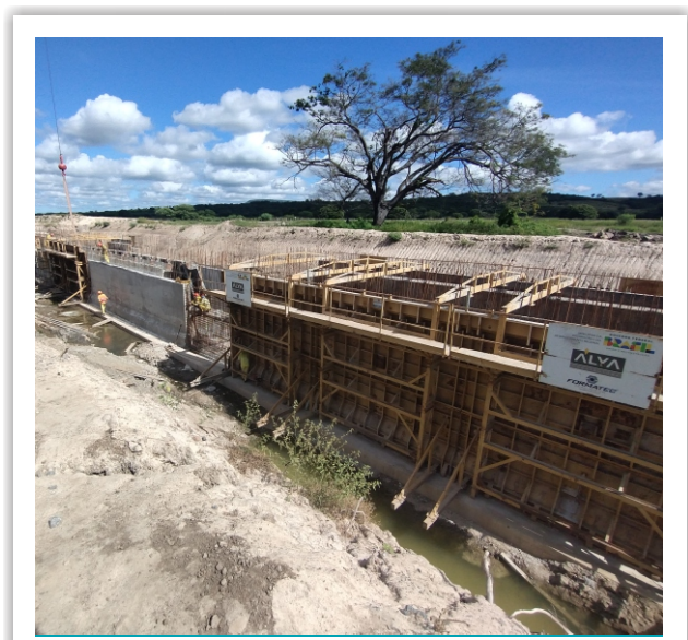
Execução da Galeria Bela Vista localizada no município de Uiraúna/PB.
