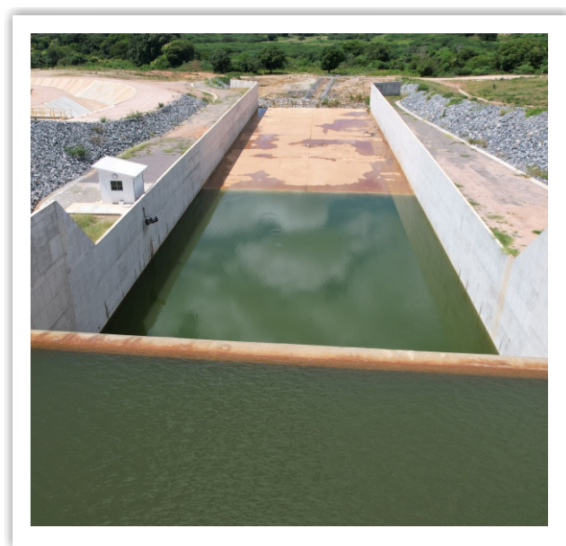
Vista parcial do vertedouro e da estrutura de controle da barragem Redondo.
