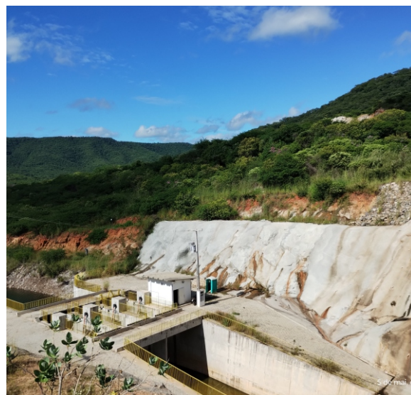
Vista parcial da Estrutura de Controle do Reservatório Caiçara.
