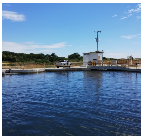
Vista parcial da Estrutura de Controle de Derivação para o Ramal do Salgado.
