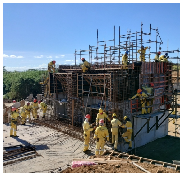
Execução do Sifão Invertido Lagoa de Dentro.
