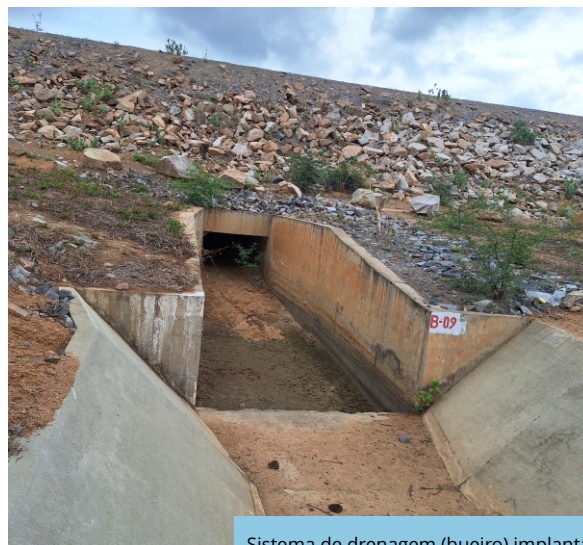
Sistema de drenagem (bueiro) implantado no segmento de canal WBS 1218, Trecho I, Eixo Norte do PISF (jun/2026).
