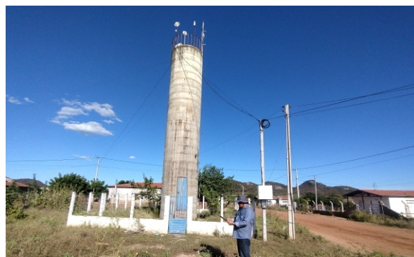
Vistoria do sistema de reservação secundária do SAA da VPR Queimada Grande em Salgueiro/PE (junho/2026).
