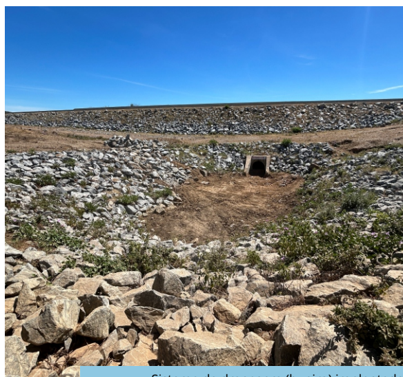
Sistema de drenagem (bueiro) implantado no segmento de canal WBS 2211, Trecho V, Eixo Leste do PISF (jun/2026).
