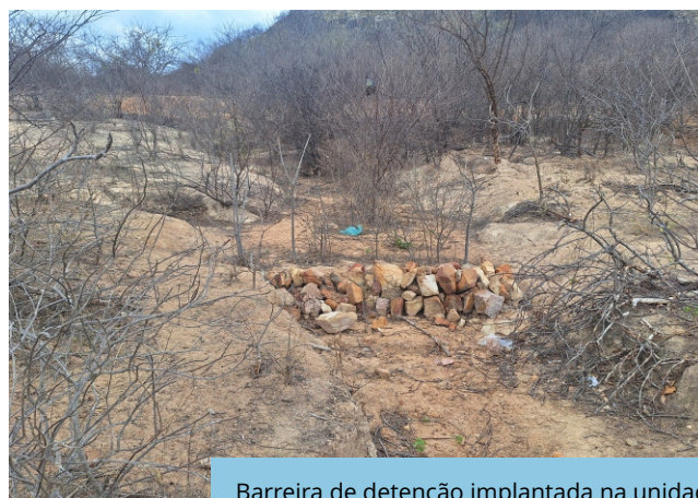
Barreira de retenção implantada na unidade demonstrativa da VPR Negreiros, Trecho II, Eixo Norte do PISF.
