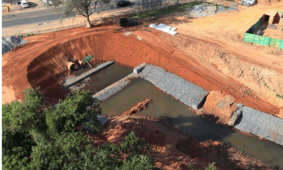
Figura 5.5 – Imagem da construção de caixa de retenção de sedimentos no Lago do Taboão em Bragança Paulista. Fonte: Jornal Mais Bragança, Edição de 24 de outubro de 2020. Disponível em https://jornalmaisbraganca.com.br/
