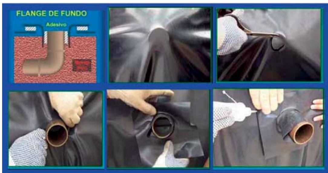
Figura 39 Sequência da colocação do flange de fundo do viveiro
