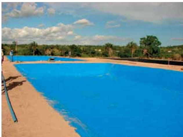
Foto 43: Viveiros revestidos com geomembrana
