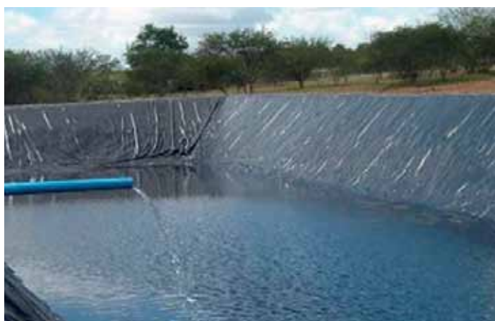
Foto 63: Abastecimento de água
