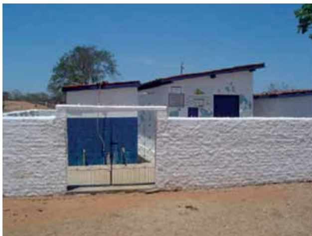
Foto 35: Sistema de dessalinização em Serra Branca/PB
