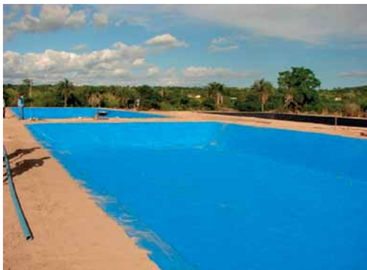
Foto 62: Fixação da geomembrana na vala de ancoragem
