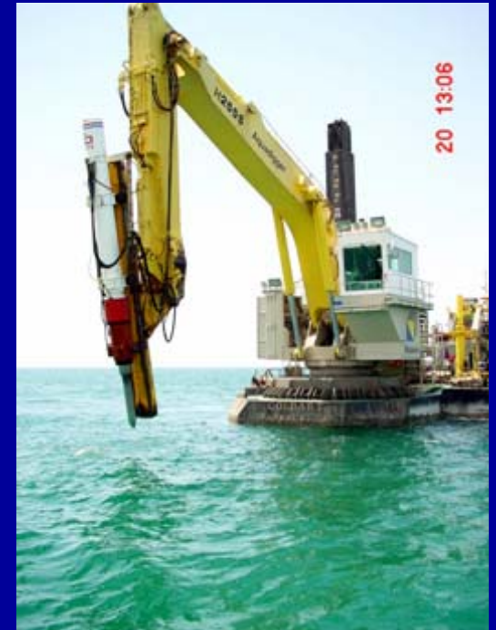
derrocamento com martetele hidráulico
