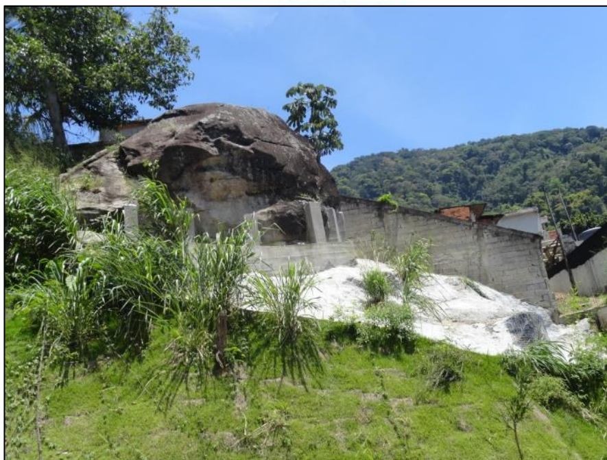
Figura 8 – Bloco de rocha parcialmente imerso na matriz de solo, com obra de contenção, no bairro Itatinga, São Sebastião (SP). (Fonte: Sirden-CTGeo-IPT).
