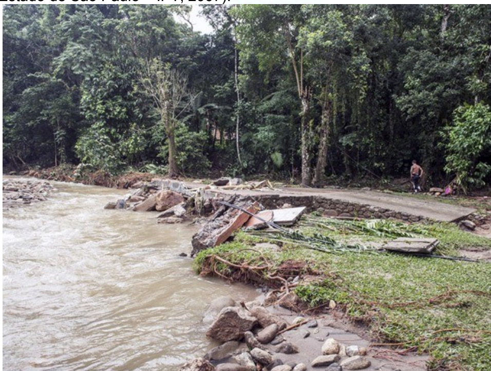
Figura 20 – Vista de danos causados por enxurrada, em Boiçucanga, São Sebastião, SP, em 24/02/2013 (foto de Lenadro Saadi/G1).
