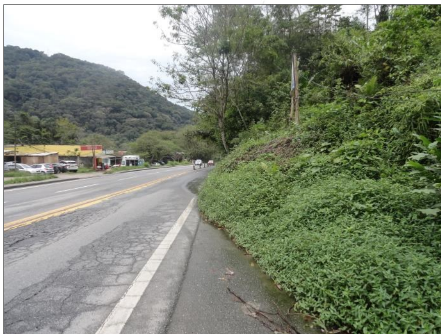
Figura 3– Vista parcial do depósito de tálus existente no bairro de Juquehy, em São Sebastião, SP, que está em movimento, afetando a rodovia. (Fonte: Sirden-CTGeo-IPT).
