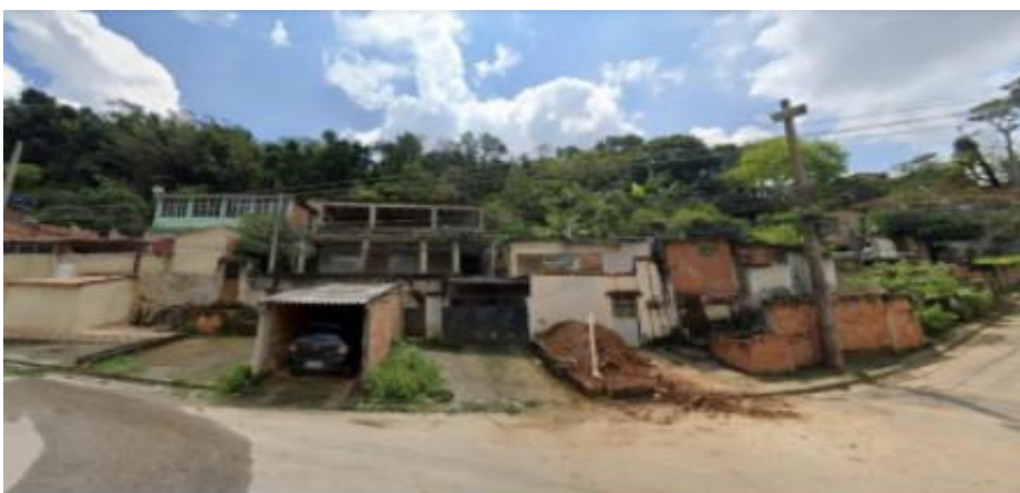
Região com risco de deslizamentos, bairro Cerâmica
