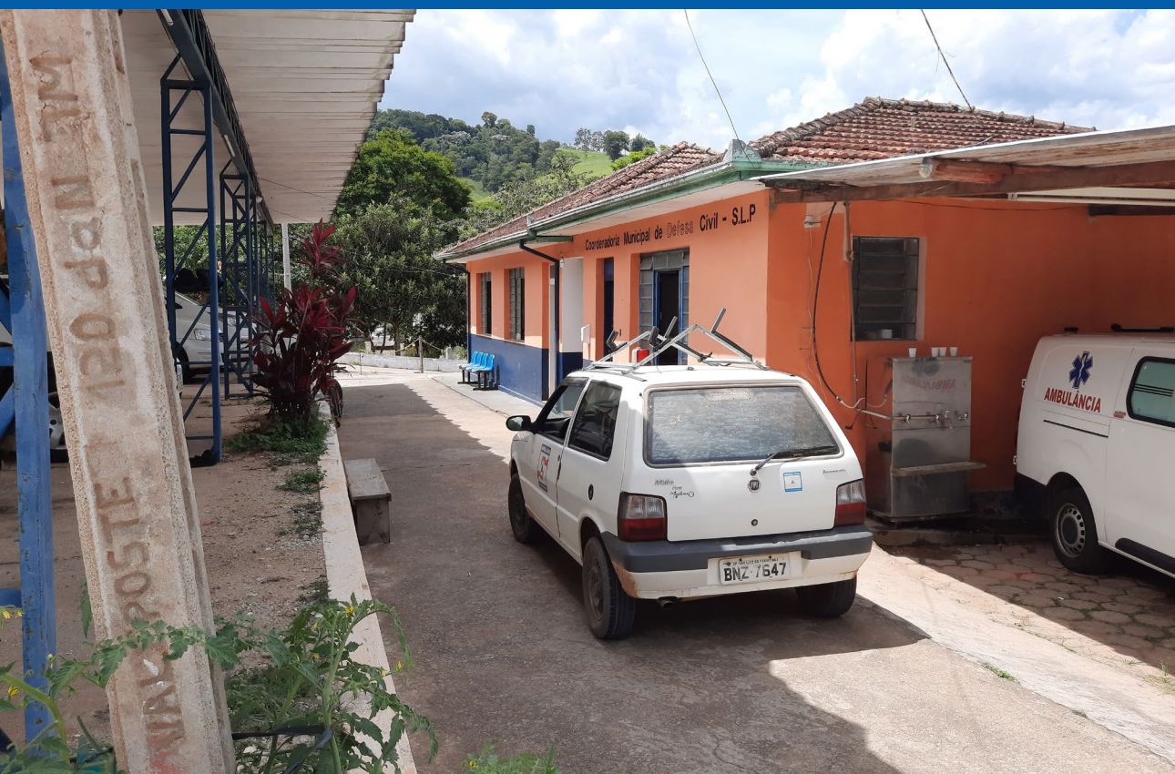
Sede e viatura de órgão municipal de proteção e defesa civil. Crédito: Victor Marchezini/Projeto Elos.
