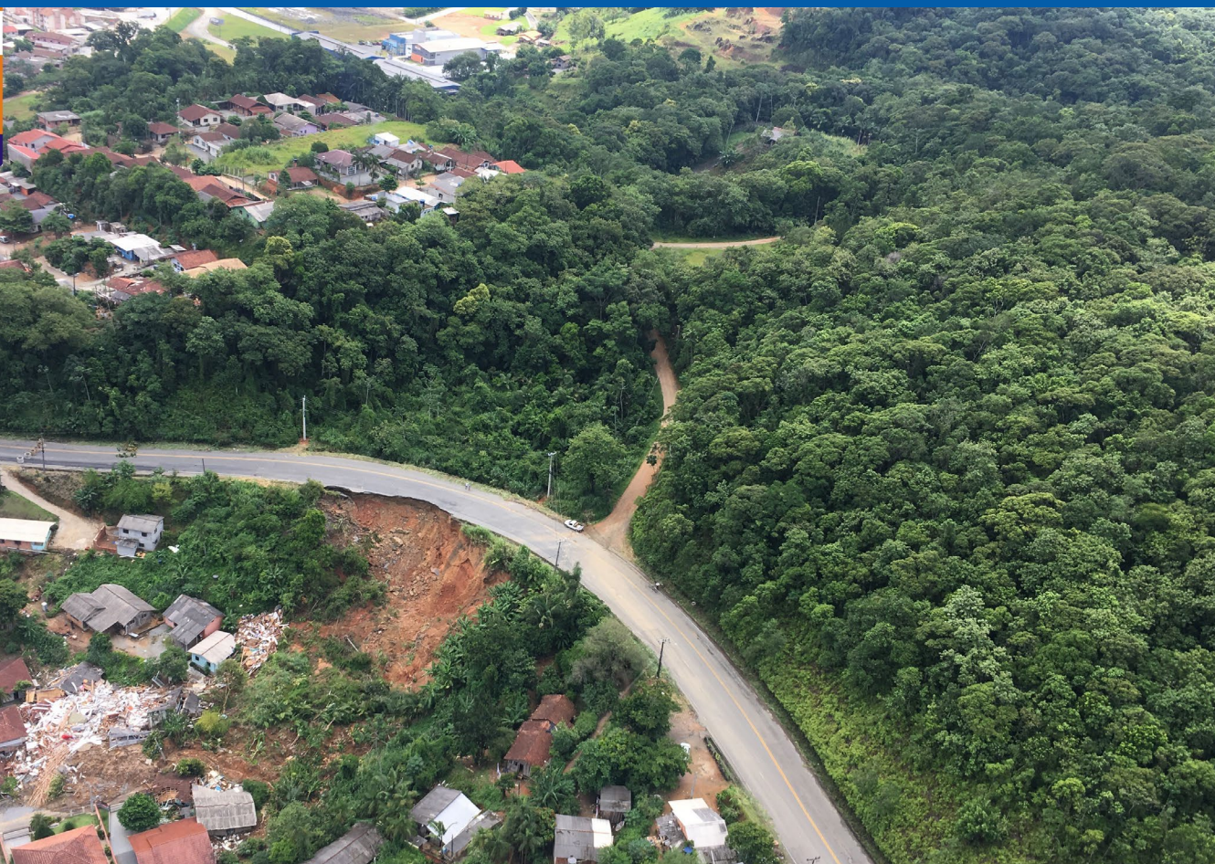
Deslizamento em Guaramirim, SC. Crédito: Defesa Civil de Santa Catarina
