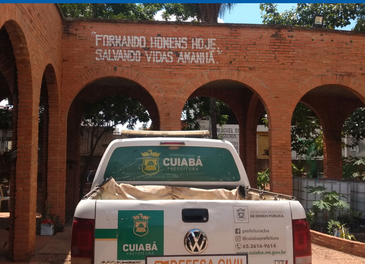
Estrutura da Defesa Civil Municipal de Cuiabá - MT Crédito: Thatyane Nascimento/Projeto Elos
