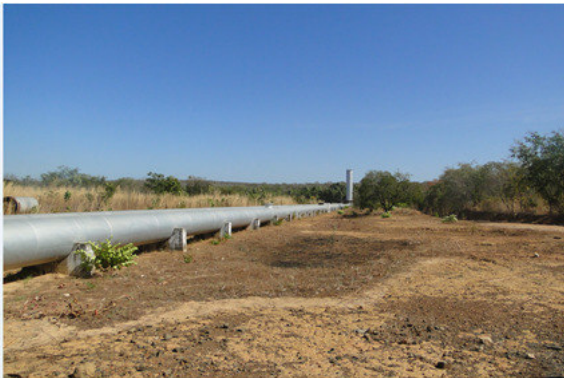
Tubulação aparente de Estação de Captação da 1ª Etapa (em funcionamento)
