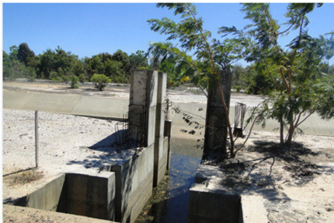
Entrada de água para estação de bombeamento em canais de distribuição de água da 2ª Etapa concluído
