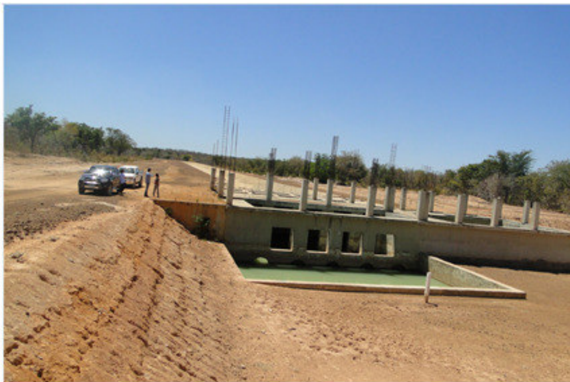
Estação de elevação para terrenos mais altos no perímetro de irrigação.
