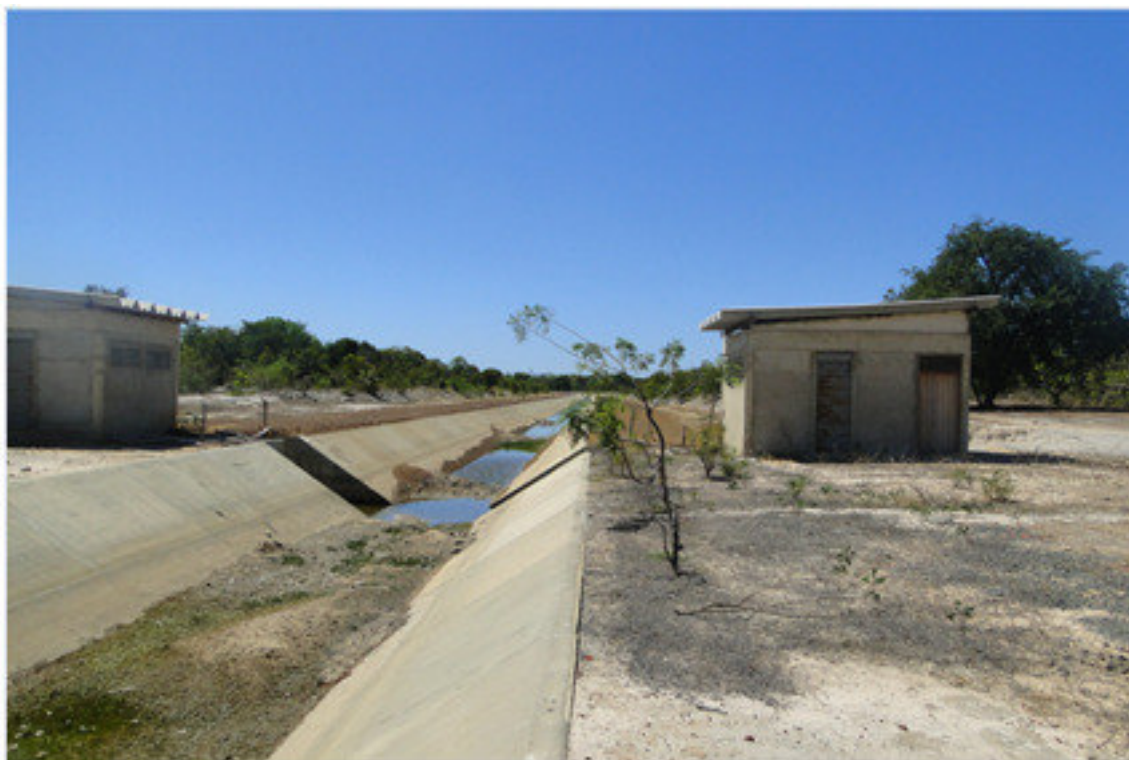
Estação de bombeamento em canais de distribuição de água da 2ª Etapa concluído
