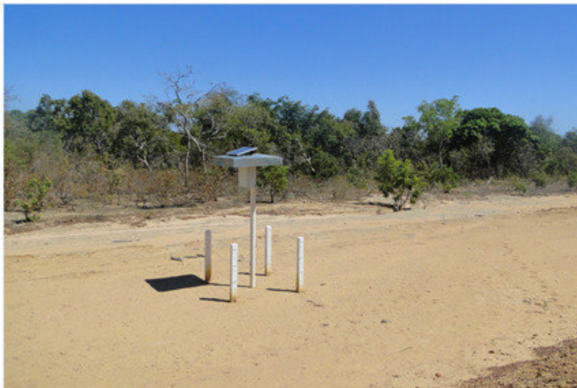
Equipamento para evitar corrosão na tubulação de ferro enterrada
