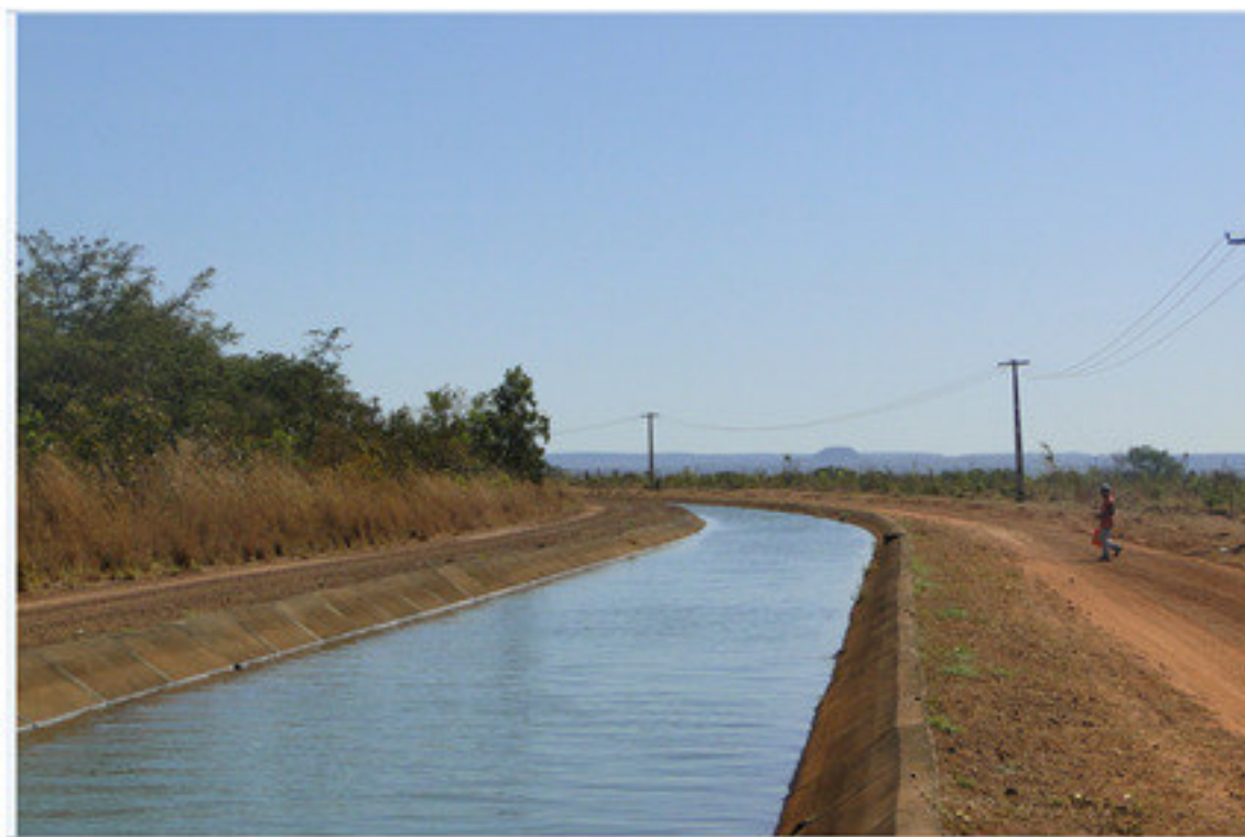
Canal de distribuição de água da 1ª Etapa (em funcionamento)
