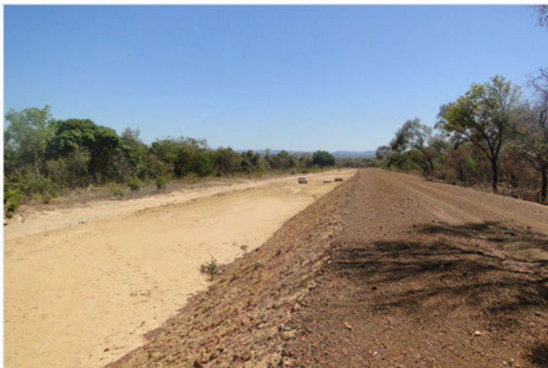
Tubulação enterrada que conduz água da Estação de Bombeamento para a 2ª Etapa do projeto aos canais de distribuição
