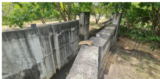
Imagem 8: Vista do canal de jusante para montante a partir da transição em concreto armado de outra estrutura para instalação de hidromecânicos de controle de nível.
