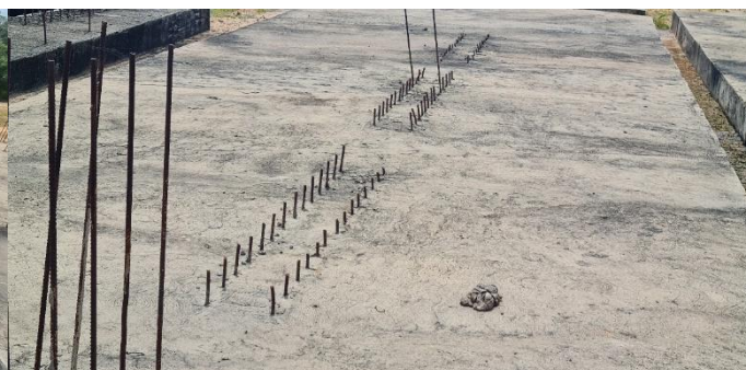
Imagem 5: Detalhe das condições em que se encontram as barras de aço. As barras de espera, já apresentam início de corrosão instalado, o que, com o passar do tempo, poderá comprometer a integridade das mesmas.
