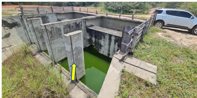
Imagem 6: Vista da estrutura (da esquerda para direita) em concreto armado em bom estado de conservação (paredes, chicana e ogiva). Ranhuras para instalação de “stop logs”.
