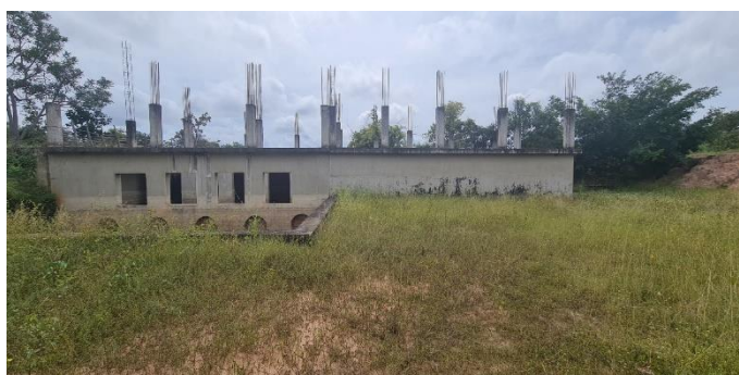
Imagem 8: Vista parcial da estrutura em concreto armado da Estação Elevatória com pilares inacabados (armadura exposta).
