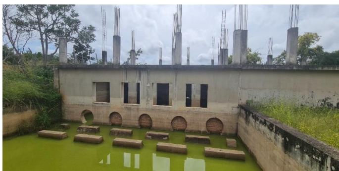
Imagem 7: Vista parcial da estrutura em concreto armado da Estação Elevatória com pilares inacabados (armadura exposta).
