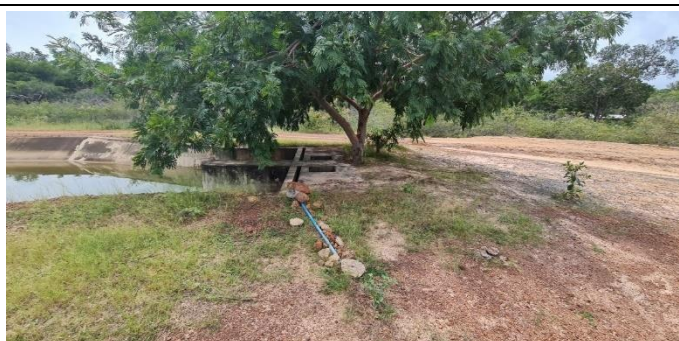
Imagem 22: Vista lateral da estrutura em concreto armado com dupla entrada para o primeiro sifão e árvore crescida e com diâmetro considerável junto à estrutura.
