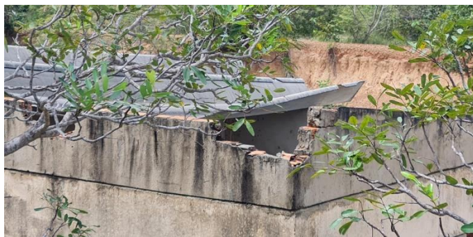
Imagem 8: Detalhe do telhado da edificação danificado, em algumas destas unidades, o madeiramento e telhas do tipo calhetão, foram removidos total ou parcial.
