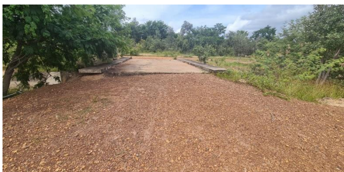
Imagem 9: Vista superior de ponte sobre a seção hidráulica, construída em concreto armado, com longarinas apoiadas ao nível das bermas do canal.
