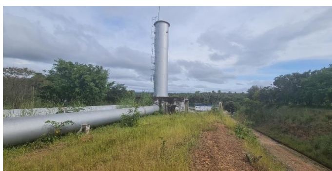
Imagem 10: Vista geral de montante para jusante, das adutoras de recalque, chaminé de equilíbrio e estrutura de ancoragem das mesmas.
