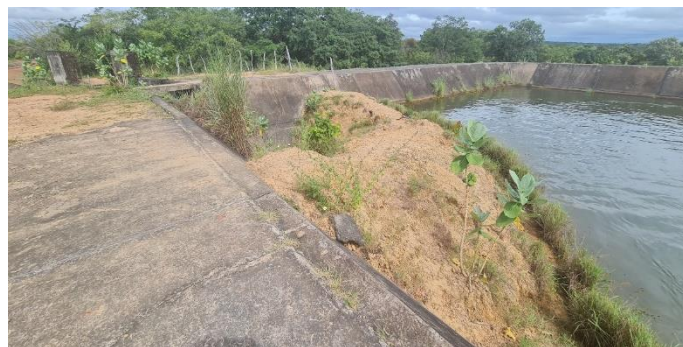
Imagem 4: Vista do Canto esquerdo (jusante) do Reservatório Pulmão ainda com a ensecadeira construída para dar condições de execução da segunda saída do reservatório para o Canal Principal 2.
