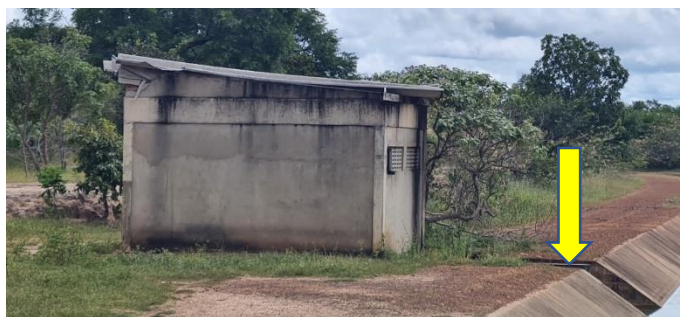
Imagem 14: As imagens acima mostram a estrutura de tomada d'água e casa de abrigo de bombas. As casas construídas em estrutura de concreto armado e alvenaria, coberturas com estrutura de madeira e telhas de fibrocimento, encontram-se deterioradas e árvores crescidas muito junto destas unidades, necessitando de urgente manutenção.
