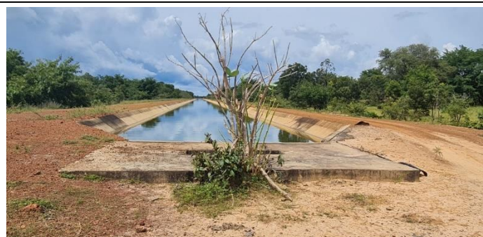
Imagem 28: Vista geral do segundo tramo de canal (montante para jusante) a partir da estrutura de saída do sifão e árvore crescida junto à estrutura em concreto armado.
