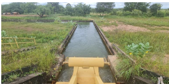
Imagem 14: Vista da estrutura de controle de nível e início do canal principal 1. O Canal principal 1, que atende prioritariamente à primeira etapa do projeto (setores hidráulicos 2, 3, 4 e 5), está em boas condições de operação, necessitando de manutenção principalmente de remoção de vegetação nas duas laterais do canal.
