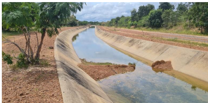
Imagem 2: Continuação do segmento do Canal Principal 2, com concreto de proteção mecânica em boas condições, bermas revestidas com solo laterítico, apresenta também alguns pontos com ensecadeiras em solo não removidas, sedimentos e vegetação aquática no fundo do canal.
