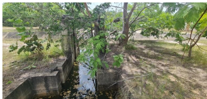
Imagem 2: A imagem mostra a estrutura em concreto armado, que faz a ligação do canal principal com o canal secundário, com ranhuras para instalação de equipamentos hidromecânicos de controle.
