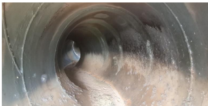
Imagem 8: Detalhe da situação interna (extremidade visível) da adutora não concluída, apresentando sedimentos e pontos com início de corrosão.
