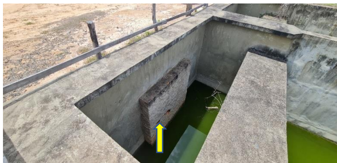
Imagem 4: Vista do ponto de saída da água (da direita para esquerda). A seta amarela mostra o tamponamento da adutora do lado direito, a qual está ancorada na parede da caixa de desagüe.
