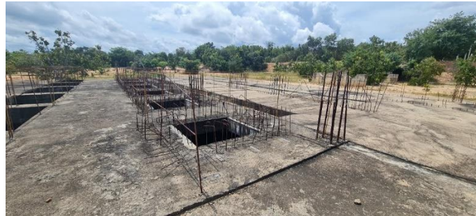
Imagem 4: Esta imagem, mostra armaduras de arranque para blocos de ancoragens ou suporte de bombas e adutoras. As barras de aço ainda existentes, estão ainda em condições de uso, no entanto, necessitarão de tratamento para que sejam ancoradas barras novas para prosseguimento da estrutura.
