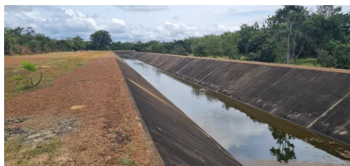
Imagem 6: Uma vista geral do segmento de canal, onde se observa a situação em que se encontra a estrutura da proteção mecânica bem preservada, como também as bermas do canal com proteção em solo laterítico.
