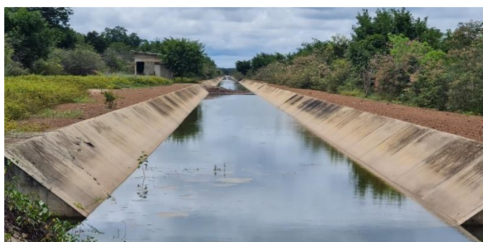
Imagem 14: As fotografias acima vistas de jusante para montante do final do canal principal 2, evidenciam vegetação densa nas bermas do canal, vegetação esta que, com o passar do tempo e em não sendo removida juntamente com as raízes, certamente irão provocar danos nas bermas, geomembrana de impermeabilização e proteção mecânica do canal.
