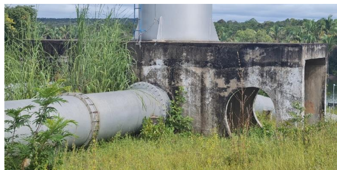
Imagem 11: Detalhe da estrutura de ancoragem das adutoras e base da chaminé de equilíbrio, com nicho para instalação de uma terceira adutora.
