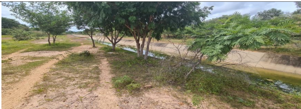
Imagem 12: A Fotografia acima mostra situações recorrentes de árvores crescidas nas bermas dos canais e muito próximas do concreto de proteção mecânica.
