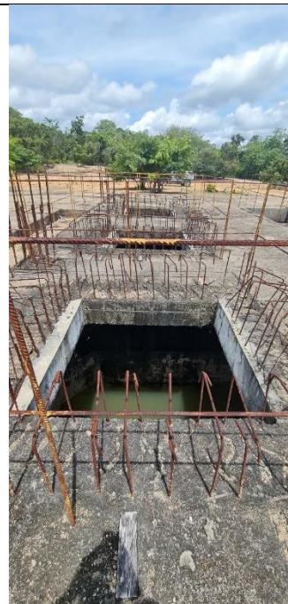
Imagem 5: Detalhe das condições em que se encontram as barras de aço. As barras de espera, já apresentam início de corrosão instalado, o que, com o passar do tempo, poderá comprometer a integridade das mesmas.
