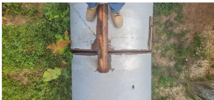
Imagem 5: Detalhe de ponto onde não houve a solda entre os módulos de tubos.
