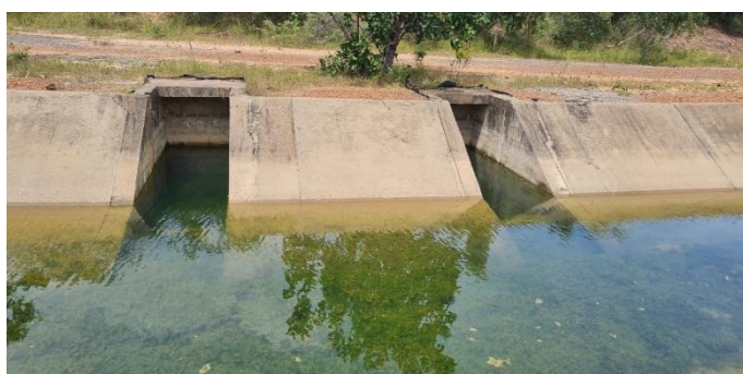
Imagem 2: Continuação do segmento do Canal Principal 2, com concreto de proteção mecânica em boas condições, bermas revestidas com solo laterítico, apresenta também alguns pontos com ensecadeiras em solo não removidas, sedimentos e vegetação aquática no fundo do canal.
