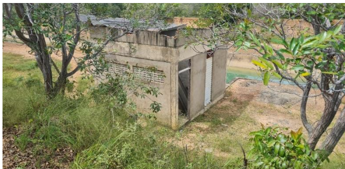
Imagem 7: Edificação para abrigo de bombas deteriorada, sem porta e telhado danificado.
