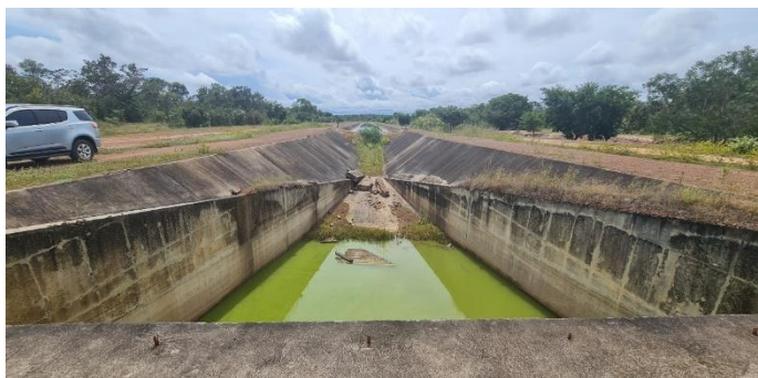
Imagem 1: Final da primeira etapa do segmento de canal (CP-2) que chega até a Estrutura da Estação Elevatória para alimentação de parte da Segunda Etapa do projeto. Vista de jusante para montante, onde se vê a transição de montante da estrutura para o canal.
