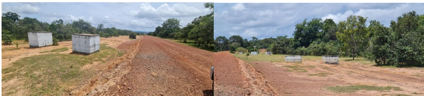
Imagem 4: As imagens acima, mostram ao longo do traçado, estruturas em concreto armado (caixas) que parecem ser de abrigo de ventosas nas duas linhas das adutoras. As fotografias ora são de visadas para jusante e ora para montante.
