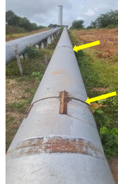
Imagem 4: Como pode ser observado, esta adutora ainda está por concluir, existem módulos de tubos não conectados aos outros através de solda e, em razão do tempo de instalação está necessitando de pinturas pontuais
