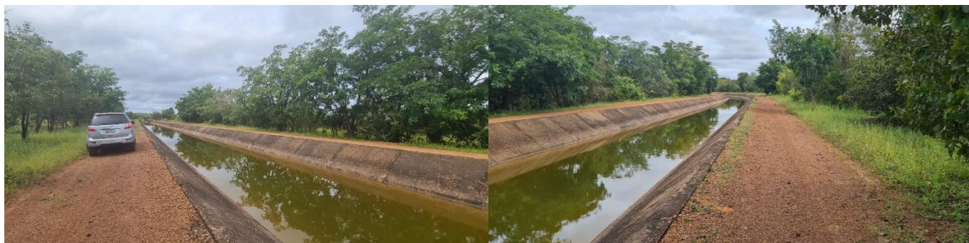
Imagem 10: Canal com estrutura preservada e com água de chuva. Pode-se observar também a vegetação de grande porte na lateral e muito próximo à seção hidráulica.6.
