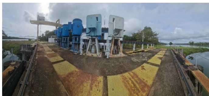
Imagem 5: Vista Panorâmica dos 5 conjuntos motor bombas e os nichos para instalação de mais 4 conjuntos.
