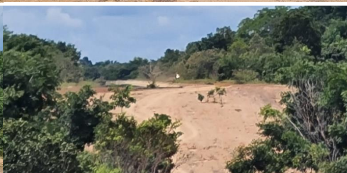
Imagem 25: Vistas por aproximação do traçado do sifão até o ponto de descarga em novo tramo de canal (montante para jusante) onde pode ser observado o talvegue por onde as águas de chuva escoam de forma natural. O terreno no traçado (deve ser aterro compactado) apresenta erosões e vegetação que necessitam de intervenção de correções e a estrada de manutenção para os tramos de canais.
