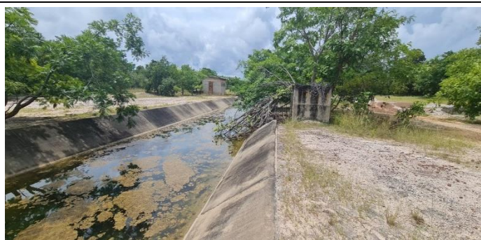
Imagem 1: Vista para jusante do canal principal, vendo-se na margem direita, a estrutura em concreto armado onde deriva o canal secundário.
