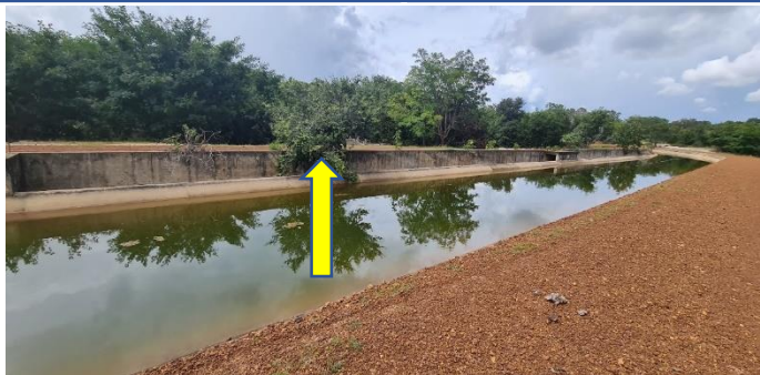
Imagem 19: A imagem acima mostra numa vista geral, a caixa na parte central para onde converge o excedente de água e árvore crescida dentro da seção do extravasor.
