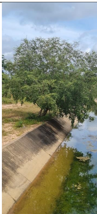
Imagem 13: As Fotografias acima mostram situações recorrentes de árvores crescidas nas bermas dos canais e muito próximas do concreto de proteção mecânica.
