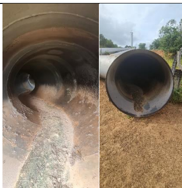
Imagem 9: Detalhe da situação interna (extremidade visível) da adutora não concluída, apresentando sedimentos e pontos com início de corrosão.
