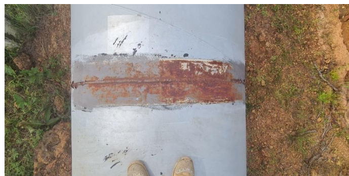
Imagem 7: Detalhe de solda executada em processo de corrosão e necessitando de pintura.
