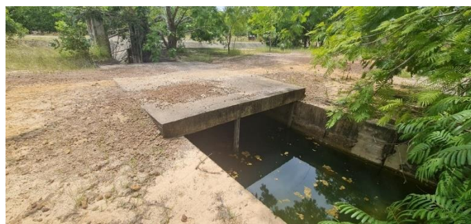
Imagem 4: A imagem acima, mostra a estrutura em concreto armado para instalação de equipamentos de controle, na derivação com o canal principal e a ponte sobre a transição (também em concreto armado) para o segmento de canal secundário.
