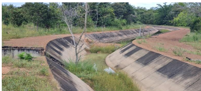
Imagem 2: Vista da seção hidráulica do canal onde há sedimentos, vegetação e árvore, isto é o indicativo que não está havendo manutenção no canal, tanto na face interna, quanto na externa, onde a vegetação está exuberante e muito próxima às bermas, o que pode em futuro próximo, acarretar danos provocados por raízes das árvores a procura de água na seção hidráulica (desplacamento e vazamento).
