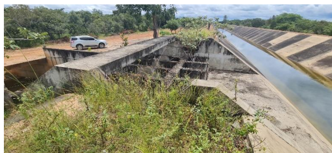
Imagem 22: Vista geral da estrutura em concreto armado do extravasor inacabado, no alinhamento da berma direita do canal (vista de jusante para montante).
