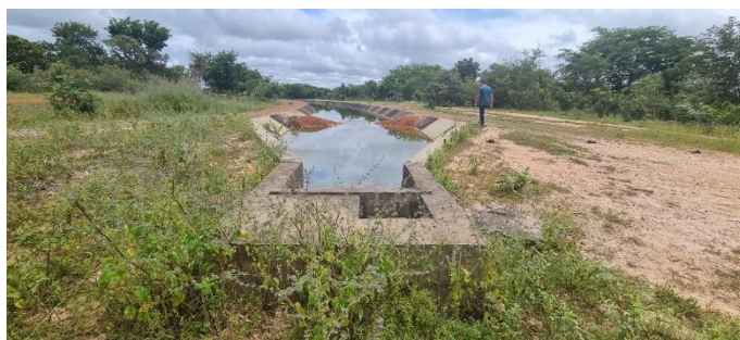
Imagem 33: Vista do final do canal com a estrutura em concreto armada de um ponto de captação de água para lote empresarial (vista de jusante para montante).
