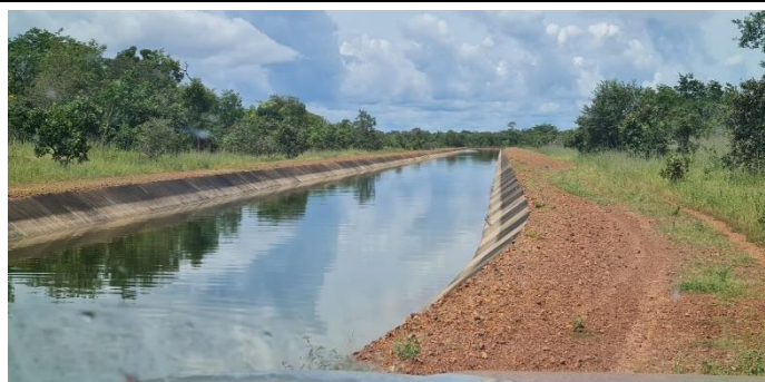
Imagem 34: A imagem vista de montante para jusante, mostra o início e final do traçado e o talvegue onde passa o segundo sifão enterrado (linha simples). Na imagem observa-se vegetação que deve ser removida deixando o traçado limpo e em condições de tráfego para a realização de manutenção das obras.
