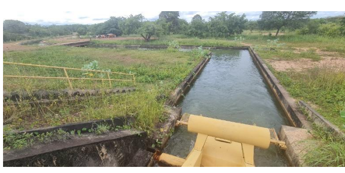
Imagem 13: Estrutura de controle de nível na saída do reservatório pulmão para o Canal Principal 1, que atende à primeira etapa do projeto. Estrutura em funcionamento e em boas condições de uso.
