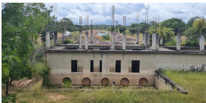
Imagem 5: Vista Geral da estrutura em concreto armado da Estação Elevatória com pilares inacabados (armadura exposta).
