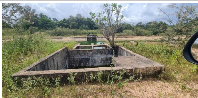
Imagem 29: Estruturas em concreto armado para tomadas d'água para lotes empresariais nas margens esquerda e direita do canal.
