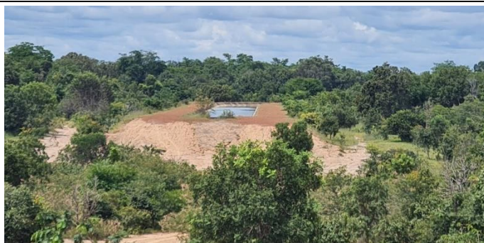
Imagem 33: Foto do final do segundo tramo de canal e estrutura em concreto armado de entrada e alinhamento do segundo sifão (enterrado) de linha única. A imagem mostra a estrutura de concreto e a estrada de terra ao lado.
