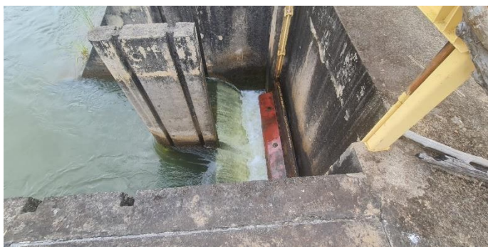
Imagem 12: Ainda, conectadas ao Reservatório Pulmão, está a Estrutura da Tomada D'água para o Canal Principal 1, que atende prioritariamente a Pivôs Centrais e aos setores hidráulicos 2, 3, 4 e 5 destinados empresários e pequenos irrigantes.
