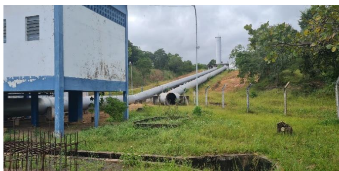
Imagem 1: Vista geral de montante para jusante das duas adutoras até o bloco de ancoragem das curvas e chaminé de equilíbrio. Uma em funcionamento (esquerda) e a outra por concluir (direita).
