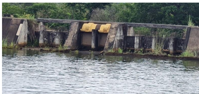
Imagem 7: Esta imagem mostra o extravasor instalado e os dois nichos para instalação dos dois outros, os quais estão com estrutura em concreto e armadura de espera inacabados e processo de degradação do aço, em virtude do tempo de construção e sem manutenção.
