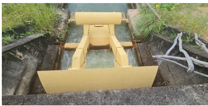
Imagem 13: Estrutura de controle de nível na saída do reservatório pulmão para o Canal Principal 1, que atende à primeira etapa do projeto. Estrutura em funcionamento e em boas condições de uso.
