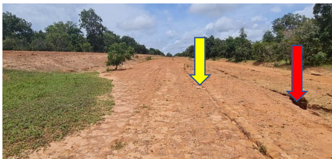
Imagem 5: A imagem acima (vista de jusante para montante), mostra o alinhamento por onde passam as duas adutoras enterradas, onde pode ser visto pequenas erosões na superfície do terreno. Como o terreno está em declive e sem proteção de vegetação (gramíneas), pode-se observar no alinhamento da seta amarela um pequeno ravinamento, no alinhamento da seta vermelha, já começa uma erosão.
