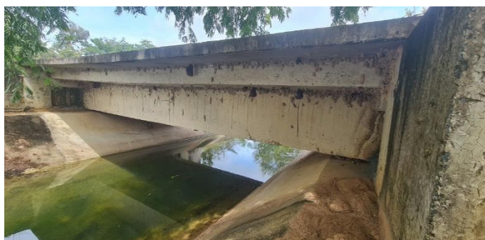
Imagem 10: Vista lateral de ponte sobre a seção hidráulica, onde se observa que, as longarinas estão apoiadas a nível de bermas.
