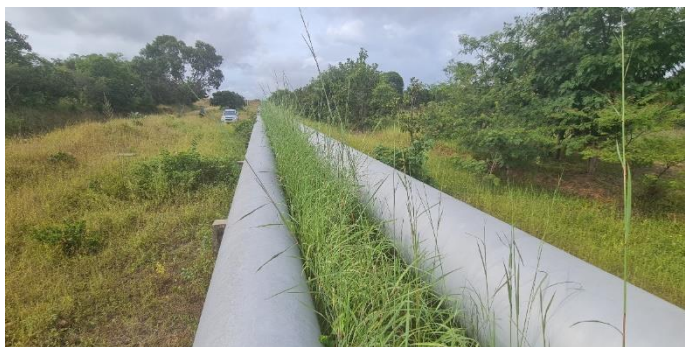
Imagem 13: Vista geral de montante para jusante, a partir da chaminé de equilíbrio para o reservatório pulmão, das duas adutoras, onde pode ser observado a existência de vegetação lateral e entre as mesmas.
