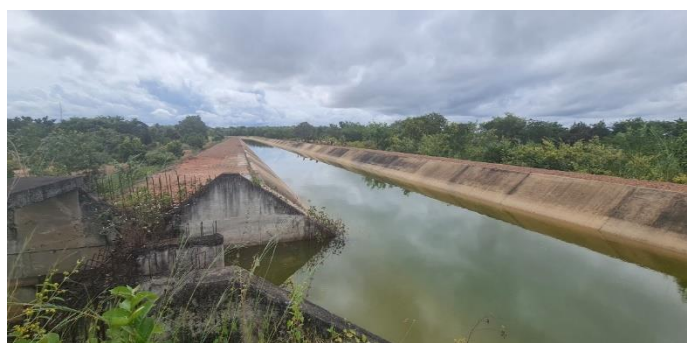
Imagem 15: Estrutura em concreto armado para o extravasor (inacabado).
