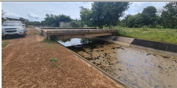
Imagem 17: As imagens acima mostram ponte sobre a seção hidráulica do canal. A estrutura em concreto armado está em boas condições, no entanto, necessita de manutenção, uma vez que, tanto o passeio, quanto as longarinas são abrigo de marimbondos.
