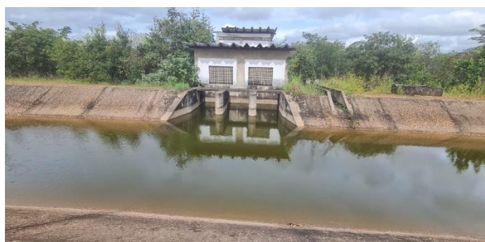
Imagem 6: Vista frontal da estrutura da tomada d'água e casa de abrigo do sistema de bombeamento que atenderá ao setor hidráulico 1 e extravasor.
