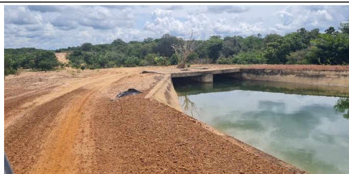
Imagem 27: Vista geral de jusante para montante da saída dupla para o segundo tramo de canal.
