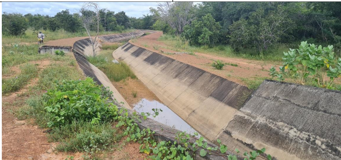
Imagem 9: Estrutura em concreto armado para instalação de comporta plana e de nível para controle de saída d'água do reservatório pulmão para o canal principal 2. Peça está, inacabada e apresentando processo de corrosão de armadura de espera iniciado.
