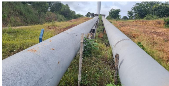
Imagem 2: Nesta imagem podem ser vistos pontos que necessitam de manutenção de pintura na adutora em funcionamento (esquerda) e com falta de solda entre módulos de tubos para finalização da outra adutora (direita).
