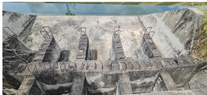
Imagem 26: Vista das armaduras de espera para instalação dos extravasores.
