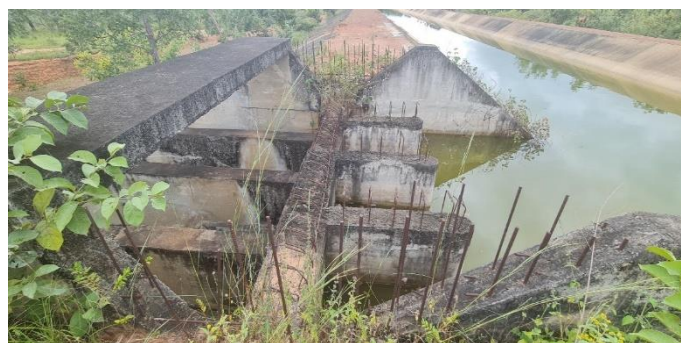
Imagem 16: Estrutura em concreto armado para instalação de extravasores na lateral esquerda do canal, próximo à edificação da casa de bombas do setor hidráulico 6.
