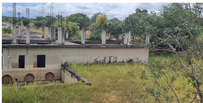
Imagem 6: Vista parcial da estrutura em concreto armado da Estação Elevatória com pilares inacabados (armadura exposta).
