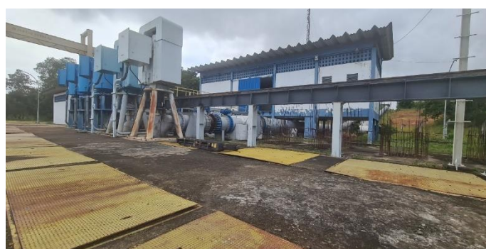
Imagem 8: Nichos para instalação de mais 4 conjuntos motor-bomba para atendimento da Primeira Etapa e Parcialmente, a Segunda Etapa do projeto.
