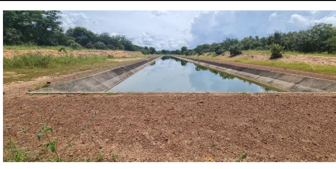
Imagem 35: A imagem mostra o final do sifão e deságue no terceiro tramo de canal para atendimento a lotes empresariais.
