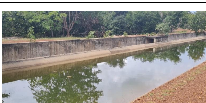
Imagem 18: As imagens acima mostram numa vista geral, a caixa na parte central para onde converge o excedente de água e também árvore crescida dentro da seção do extravasor.
