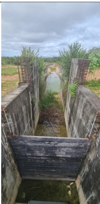
Imagem 9: Estrutura em concreto armado para instalação de comporta plana e de nível para controle de saída d'água do reservatório pulmão para o canal principal 2. Peça está, inacabada e apresentando processo de corrosão de armadura de espera iniciado.
