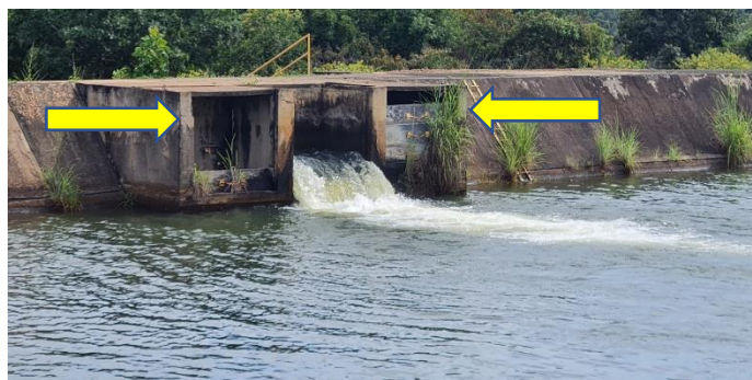
Imagem 3: Pontos de entrega de água no Reservatório Pulmão (uma em funcionamento), uma ancorada e sem funcionamento e nicho para recepção de uma terceira adutora.
