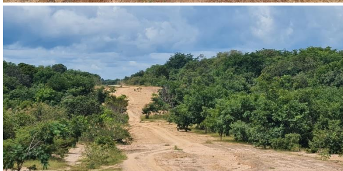
Imagem 25: Vistas por aproximação do traçado do sifão até o ponto de descarga em novo tramo de canal (montante para jusante) onde pode ser observado o talvegue por onde as águas de chuva escoam de forma natural. O terreno no traçado (deve ser aterro compactado) apresenta erosões e vegetação que necessitam de intervenção de correções e a estrada de manutenção para os tramos de canais.
