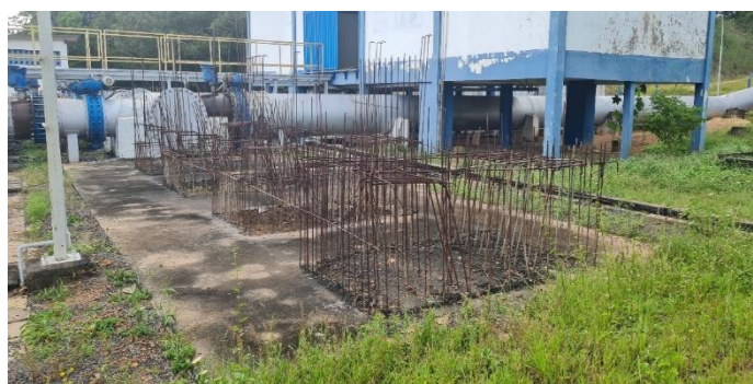
Imagem 7: Armadura para execução dos blocos de apoio para a tubulação de barrilete para as futuras 4 bombas.
