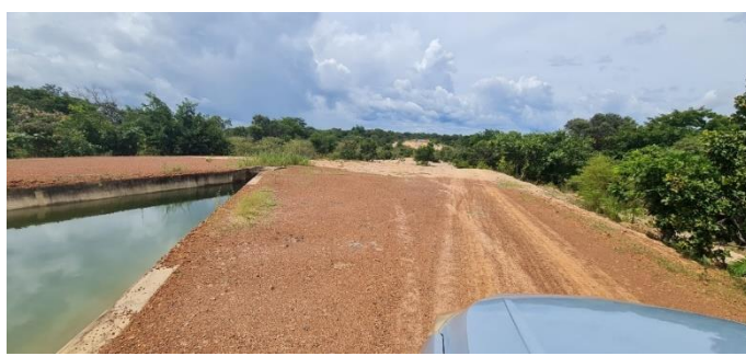
Imagem 31: Foto do final do segundo tramo de canal e estrutura em concreto armado de entrada e alinhamento do segundo sifão (enterrado) de linha única. A imagem mostra a estrutura de concreto e a estrada de terra ao lado.
