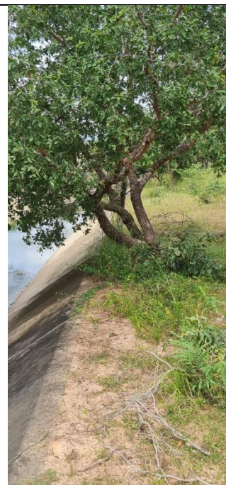
Imagem 13: As Fotografias acima mostram situações recorrentes de árvores crescidas nas bermas dos canais e muito próximas do concreto de proteção mecânica.
