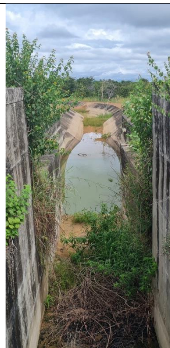
Imagem 10: Estrutura em concreto armado para instalação de comporta plana e de nível para controle de saída d'água do reservatório pulmão para o canal principal 2. Peça está, inacabada e apresentando processo de corrosão de armadura de espera iniciado
