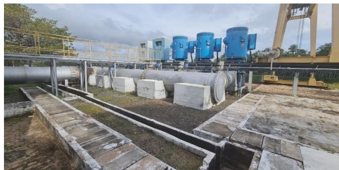
Imagem 6: Vista dos conjuntos motor-bombas e o barrilete. Os 3 conjuntos motor-bombas de cor azul escuro são as novas e duas de azul claro, são as do início da operação.
