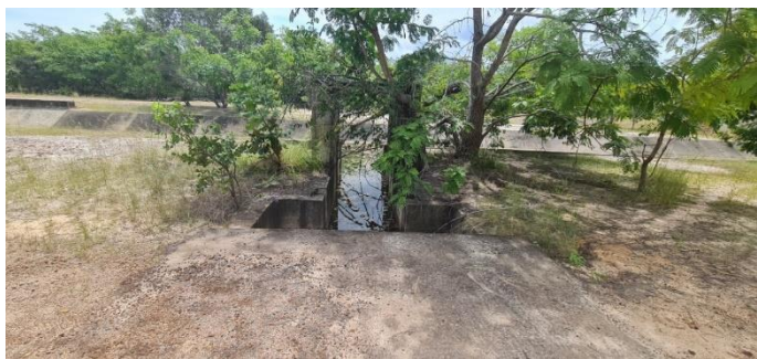
Imagem 3: A imagem, além de mostrar a estrutura em concreto armado, mostra também árvores já de grande porte, tanto junto das paredes da estrutura, quanto na berma do canal, próximo à borda deste.
