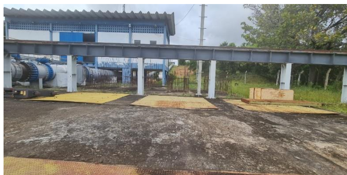
Imagem 9: Nichos para instalação de mais 4 conjuntos motor-bomba para atendimento da Primeira Etapa e Parcialmente, a Segunda Etapa do projeto.
