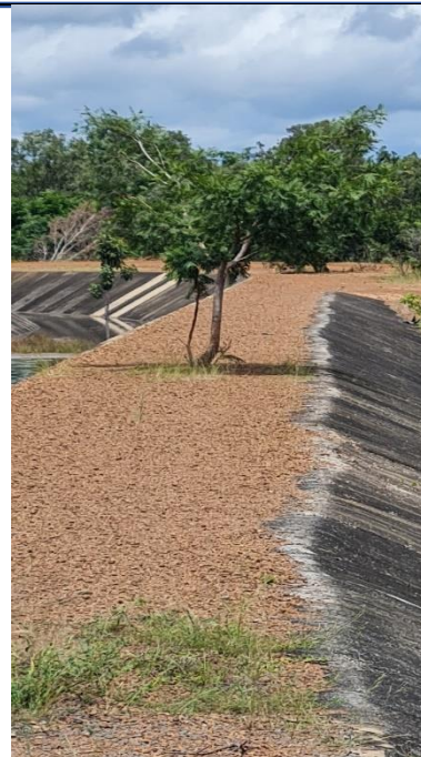
Imagem 20: Imagem mostrando a existência de árvores sobre as bermas, o que certamente em um dado momento, caso as mesmas não sejam removidas, irão provocar danos.
