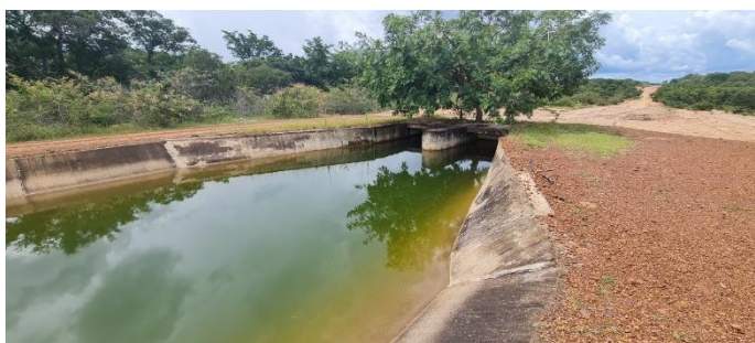
Imagem 21: Final do primeiro tramo de canal, onde pode ser observado a transição e estrutura com dupla entrada para o primeiro sifão enterrado.
