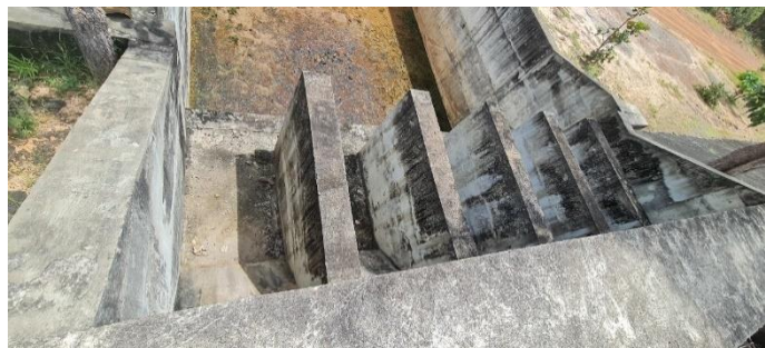
Imagem 25: Vista das paredes divisórias para o direcionamento das águas que passam por cada um dos equipamentos de passagem de águas que serão descarregadas por cada um dos extravasores a serem instalados.
