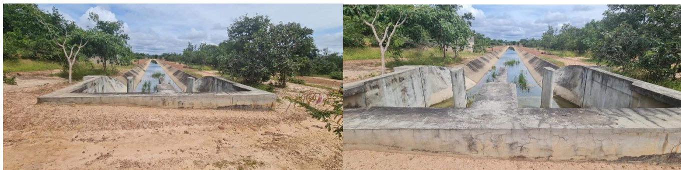
Imagem 15: Vista geral e detalhe da transição de jusante onde estão as saídas das duas adutoras que transportam água para o Canal Principal 2, na sua continuidade para atendimento de parte da segunda etapa do projeto.
