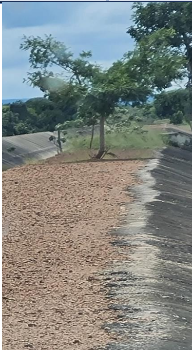
Imagem 19: Imagem mostrando a existência de árvores sobre as bermas, o que certamente em um dado momento, caso as mesmas não sejam removidas, irão provocar danos.
