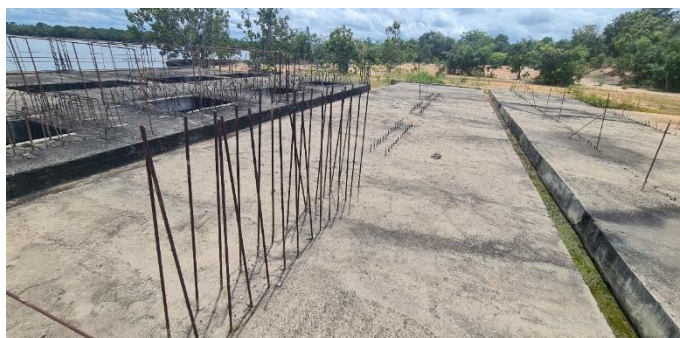
Imagem 5: Detalhe das condições em que se encontram as barras de aço. As barras de espera, já apresentam início de corrosão instalado, o que, com o passar do tempo, poderá comprometer a integridade das mesmas.
