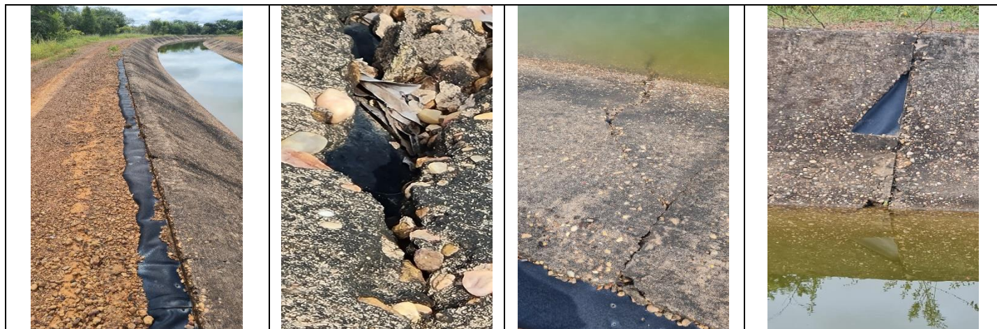
Imagem 5: As fotografias acima mostram situações observadas de falta de cobertura da geomembrana pelo revestimento da berm, fissuras e trincas, geomembrana exposta em áreas com concreto disgregado. Para estas situações, será necessário a reparação dos danos antes da operação do sistema.
