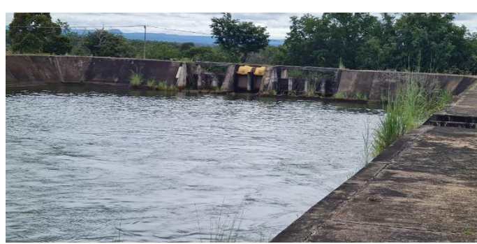
Imagem 6: Vista da área onde está instalado o extravasor do reservatório pulmão e nichos para instalação de mais dois.
