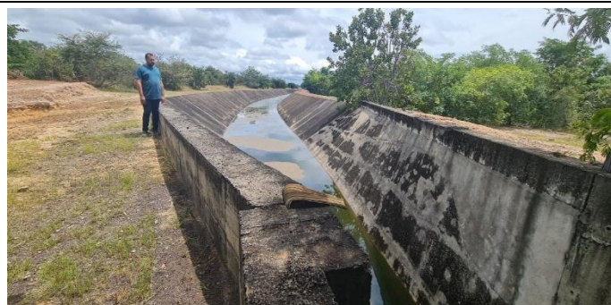
Imagem 8: Vista do canal de jusante para montante a partir da transição em concreto armado de outra estrutura para instalação de hidromecânicos de controle de nível.
