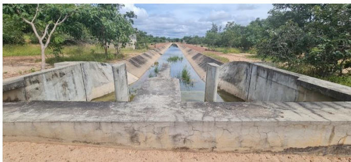
Imagem 1: Estrutura da transição de jusante das adutoras para a continuidade do segmento de Canal Principal 2, o qual atenderá parte da segunda etapa do projeto, conforme visto a seguir.
