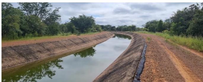
Imagem 3: Vista geral do canal para montante e jusante, onde pode ser observado a exposição da geomembrana de impermeabilização na vala de ancoragem e que não foi totalmente coberta pelo revestimento da berma. O que não há também é a proteção de meio-fio na borda do canal, elemento este, que evita a passagem de sedimentos para a seção hidráulica quando da ocorrência de chuvas, uma vez que, o revestimento está no nível da placa de concreto.
