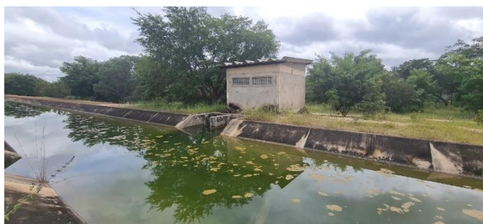
Imagem 27: Vistas de subtrechos do canal, onde pode ser observado vegetação no topo das bermas, vegetação muito próximo a estas, estruturas de tomadas d'água e casa de abrigo de bombas. As condições gerais das estruturas, é que estão em boas condições
