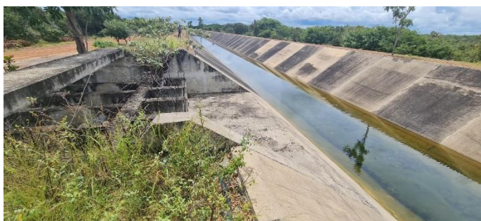
Imagem 21: A imagem acima mostra a seção hidráulica íntegra e ao lado, a estrutura em concreto armado de um extravasor.
