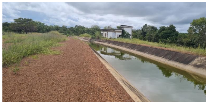
Imagem 9: Vista lateral da estrutura da tomada d'água e casa de abrigo do sistema de bombeamento que atenderá ao setor hidráulico 6.
