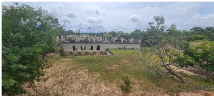
Imagem 9: Vista Geral da estrutura em concreto armado da Estação Elevatória inacabada.
