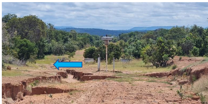
Imagem 6: Esta imagem mostra as erosões e, no alinhamento da seta azul, há uma saída d'água para a esquerda e a partir deste ponto as erosões são minimizadas até chegar à área da estação de bombeamento.
