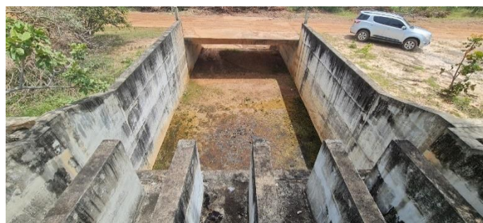
Imagem 24: Vista do canal em concreto armado, da saída do extravasor, o qual, cruza a estrada paralela ao canal.
