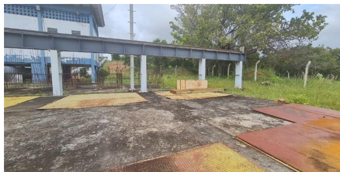
Imagem 10: Nichos para instalação de mais 4 conjuntos motor-bomba para atendimento da Primeira Etapa e Parcialmente, a Segunda Etapa do projeto.
