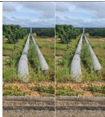
Imagem 14: Vista geral de jusante para montante, das duas adutoras, onde pode ser observado o bloco de ancoragem das mesmas ao reservatório pulmão.
