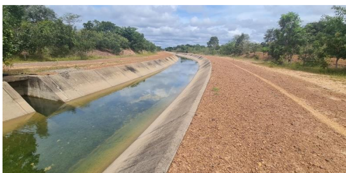
Imagem 3: Continuação do segmento do Canal Principal 2, com concreto de proteção mecânica em boas condições, bermas revestidas com solo laterítico, apresenta também alguns pontos com ensecadeiras em solo não removidas, sedimentos e vegetação aquática no fundo do canal.
