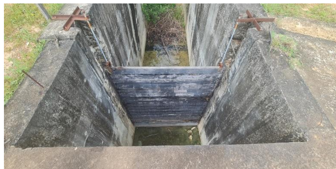
Imagem 6: Vista da área onde está instalado o extravasor do reservatório pulmão e nichos para instalação de mais dois.
