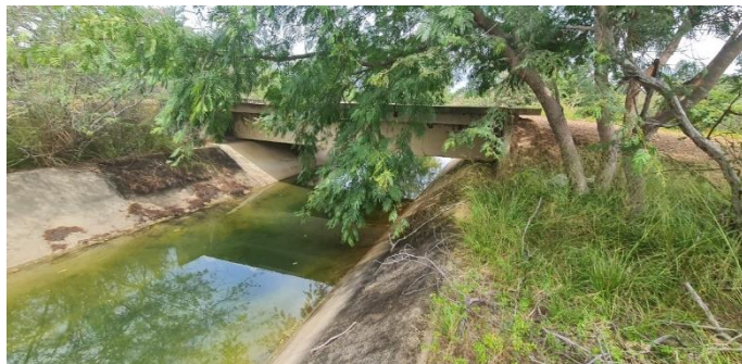
Imagem 11: As Fotografias acima mostram situações recorrentes de árvores crescidas nas bermas dos canais e muito próximas do concreto de proteção mecânica.
