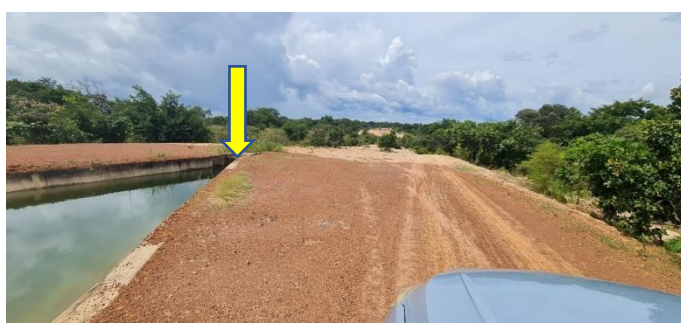
Imagem 33: Foto do final do segundo tramo de canal e estrutura em concreto armado de entrada e alinhamento do segundo sifão (enterrado) de linha única. A imagem mostra a estrutura de concreto e a estrada de terra ao lado.
