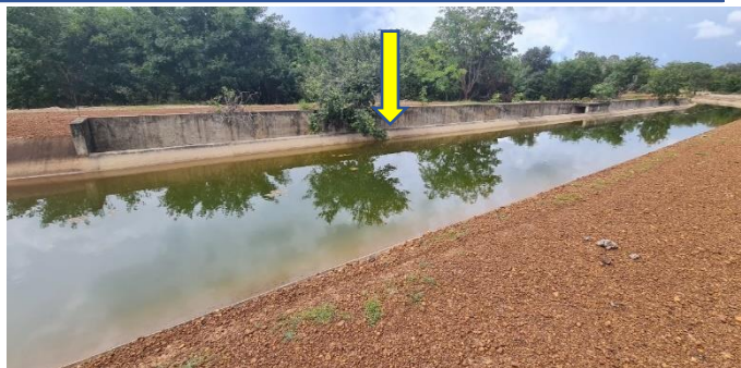
Imagem 20: Vista geral do extravasor construído em concreto armado na margem esquerda do canal em bom estado de conservação. Água no canal bem próximo da cota da ogiva de sangria.
