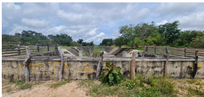
Imagem 2: Vista da estrutura em concreto armado, onde há o desagüe das águas para o Canal Principal (de montante para jusante).
