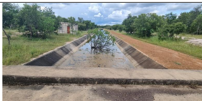
Imagem 16: A imagem mostra ponto com assoreamento e árvore crescida dentro da seção hidráulica. Nesta situação, como não é possível visualizar, pode já está acontecendo das raízes da árvore penetrar por entre as placas de concreto e provocar danos.
