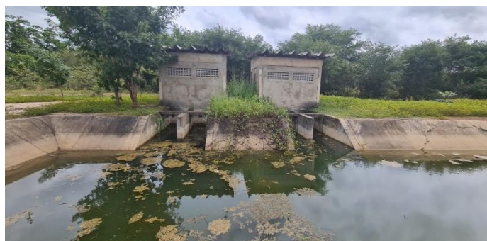
Imagem 15: Tomadas d'água em concreto armado e casa de abrigo de bombas para lotes empresariais na parte final do segmento de canal.
