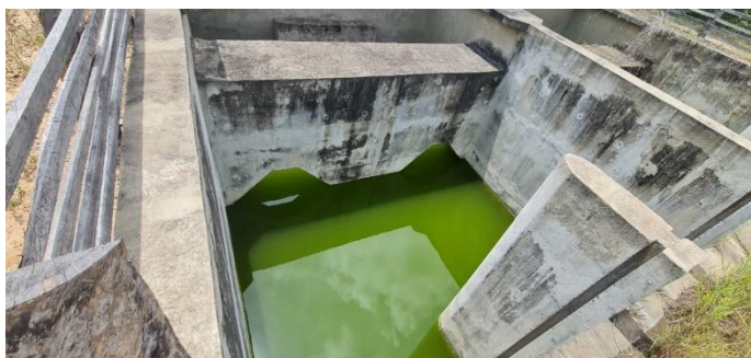
Imagem 5: Vista interna da baia do lado direito onde se observa a estrutura em concreto armado em bom estado de conservação (paredes, chicana e ogiva).
