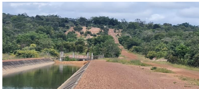
Imagem 10: Vista Geral (montante para jusante) do final do canal até a Estação Elevatória e o desnível a ser vencido com o bombeamento para o nível superior onde, a partir da transição de jusante das adutoras instaladas, o sistema será todo gravitatório.
