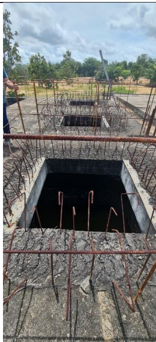
Imagem 5: Detalhe das condições em que se encontram as barras de aço. As barras de espera, já apresentam início de corrosão instalado, o que, com o passar do tempo, poderá comprometer a integridade das mesmas.
