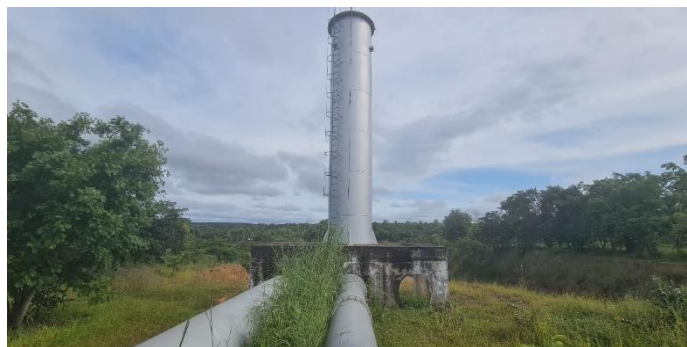
Imagem 3: Esta imagem, mostra as condições em que se encontra a chaminé de equilíbrio em relação à manutenção e pintura.
