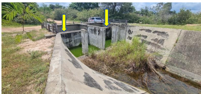
Imagem 3: Vista da estrutura em concreto armado de jusante para montante, onde pode ser visto as duas baias de saída d'água das adutoras. A imagem mostra ainda assoreamento e vegetação na transição para o canal principal.
