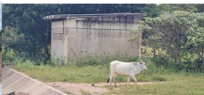
Imagem 14: As imagens acima mostram a estrutura de tomada d'água e casa de abrigo de bombas. As casas construídas em estrutura de concreto armado e alvenaria, coberturas com estrutura de madeira e telhas de fibrocimento, encontram-se deterioradas e árvores crescidas muito junto destas unidades, necessitando de urgente manutenção.
