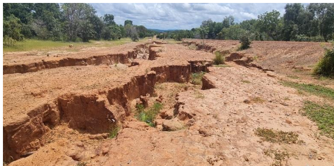
Imagem 7: As imagens acima mostram a partir da foto 12, que (no declive do terreno) há erosões com profundidades variáveis, muito preocupantes e que merecem intervenção imediata. No entanto, as adutoras ainda não são visíveis no fundo das cavas.
