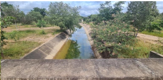
Imagem 11: As Fotografias acima mostram situações recorrentes de árvores crescidas nas bermas dos canais e muito próximas do concreto de proteção mecânica.
