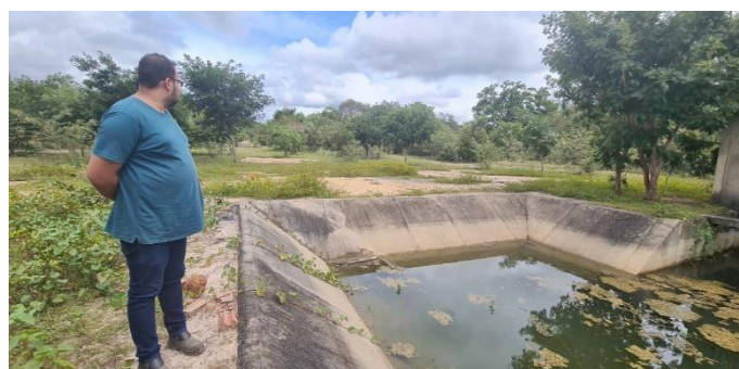
Imagem 16: Foto evidenciando o final do Canal Principal 2, o qual parte do Reservatório Pulmão para atendimento da primeira etapa e parcialmente à segunda etapa do projeto.
