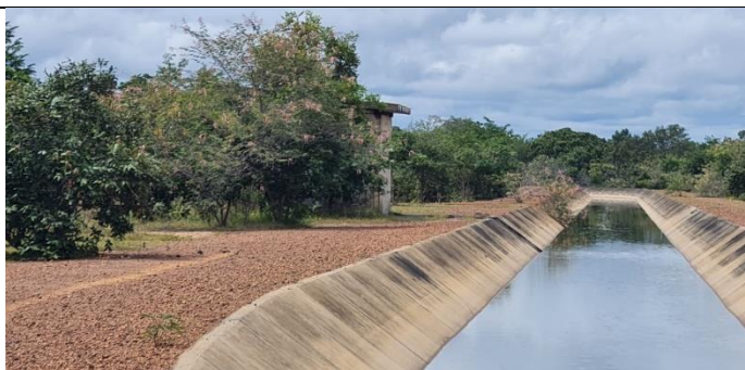
Imagem 3: Continuação do segmento do Canal Principal 2, com concreto de proteção mecânica em boas condições, bermas revestidas com solo laterítico, apresenta também alguns pontos com ensecadeiras em solo não removidas, sedimentos e vegetação aquática no fundo do canal.
