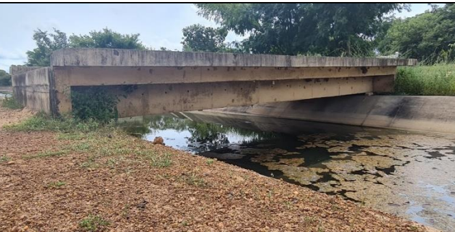
Imagem 17: As imagens acima mostram ponte sobre a seção hidráulica do canal. A estrutura em concreto armado está em boas condições, no entanto, necessita de manutenção, uma vez que, tanto o passeio, quanto as longarinas são abrigo de marimbondos.
