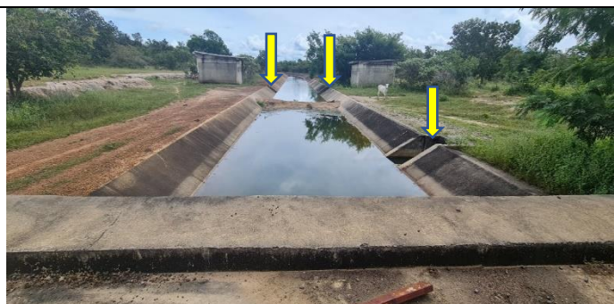
Imagem 15: A imagem mostra tomada d'água sem casa de abrigo de bombas e tomadas d'água com casas de abrigo de bombas nas laterais do canal. As estruturas (tomada d'água) em concreto armado para lotes empresariais, estão em boas condições.
