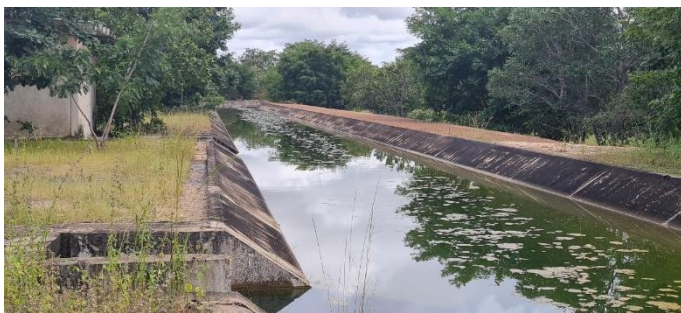
Imagem 27: Vistas de subtrechos do canal, onde pode ser observado vegetação no topo das bermas, vegetação muito próximo a estas, estruturas de tomadas d'água e casa de abrigo de bombas. As condições gerais das estruturas, é que estão em boas condições
