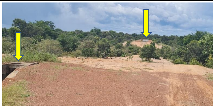
Imagem 34: A imagem vista de montante para jusante, mostra o início e final do traçado e o talvegue onde passa o segundo sifão enterrado (linha simples). Na imagem observa-se vegetação que deve ser removida deixando o traçado limpo e em condições de tráfego para a realização de manutenção das obras.
