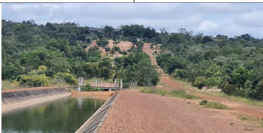
Imagem 19: Final da primeira etapa do segmento de canal (CP-2) que chega até a Estrutura da Estação Elevatória para alimentação de parte da Segunda Etapa do projeto. Elevação do terreno natural ao fundo para continuidade da segunda etapa do segmento de canal.
