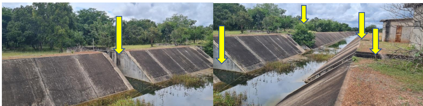
Imagem 17: As duas imagens acima mostram as estruturas em concreto armado das tomadas d'água, sedimentos e vegetação na base do canal, como também, árvore crescida dentro de uma das estruturas.
