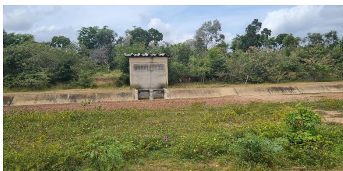
Imagem 6: Tomada d'água e abrigo de bombas na margem do canal.
