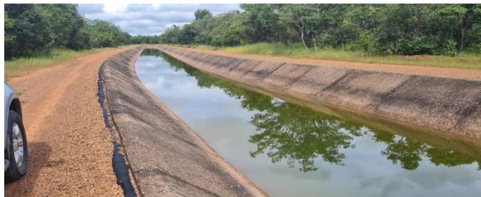
Imagem 4: Vista geral do canal para montante e jusante, onde pode ser observado a exposição da geomembrana de impermeabilização na vala de ancoragem e que não foi totalmente coberta pelo revestimento da berma. O que não há também é a proteção de meio-fio na borda do canal, elemento este, que evita a passagem de sedimentos para a seção hidráulica quando da ocorrência de chuvas, uma vez que, o revestimento está no nível da placa de concreto.
