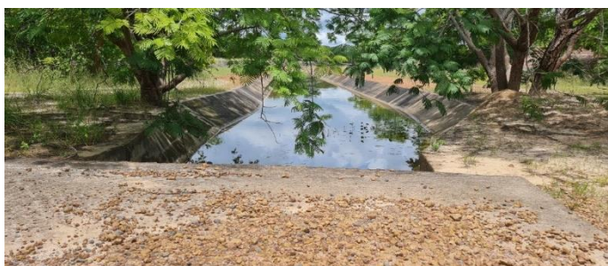
Imagem 5: Vista do canal secundário a partir da ponte mostrada na foto 4. Pode-se observar árvores de grande porte junto à estrutura de transição em concreto armado para o segmento de canal, com proteção mecânica em concreto simples.
