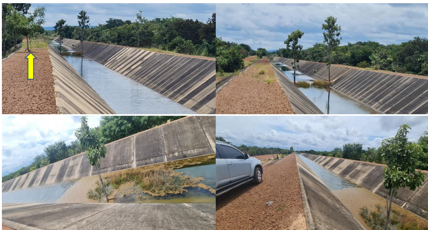
Imagem 18: As imagens acima mostram que, além de haver árvore na berma, há também, dentro da seção hidráulica. Como não é visível a base do canal, não se pode afirmar que haja comprometimento da geomembrana de impermeabilização, dreno de fundo e proteção mecânica na área onde estão inseridas as árvores. No entanto, as raízes podem estar passando por entre as junções das placas e provocando danos à estrutura do canal.
