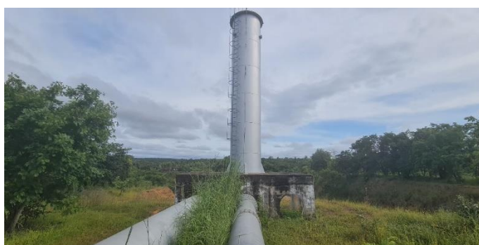
Imagem 12: Chaminé de equilíbrio centralizada na estrutura de ancoragem das duas adutoras e nicho para uma terceira.
