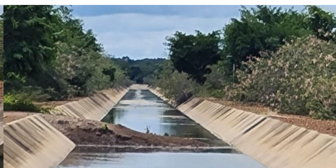
Imagem 14: As fotografias acima vistas de jusante para montante do final do canal principal 2, evidenciam vegetação densa nas bermas do canal, vegetação esta que, com o passar do tempo e em não sendo removida juntamente com as raízes, certamente irão provocar danos nas bermas, geomembrana de impermeabilização e proteção mecânica do canal.
