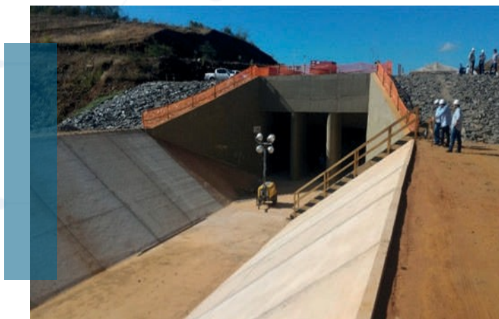
Cinturão das Águas/CE – Trecho 1
