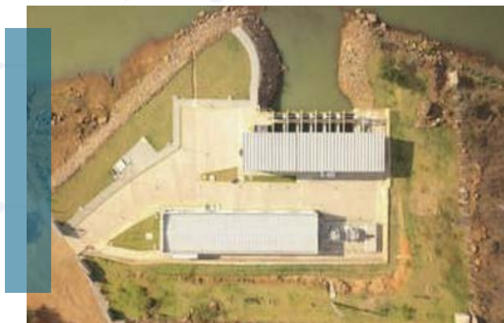
Adutora do Agreste/PE
