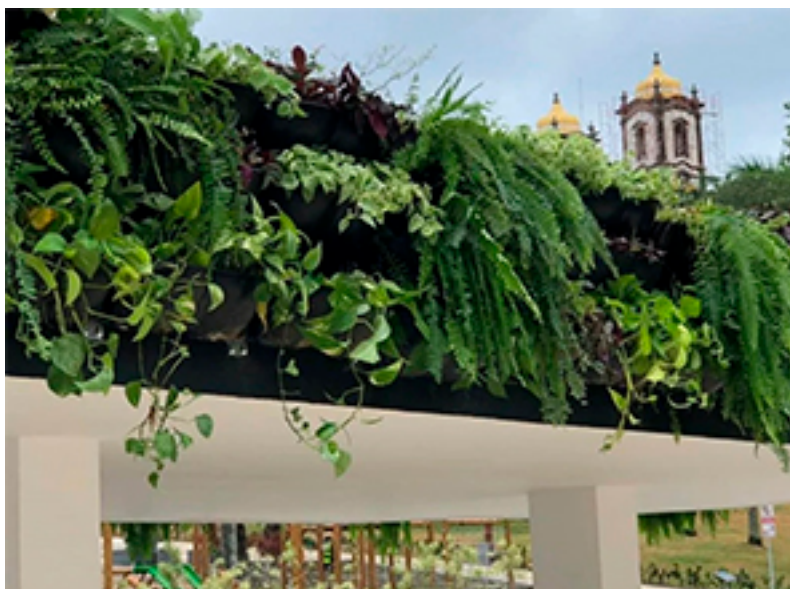
Telhado Verde em Salvador, BA.
