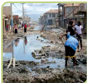
Falta de infraestrutura básica (saneamento, drenagem, transporte).
