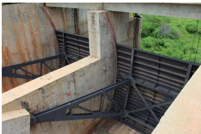
Figura 17-11 - Barragem Ávidos – Comportas do vertedouro
