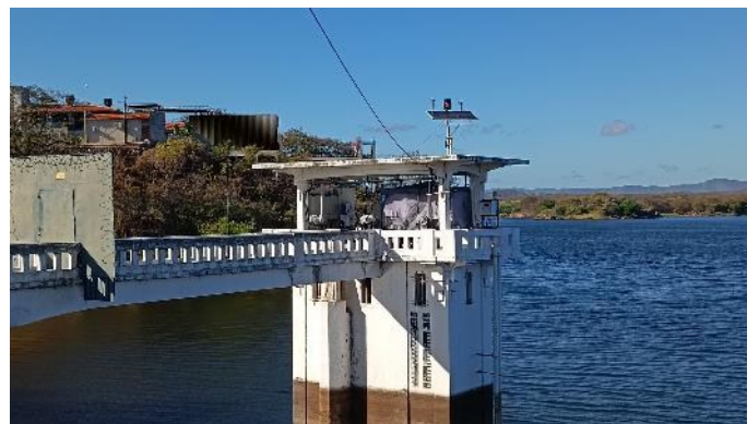
Figura 18-11 - Barragem São Gonçalo – Torre da Tomada d'água
