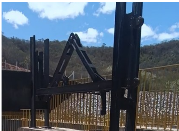
Figura 15-53 - Estrutura de Controle Boa Vista – Viga pescadora
