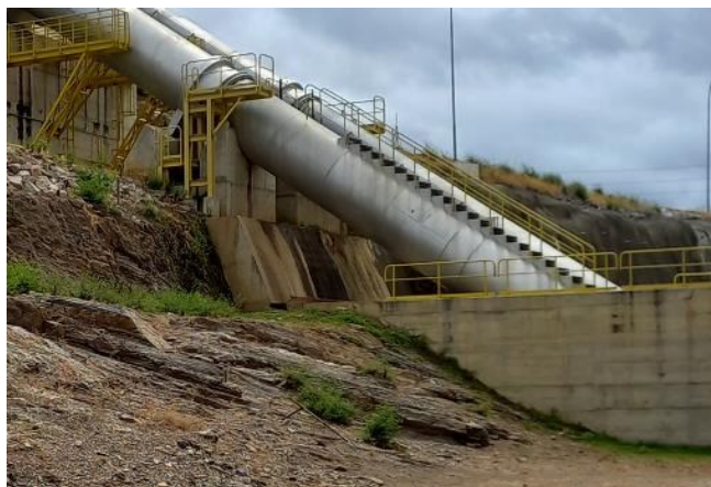
Figura 25-42 – EBI-1 – Tubulação de recalque
