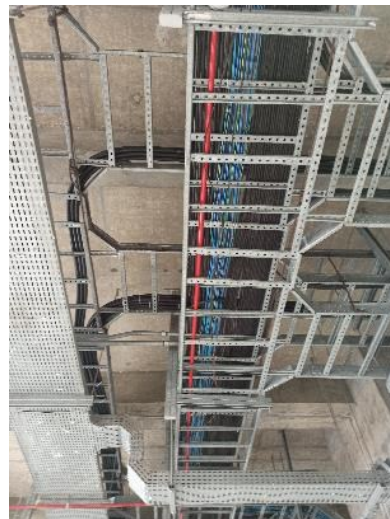
Figura 27-49 – EBI-3 – Cabos em Eletroleitos
