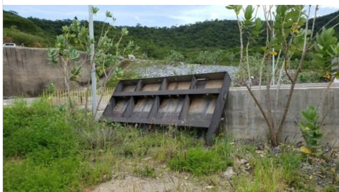
Figura 15-39 - Estrutura de Controle Boa Vista – Comporta stop-log
