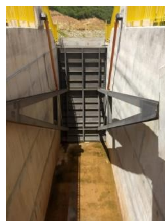
Figura 13-42 - Estrutura de Controle Bois – Comporta
