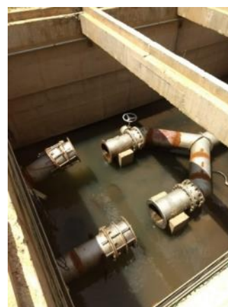
Figura 16-14 - Barragem Caiçara – Válvula Dispersora
