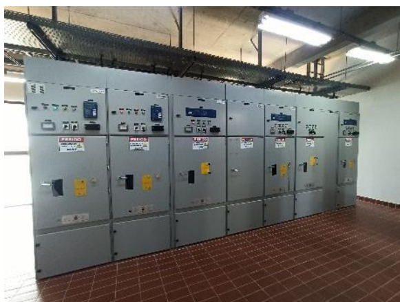
Figura 25-33 – EBI-1 – Painéis de Média Tensão
