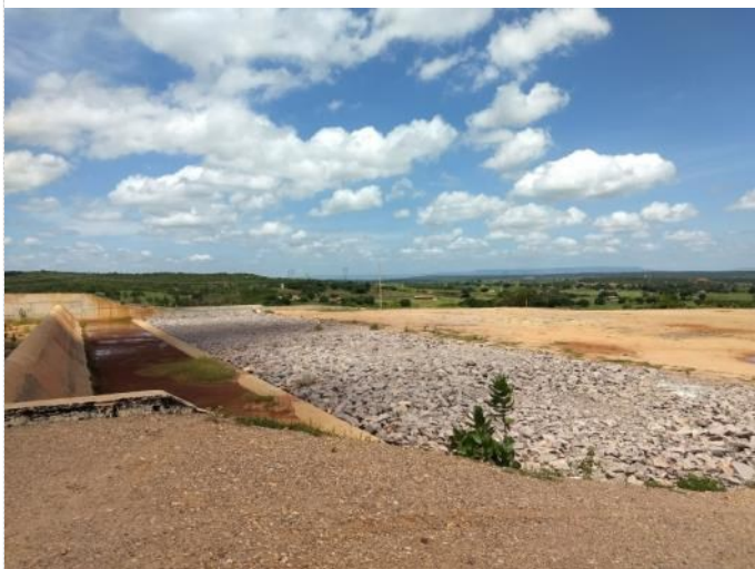
Figura 13-15 - Barragem Bois – Canal de Restituição do vertedor
