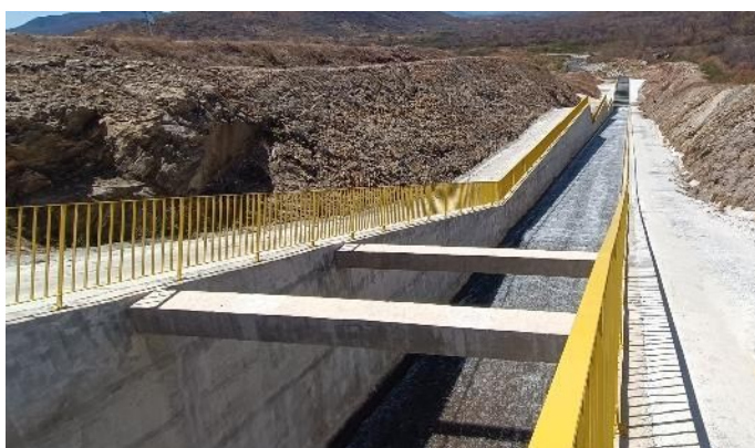
Figura 22-7 – Canal Rápido – Entrada
