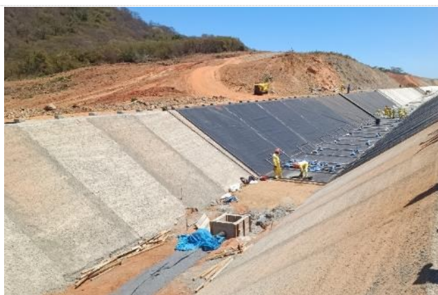
Figura 28-1 – Execução de canal
