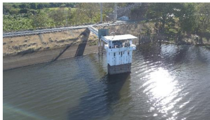
Figura 18-6 – Barragem São Gonçalo – Torre da Tomada d'água
