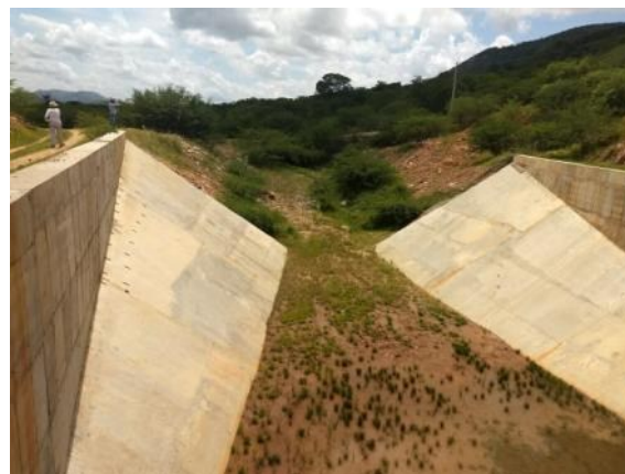
Figura 16-36 - Estrutura de Controle Caiçara – Canal de Saída
