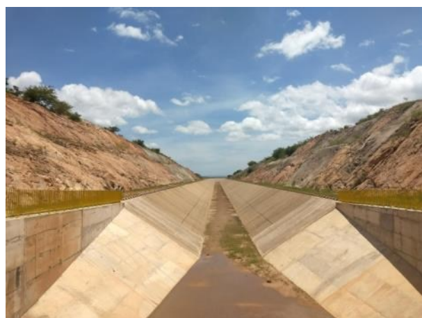
Figura 13-36 - Estrutura de Controle Bois – Canal de Saída
