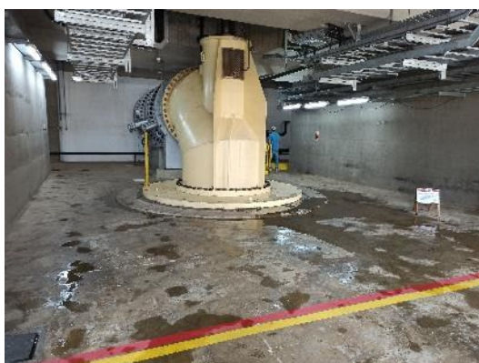
Figura 26-35 – EBI-2 – Vazamento MB02
