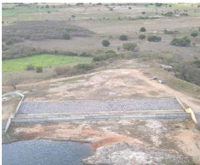
Figura 13-29 - Barragem Bois – Canal de Restituição do vertedor
