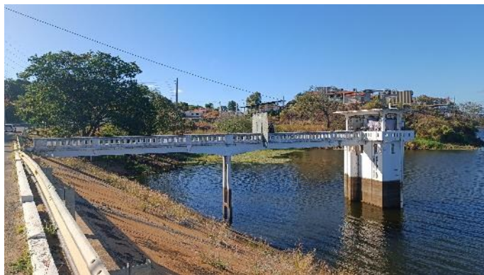
Figura 18-10 – Barragem São Gonçalo – Torre da Tomada d'água
