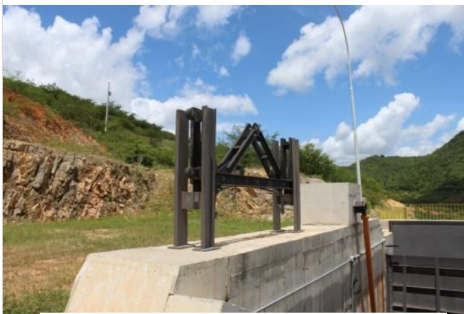
Figura 16-37 - Estrutura de Controle Caiçara – Viga Pescadora
