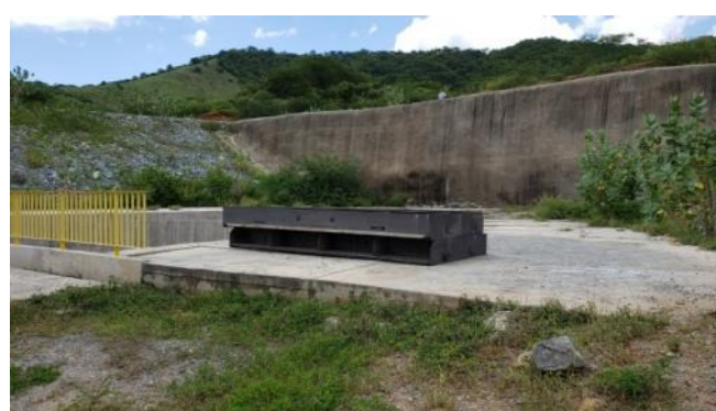
Figura 15-40 - Estrutura de Controle Boa Vista – Comporta stop-log
