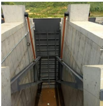
Figura 16-39 - Estrutura de Controle Caiçara - Comporta
