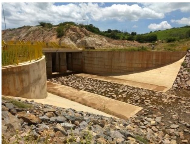
Figura 13-33 - Estrutura de Controle Bois – Canal de Entrada
