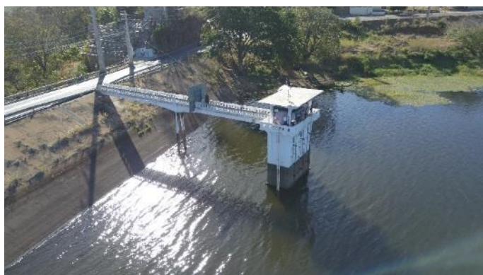
Figura 18-5 – Barragem São Gonçalo – Torre da Tomada d'água
