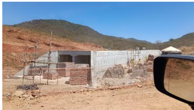
Figura 28-4 – Execução de Bueiro
