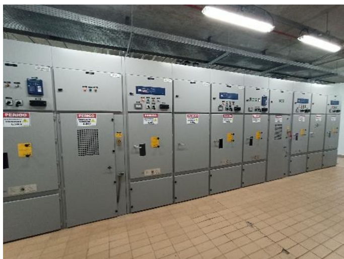
Figura 27-48 – EBI-3 – Painéis de Média Tensão
