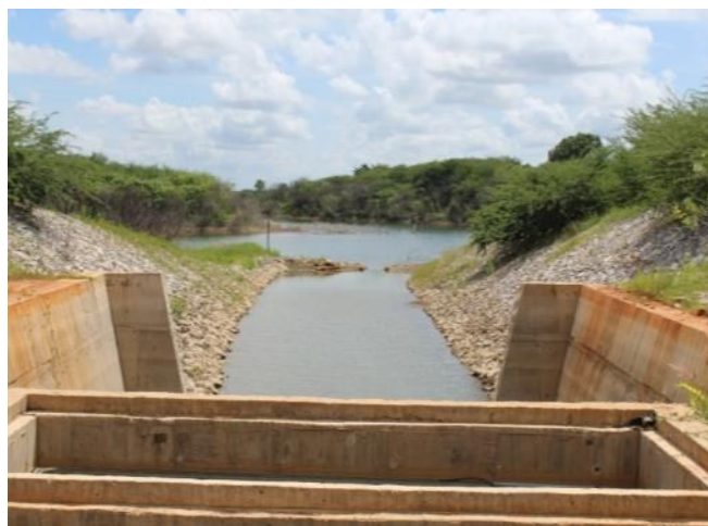
Figura 16-34 - Estrutura de Controle Caiçara – Canal de Entrada
