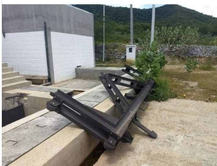
Figura 21-11 – Túnel Cuncas II – Viga pescadora
