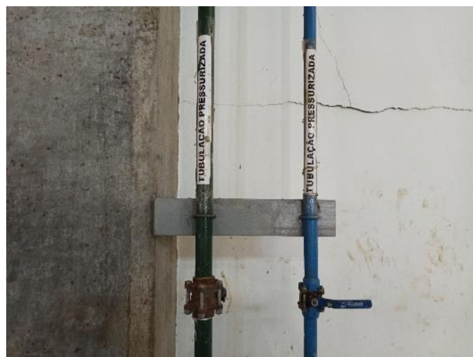
Figura 27-53 – EBI-3 – Tubulação Pressurizada
