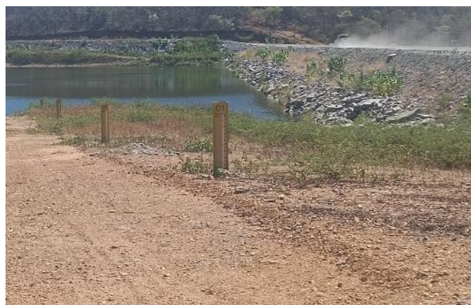
Figura 14-26 - Barragem Morros – Régua de nível de NA
