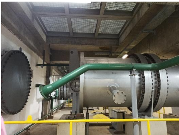
Figura 27-52 – EBI-3 – Conduto MB-02 Desacoplado
