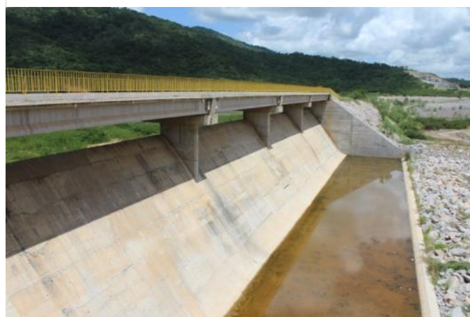
Figura 16-16 - Barragem Caiçara – Vertedor
