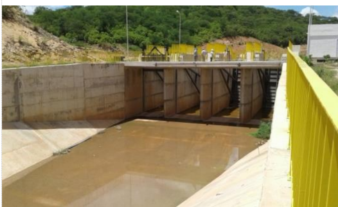
Figura 13-35 - Estrutura de Controle Bois – Canal de Saída
