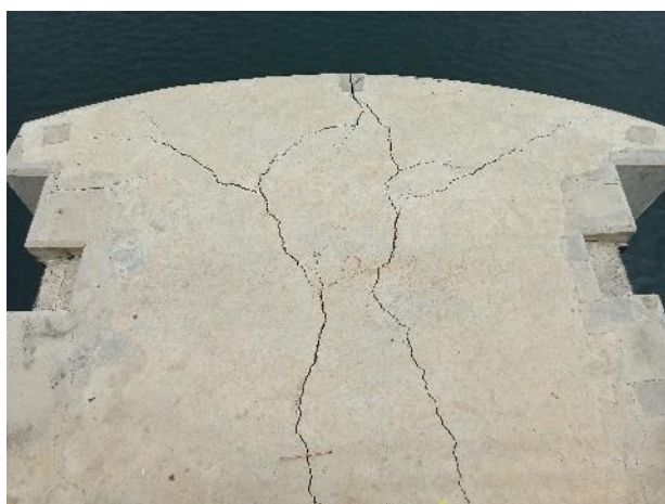
Figura 26-33 – EBI-2 – Rachadura piso junto a Comportas
