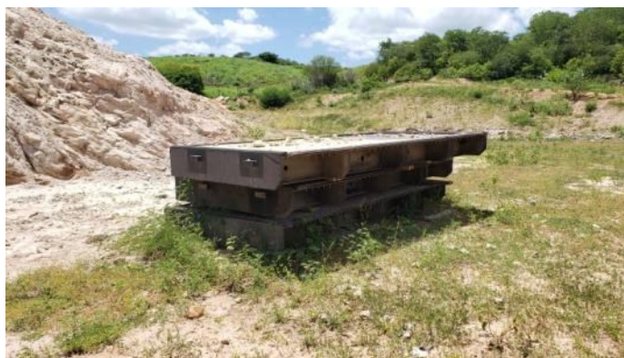
Figura 13-43 - Estrutura de Controle Bois – Comportas stop-log
