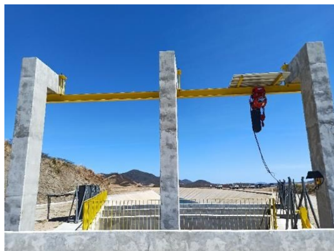
Figura 22-10 – Canal Rápido – Talha Elétrica
