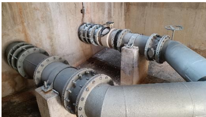
Figura 15-33 - Barragem Boa Vista – Válvula Dispersora
