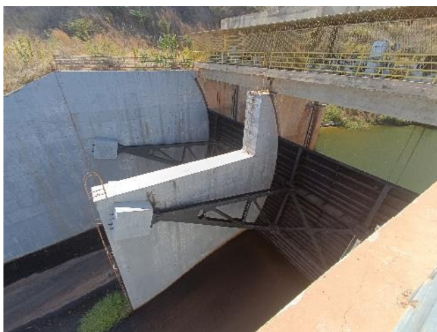
Figura 17-21 - Barragem Ávidos – Comportas do vertedouro
