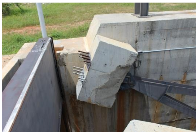
Figura 16-44 - Estrutura de Controle Caiçara - Viga Munhão
