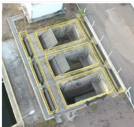
Figura 10-64 - Estrutura de Controle Porcos - Comportas stop-log
