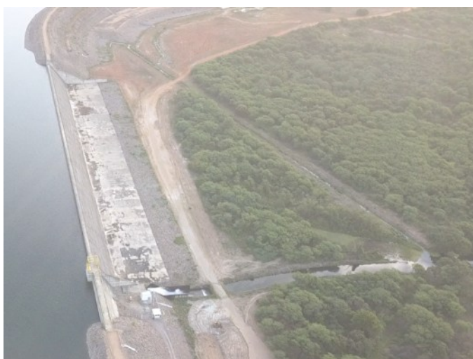
Figura 10-33 - Barragem Porcos – Canal de Restituição do Vertedor
