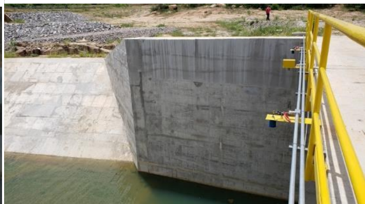
Figura 6-44 – Estrutura de Controle Negreiros – Medidores de vazão
