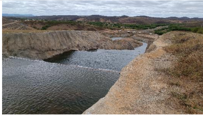
Figura 8-28 – Barragem Jati - Recorte na soleira do vertedouro
