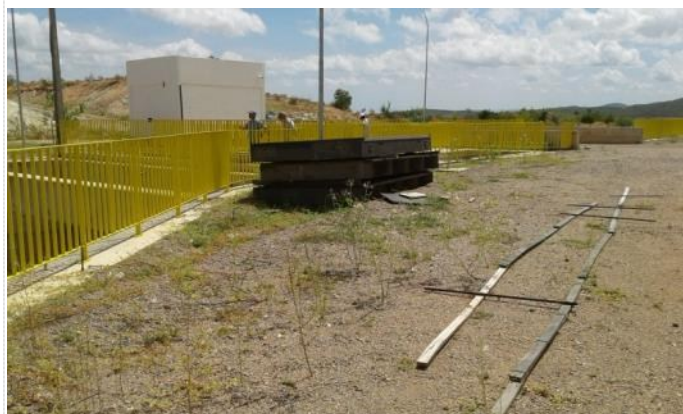
Figura 10-46 - Estrutura de Controle Porcos – Comportas stop-log
