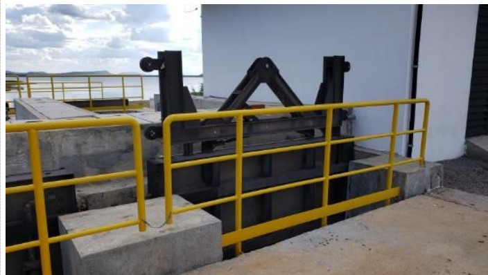
Figura 4-41 – Barragem Serra do Livramento - Viga Pescadora
