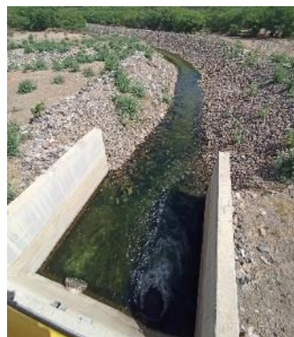
Figura 3-33 – Barragem Terra Nova - Canal de Restituição da TUD
