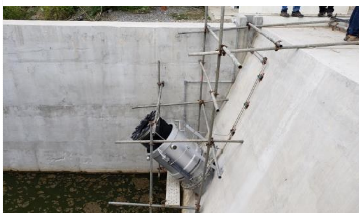
Figura 2-17 – Barragem Tucutu - Válvula Dispersora
