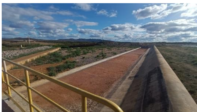
Figura 5-36 – Barragem Mangueira - Vertedor
