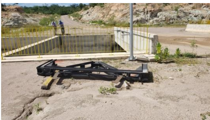
Figura 10-45 - Estrutura de Controle Porcos – Viga pescadora
