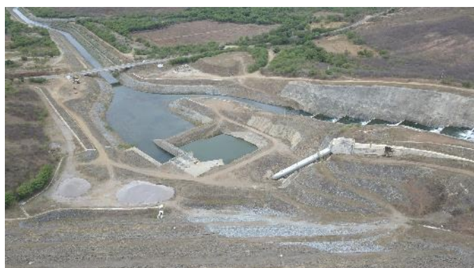
Figura 8-32 – Barragem Jati - Canal de restituição do vertedouro
