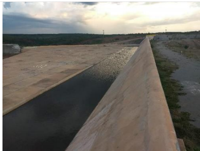
Figura 8-14 – Barragem Jati - Soleira do vertedouro
