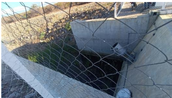
Figura 2-36 – Barragem Tucutu - Válvula Dispersora
