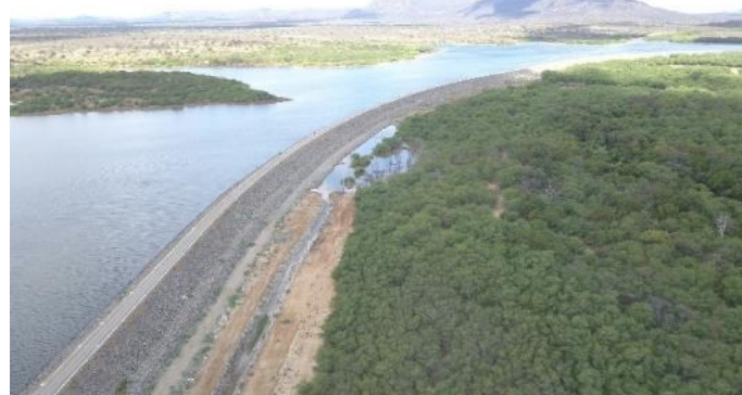
Figura 3-23 – Barragem Terra Nova - Talude de Jusante
