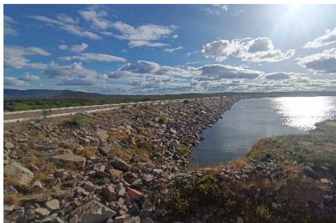
Figura 5-27 – Barragem Mangueira - Talude de Montante
