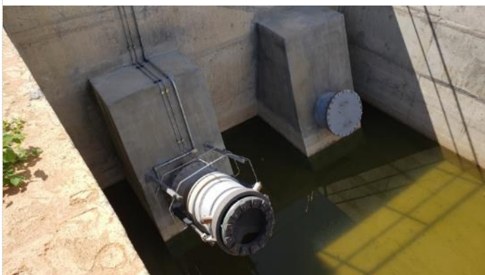
Figura 5-13 – Barragem Mangueira - Válvula Dispersora
