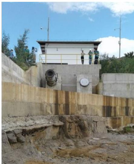
Figura 4-15 – Barragem Serra do Livramento - Válvula Dispersora
