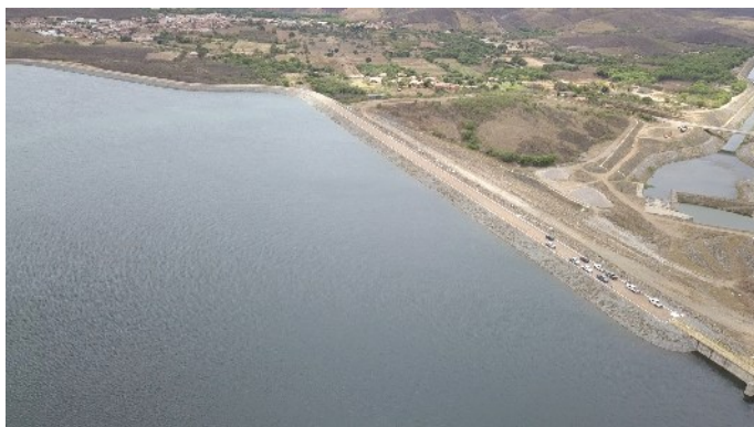
Figura 8-19 – Barragem Jati - Talude de montante
