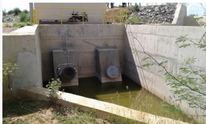
Figura 5-14 – Barragem Mangueira - Válvula Dispersora
