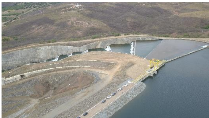
Figura 8-31 – Barragem Jati – Canal de restituição do vertedouro
