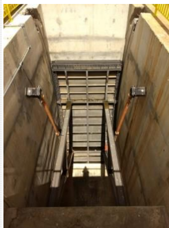
Figura 10-48 - Estrutura de Controle Porcos – Comporta
