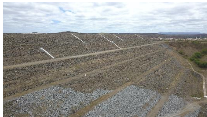
Figura 8-20 – Barragem Jati - Talude de jusante
