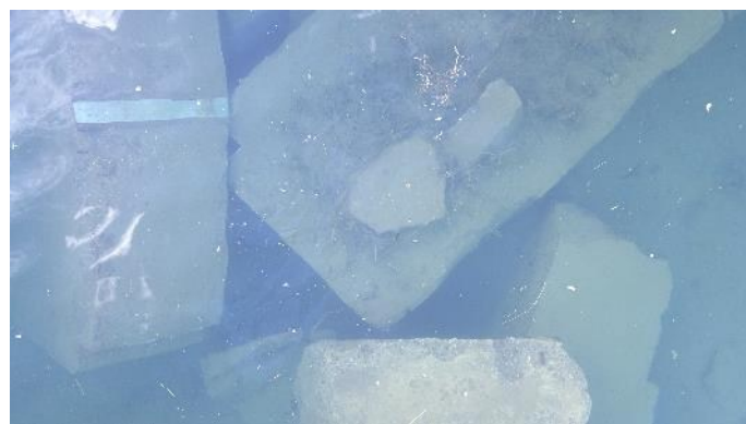
Figura 6-60 –Estrutura de Controle Negreiros – Detritos no canal
