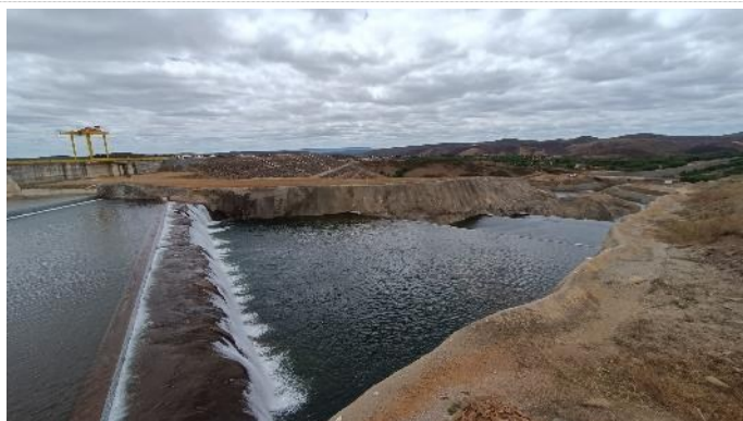
Figura 8-27 – Barragem Jati - Recorte na soleira do vertedouro
