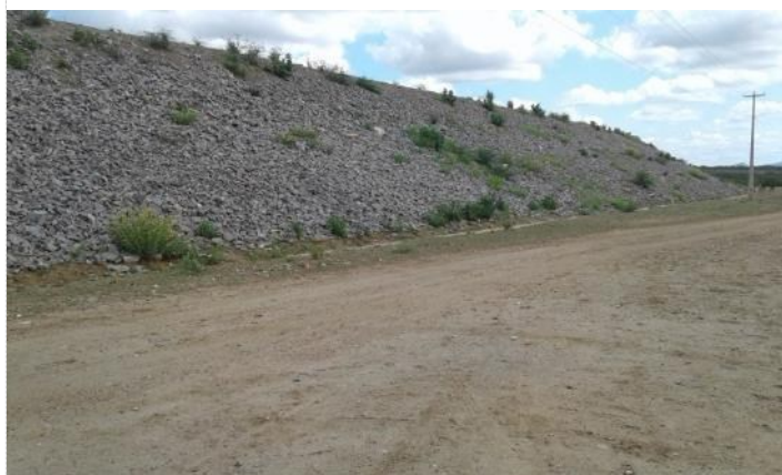
Figura 2-13 – Barragem Tucutu - Talude de Jusante
