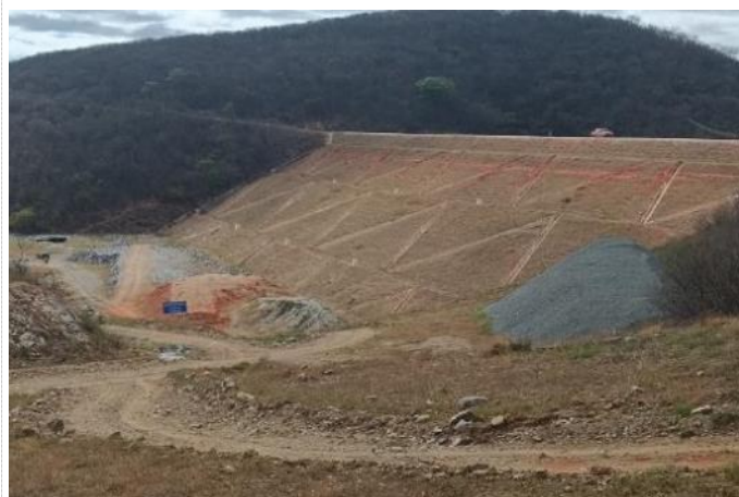
Figura 9-36 - Barragem Atalho – Talude de jusante
