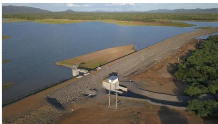
Figura 3-5 – Barragem Terra Nova - Torre da TUD
