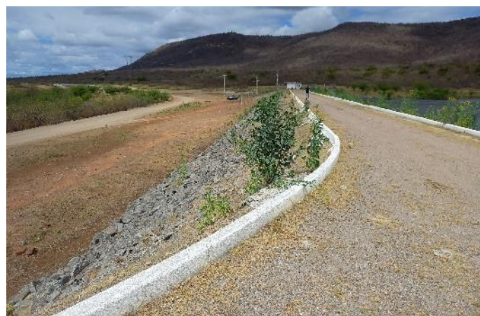
Figura 4-27 – Barragem Serra do Livramento - Talude de Jusante
