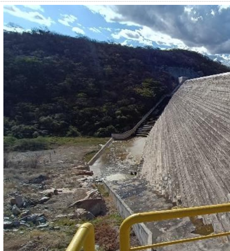
Figura 6-26 – Barragem Negreiros - Canal de Restituição do Vertedor
