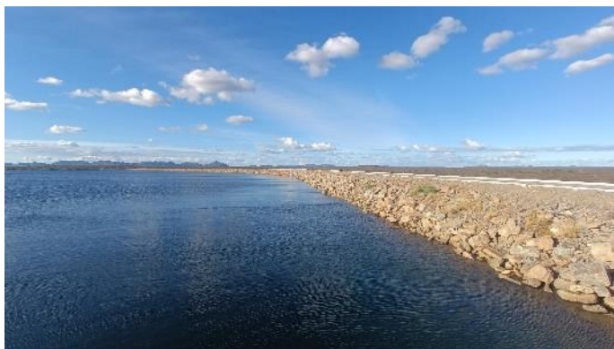
Figura 2-30 – Barragem Tucutu - talude de Montante
