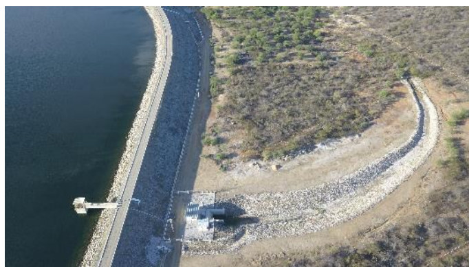
Figura 2-37 – Barragem Tucutu - Canal de Restituição da TUD
