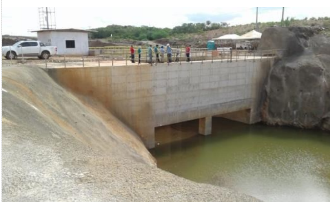
Figura 7-37 - Estrutura de Controle Milagres – Canal de Saída
