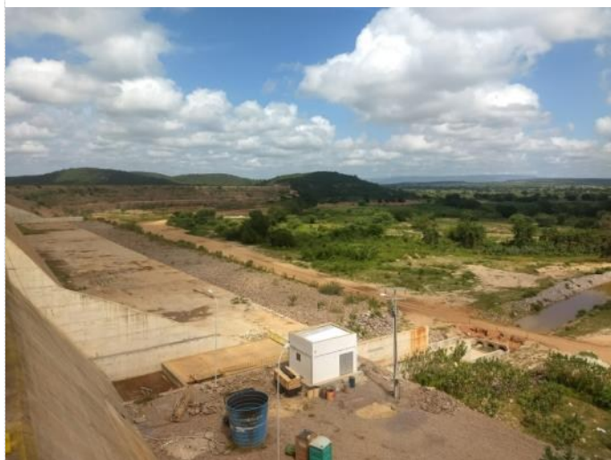
Figura 10-15 - Barragem Porcos – Canal de Restituição do Vertedor
