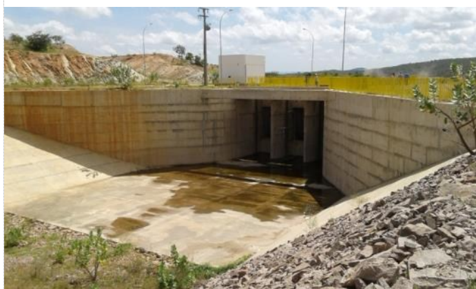
Figura 10-37 - Estrutura de Controle Porcos – Canal de Entrada
