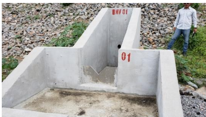
Figura 2-15 – Barragem Tucutu – Medidor de Vazão
