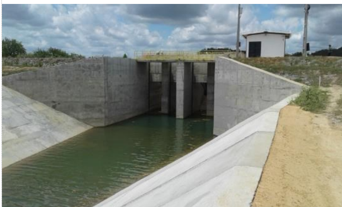
Figura 6-47 – Estrutura de Controle Negreiros – Canal de Saída
