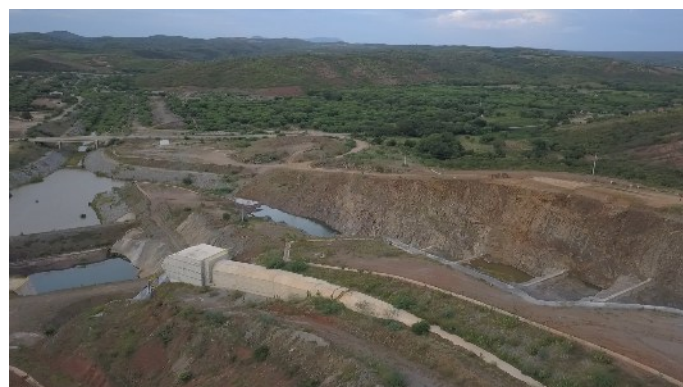
Figura 8-16 – Barragem Jati - Canal de restituição do vertedouro
