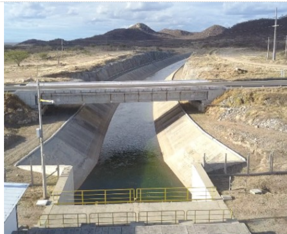
Figura 6-62 – Estrutura de Controle Negreiros - Canal de Saída
