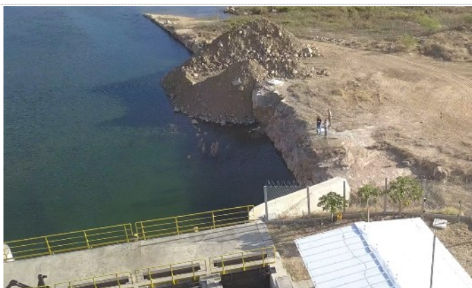
Figura 6-59 – Estrutura de Controle Negreiros – Canal de entrada
