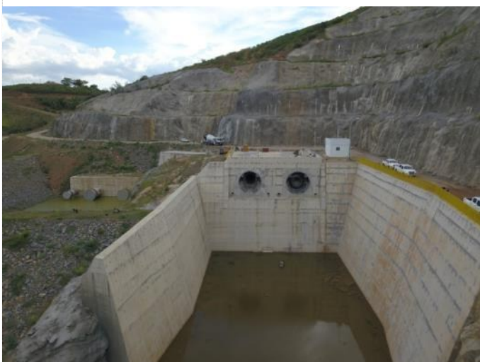
Figura 9-13 - Barragem Atalho – Válvula Dispersora
