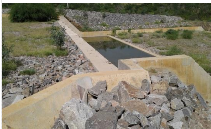
Figura 5-15 – Barragem Mangueira - Canal de Restituição do Vertedor
