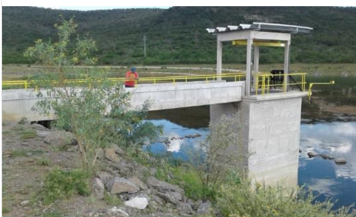
Figura 4-7 – Barragem Serra do Livramento - Torre da TUD
