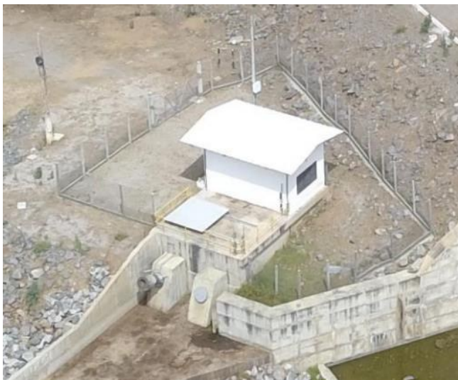
Figura 4-32 – Barragem Serra do Livramento - Válvula Dispersora
