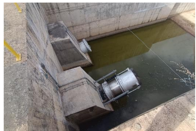
Figura 5-31 – Barragem Mangueira - Válvula Dispersora
