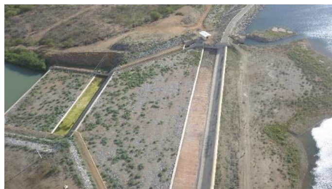
Figura 5-37 – Barragem Mangueira - Canal de Restituição do Vertedor
