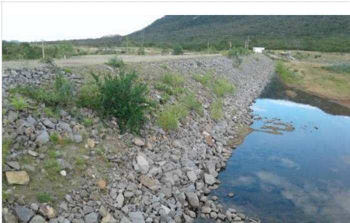
Figura 4-9 – Barragem Serra do Livramento - Talude de Montante
