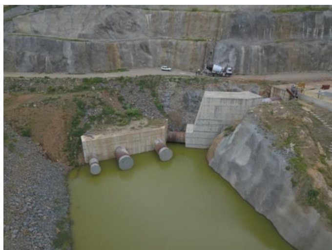
Figura 9-15 - Barragem Atalho – Tubulação de espera da PCH
