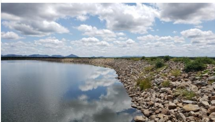
Figura 2-11 – Barragem Tucutu - talude de Montante
