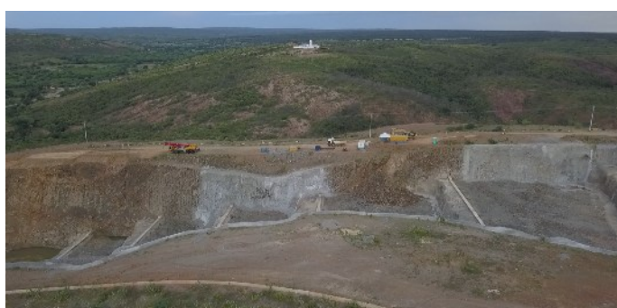
Figura 8-13 – Barragem Jati - Soleira do vertedouro
