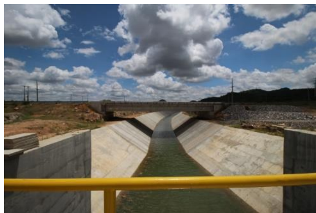
Figura 6-48 – Estrutura de Controle Negreiros - Canal de Saída
