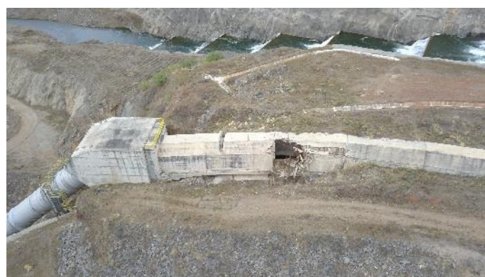
Figura 8-18 – Barragem Jati - Galeria de adução rompida
