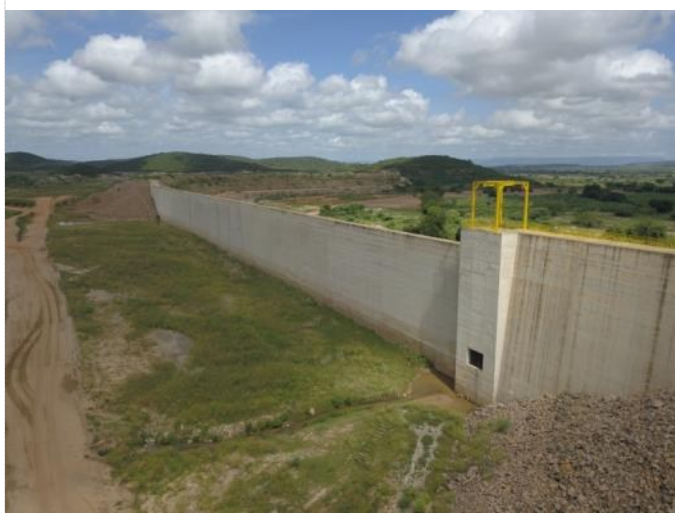
Figura 10-16 - Barragem Porcos – Vertedor (montante)
