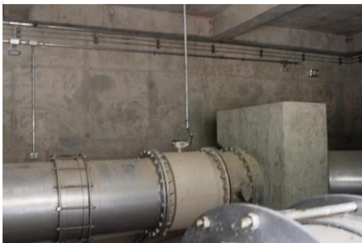
Figura 6-15 – Barragem Negreiros - Válvula Dispersora
