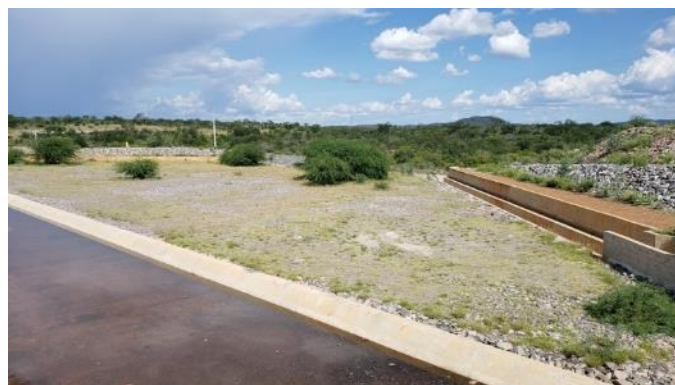
Figura 5-18 – Barragem Mangueira - Canal de Restituição do Vertedor
