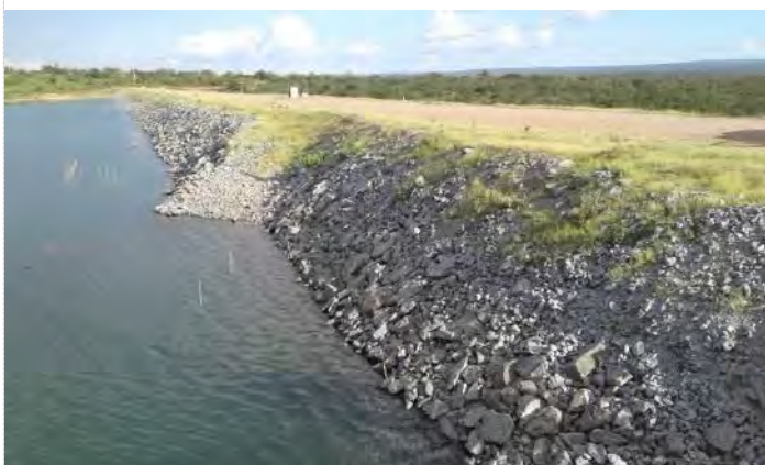
Figura 3.9 – Barragem Braúnas - Talude de Montante
