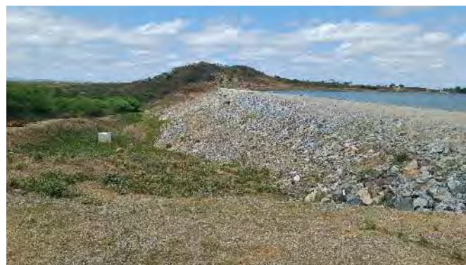
Figura 12.22 - Barragem Campos – Talude de Jusante
