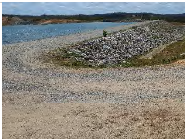
Figura 13.15 - Barragem Barro Branco – Crista e Talude de Jusante
