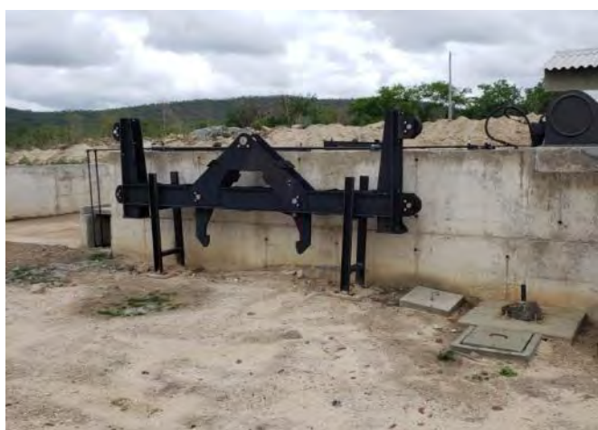
Figura 8.56 - Estrutura de Controle Bagres – Viga pescadora
