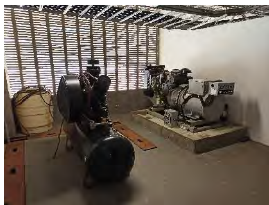
Figura 24.76 – EBV-4 – Sala de compressor e gerador
