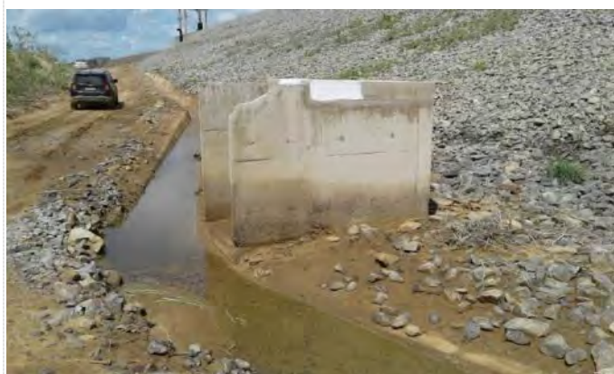
Figura 6.22 - Barragem Muquém – Drenagem no Talude de Justante
