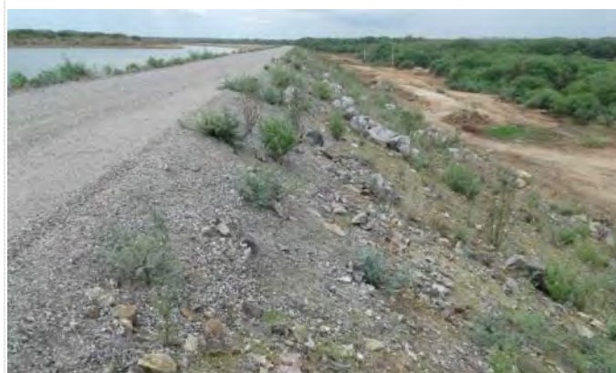
Figura 10.8 - Barragem Moxotó – Talude de Jusante
