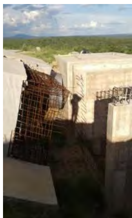
Figura 22.29 – EBV-2 – Adutora de Recalque (espera)
