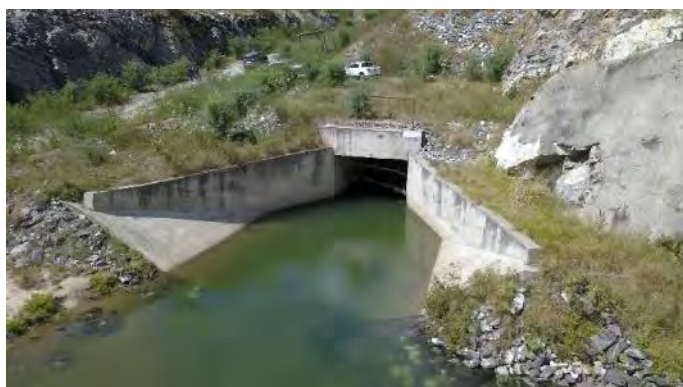
Figura 18.4 – Emboque da Galeria
