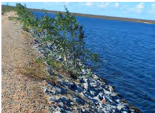
Figura 5.19 - Barragem Salgueiro – Talude de Montante
