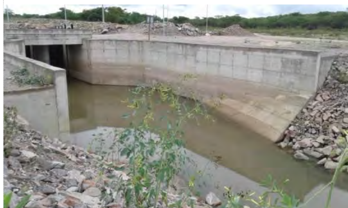
Figura 9.56 - Estrutura de Controle Copiti – Canal de Entrada
