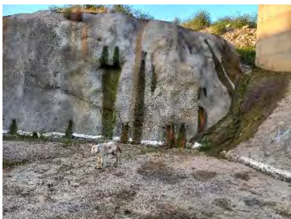
Figura 25.36 –EBV-5 – Surgências de água no concreto projetado
