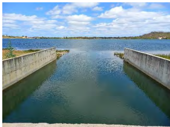
Figura 12.48 - Estrutura de Controle Campos – Canal de Entrada
