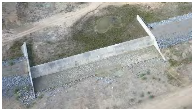
Figura 9.43 - Barragem Copiti – Vertedor
