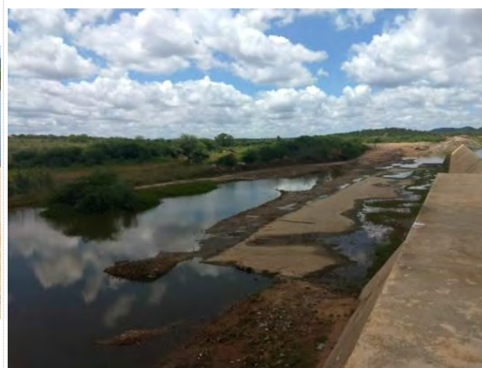
Figura 7.18 - Barragem Cacimba Nova – Canal de Restituição do Vertedor
