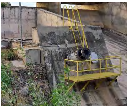
Figura 10.29 - Barragem Moxotó – Válvula Dispersora
