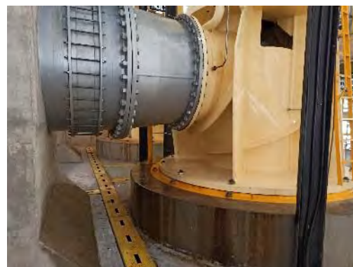
Figura 22.58 – EBV-2 – Vazamento do Cj. Motobomba
