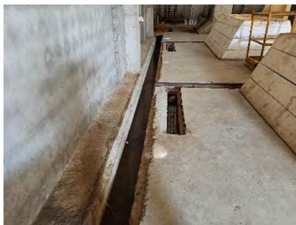
Figura 24.80 – EBV-4 – Galeria com acúmulo de água
