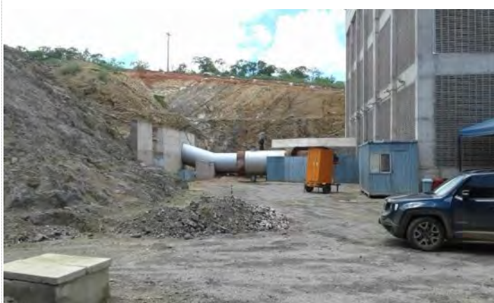
Figura 24.25 – EBV-4 – Tubulação de recalque
