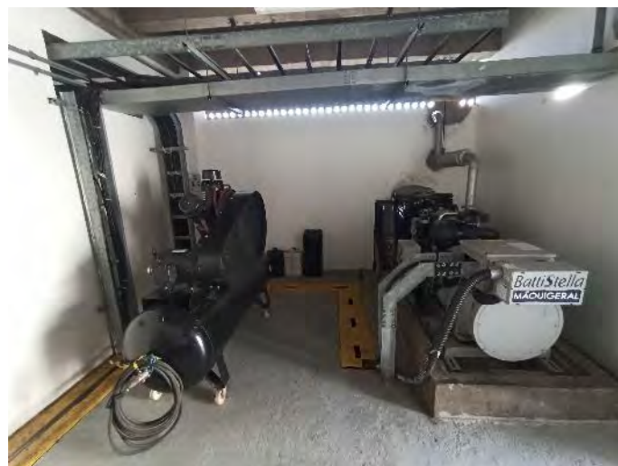
Figura 21.50 – EBV-1 – Compressor e gerador a diesel
