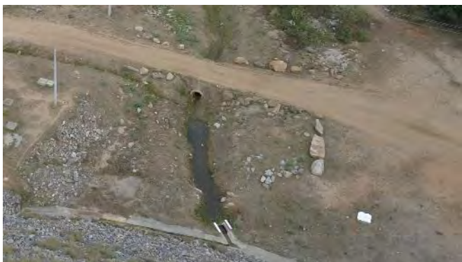
Figura 11.36 - Barragem Barreiro – Saída da Drenagem do pé de Jusante do Talude
