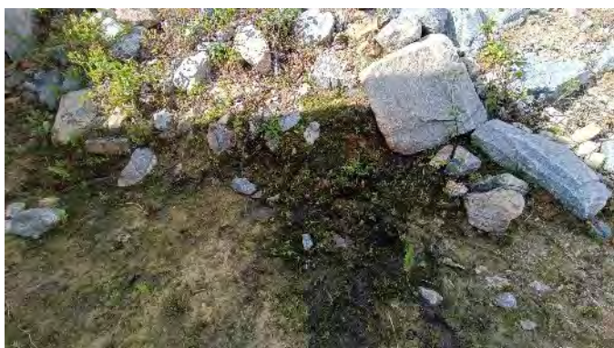
Figura 9.35 - Barragem Copiti – Surgência de água
