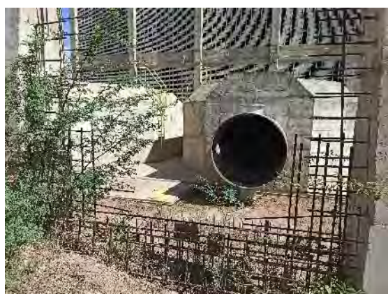
Figura 23.51 – EBV-3 – Adutora de Recalque espera)
