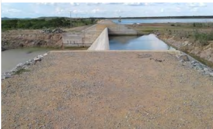
Figura 5.15 - Barragem Salgueiro – Canal de Restituição do Vertedor
