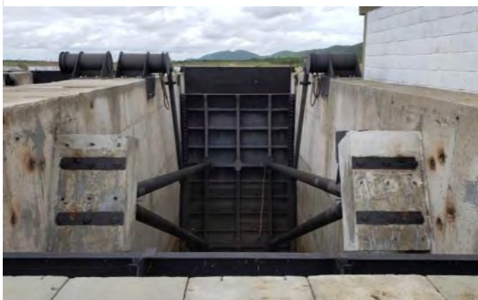
Figura 8.54 - Estrutura de Controle Bagres – Comporta
