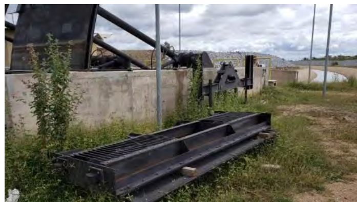
Figura 2.47 – Estrutura de Controle Areias - Grades
