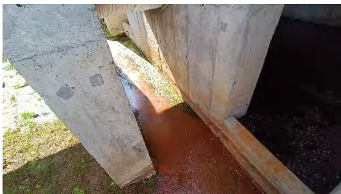
Figura 9.37 - Barragem Copiti – Surgência de água
