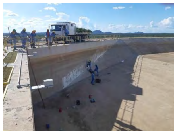
Figura 21.26 – EBV-1 – Manutenção no Forebay de Jusante
