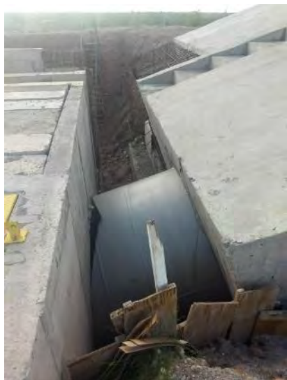
Figura 23.22 –EBV-3 – Adutora de Recalque
