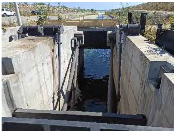
Figura 6.58 - Estrutura de Controle Muquém – Comportas
