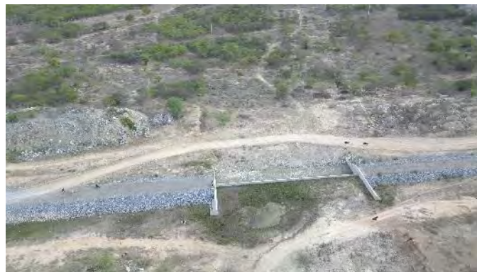
Figura 9.44 - Barragem Copiti – Canal de Restituição do Vertedor
