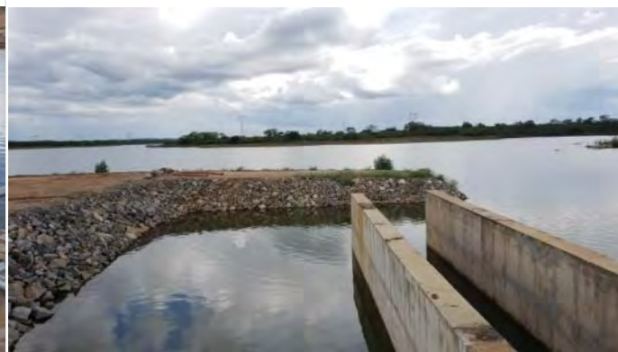
Figura 11.12 - Barragem Barreiro – Tomada d'água
