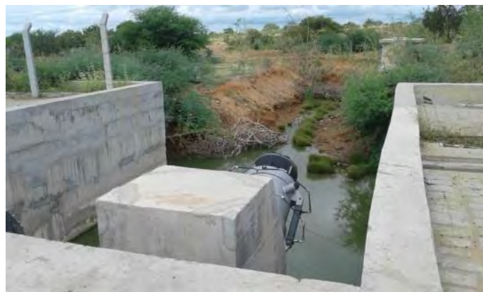
Figura 2.18 – Barragem Areias - Válvula Dispersora
