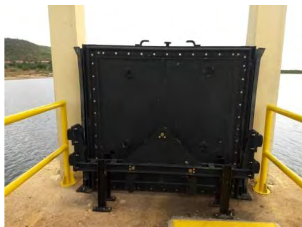
Figura 8.12 - Barragem Bagres – Comporta stop-log na TUD
