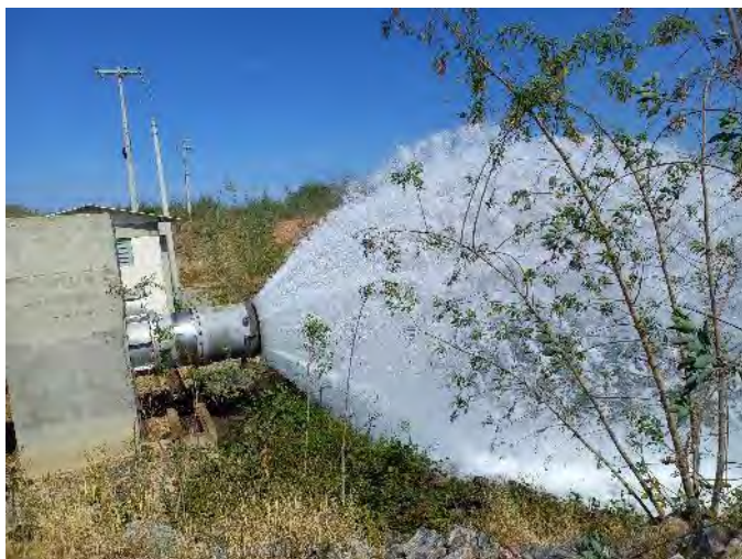
Figura 6.29 - Barragem Muquém – Válvula Dispersora
