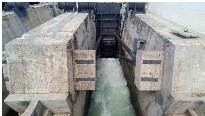
Figura 13.45 - Estrutura de Controle Barro Branco – Comporta
