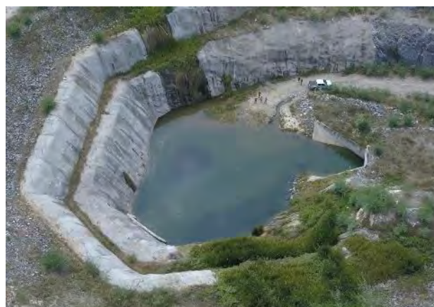
Figura 18.3 – Desemboque do Túnel e Emboque da Galeria, respectivamente
