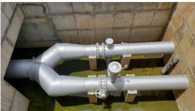
Figura 12.11 - Barragem Campos – Válvula Dispersora 1
