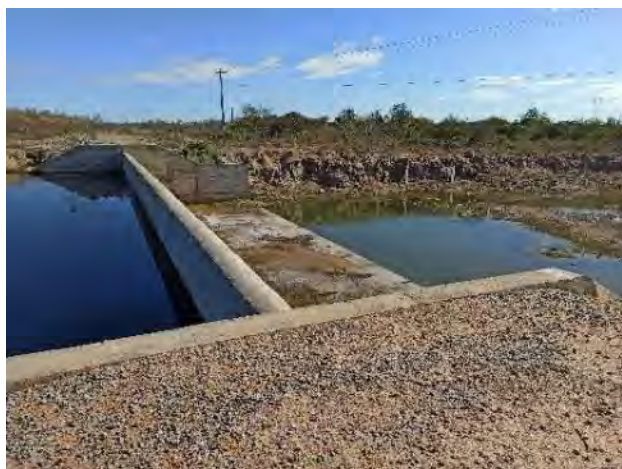
Figura 5.33 - Barragem Salgueiro – Canal de Restituição do Vertedor
