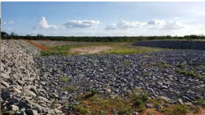
Figura 4.14 - Barragem Mandantes - Canal de Restituição do Vertedor
