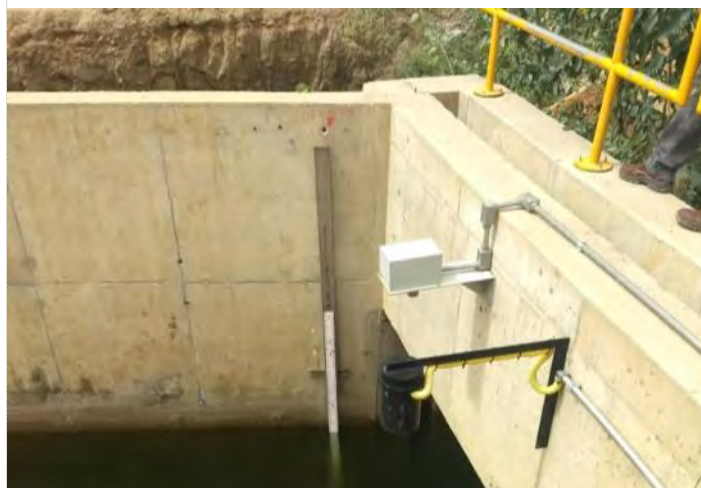
Figura 20.6 – Adutora Monteiro - Medidores de Nível
