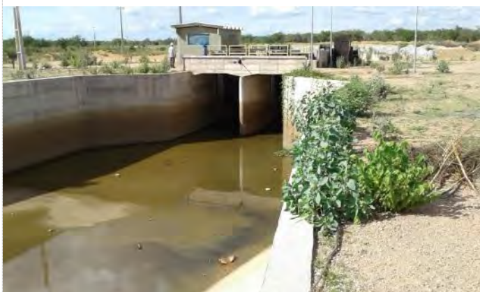
Figura 5.41 - Estrutura de Controle Salgueiro – Canal de Entrada
