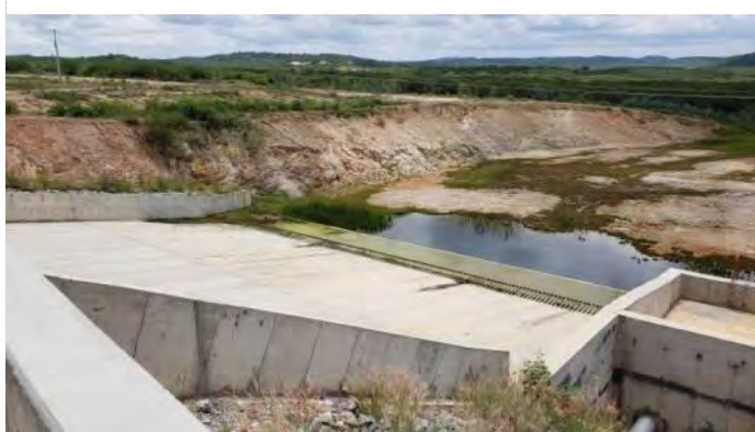
Figura 13.9 - Barragem Barro Branco - Vertedor
