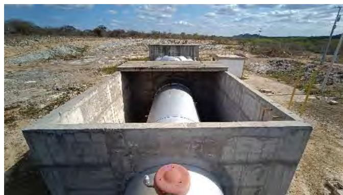
Figura 9.48 - Barragem Copiti – Válvula Dispersora
