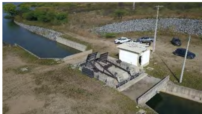
Figura 11.49 - Estrutura de Controle Barreiro – Comportas
