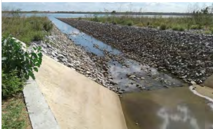
Figura 5.46 - Estrutura de Controle Salgueiro – Canal de Entrada (assoreamento)
