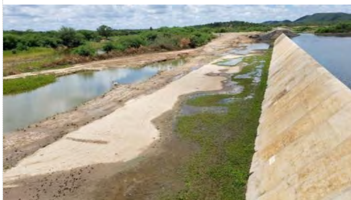
Figura 7.17 - Barragem Cacimba Nova – Vertedor
