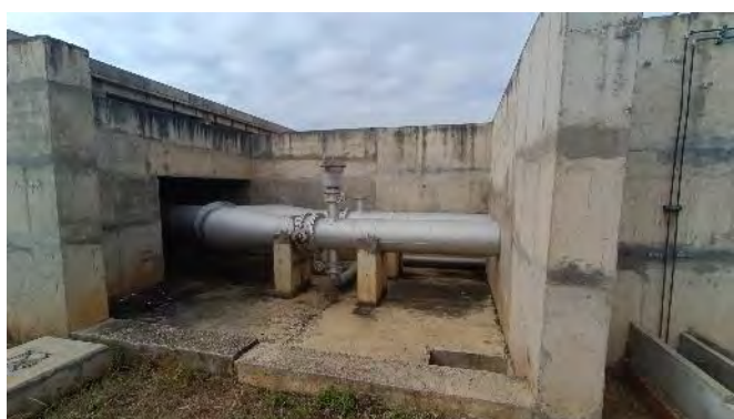
Figura 11.32 - Barragem Barreiro – Válvula Dispersora
