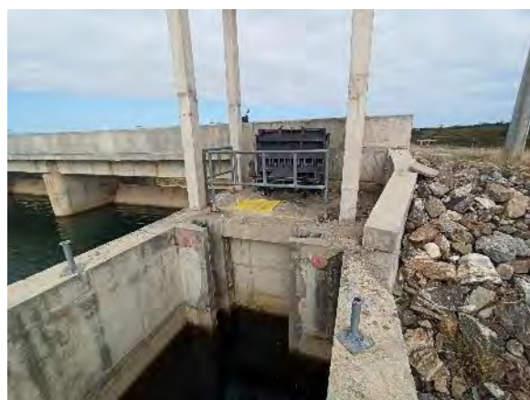
Figura 11.28 - Barragem Barreiro – Ausência do Medidor de Nível da TUD
