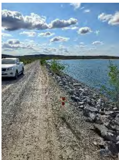
Figura 9.33 - Barragem Copiti – Talude de Montante
