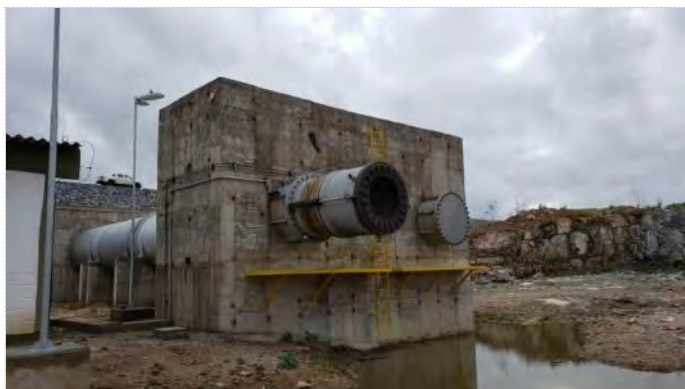
Figura 9.25 - Barragem Copiti – Válvula Dispersora
