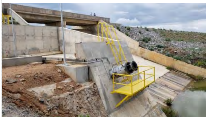
Figura 10.13 - Barragem Moxotó – Válvula Dispersora
