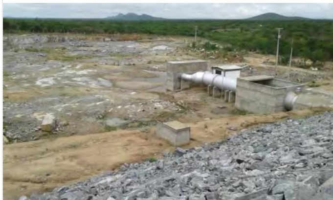
Figura 9.24 - Barragem Copiti – Válvula Dispersora
