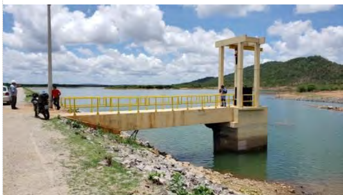
Figura 7.15 - Barragem Cacimba Nova – Torre da TUD
