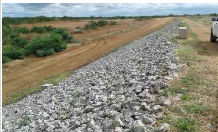
Figura 2.12 – Barragem Areias - Talude de Jusante
