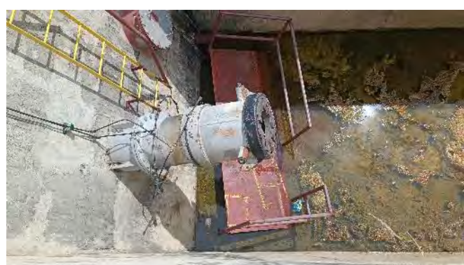
Figura 12.28 - Barragem Campos – Válvula Dispersora
