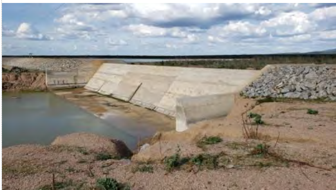
Figura 5.13 - Barragem Salgueiro – Vertedor
