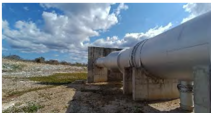
Figura 9.47 - Barragem Copiti – Válvula Dispersora
