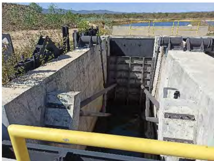
Figura 6.62 - Estrutura de Controle Muquém – Comportas
