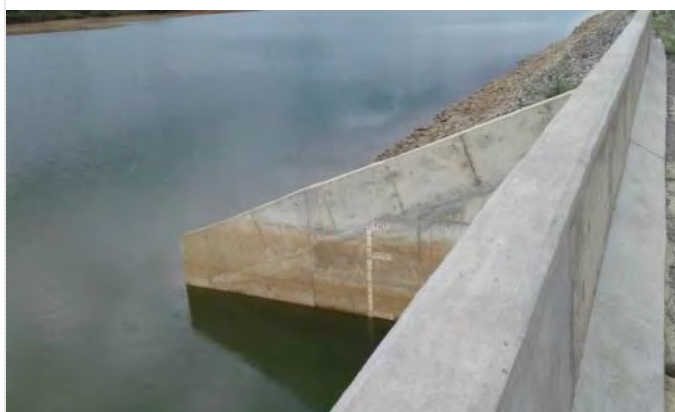
Figura 10.10 - Barragem Moxotó – Leitura de Nível do Reservatório
