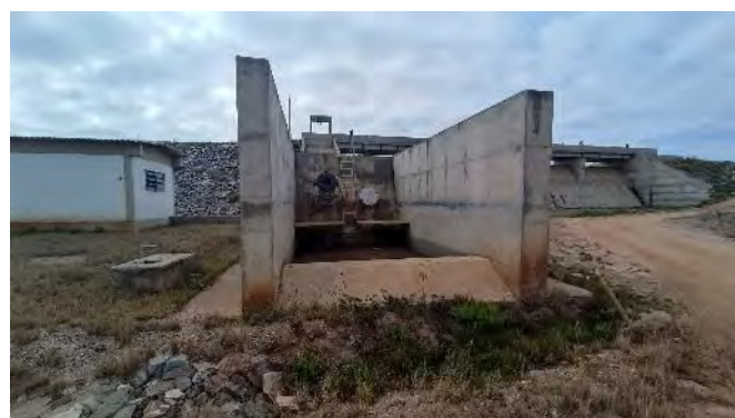
Figura 11.33 - Barragem Barreiro – Válvula Dispersora
