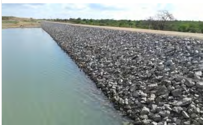
Figura 5.5 - Barragem Salgueiro – Talude de Montante
