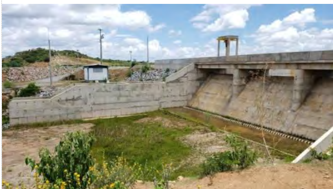
Figura 12.15 - Barragem Campos - Vertedor
