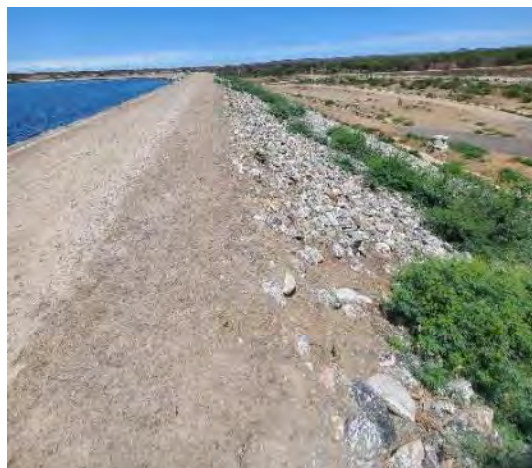
Figura 2.33 – Barragem Areias - Talude de Jusante
