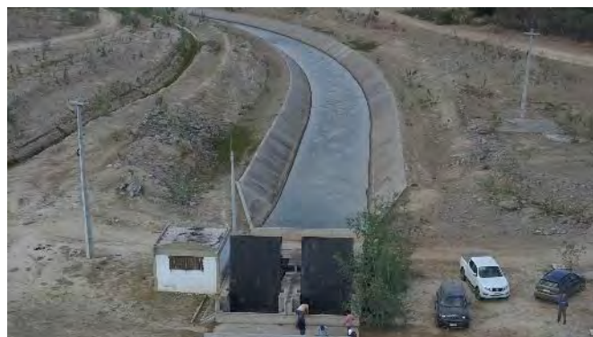
Figura 8.63 - Estrutura de Controle Bagres – Canal de Entrada
