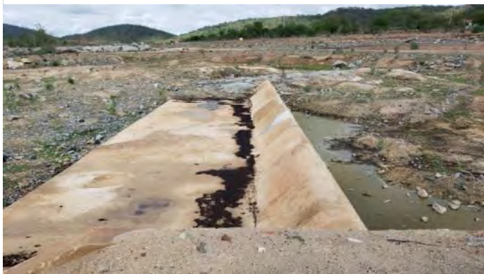
Figura 8.19 - Barragem Bagres - Vertedor
