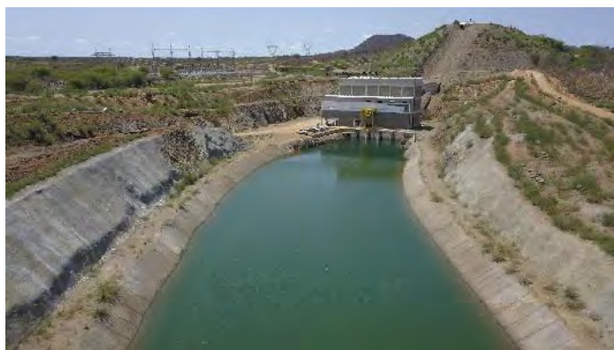
Figura 24.53 –EBV-4 – Forebay de montante
