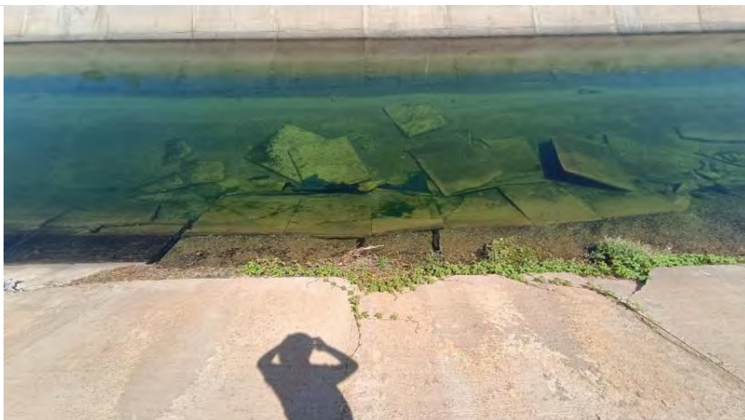
Figura 15.3 – CN10 – WBS 2213 - Deslocamentos
