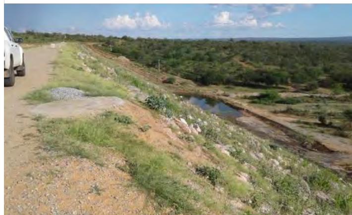
Figura 3.10 – Barragem Braúnas - Talude de Jusante
