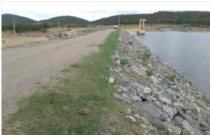
Figura 8.7 - Barragem Bagres – Talude de Montante
