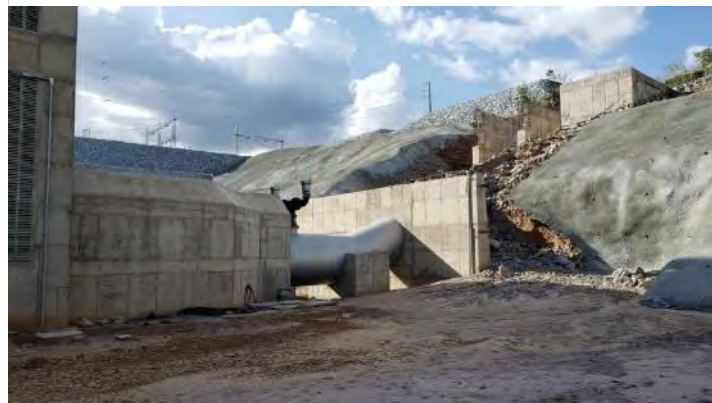
Figura 23.25 –EBV-3 – Adutora de Recalque
