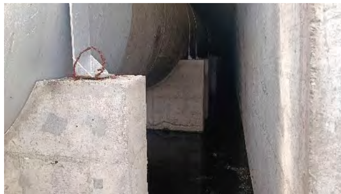
Figura 9.36 - Barragem Copiti – Surgência de água
