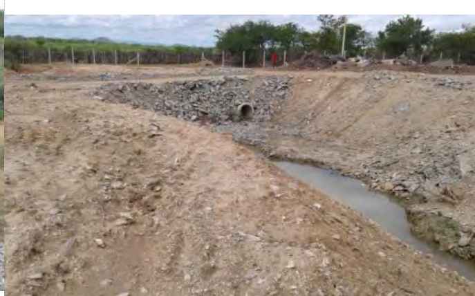
Figura 8.18 - Barragem Bagres – Drenagem sob via de serviço
