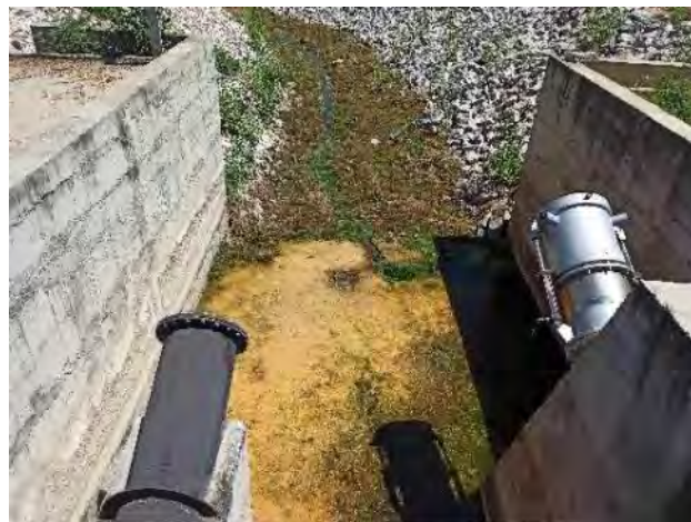
Figura 2.37 – Barragem Areias - Válvula Dispersora
