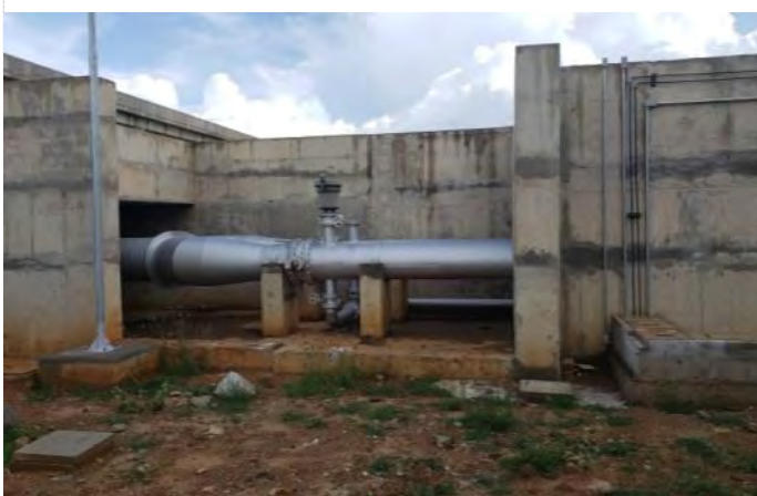
Figura 11.15 - Barragem Barreiro – Válvula Dispersora 1
