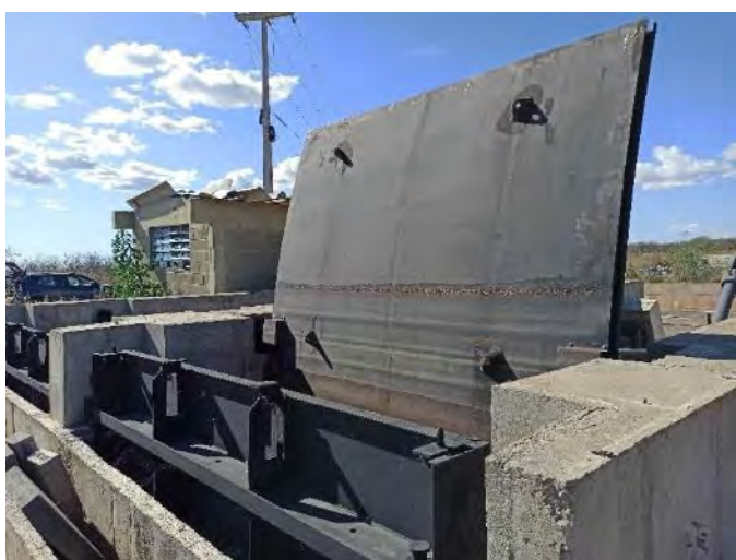
Figura 5.62 - Estrutura de Controle Salgueiro – Oxidação comporta
