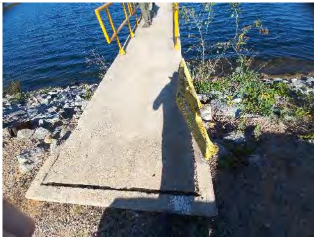
Figura 5.25 - Barragem Salgueiro – Guarda corpos danificados na passarela da torre da TUD
