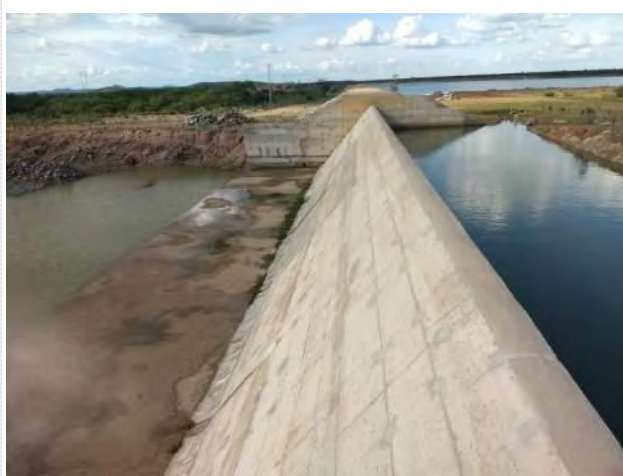
Figura 5.16 - Barragem Salgueiro – Vertedor
