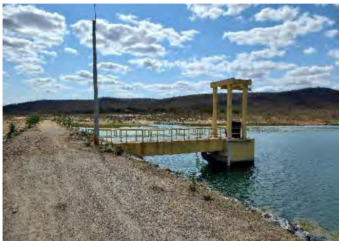
Figura 8.31 - Barragem Bagres – Torre da TUD
