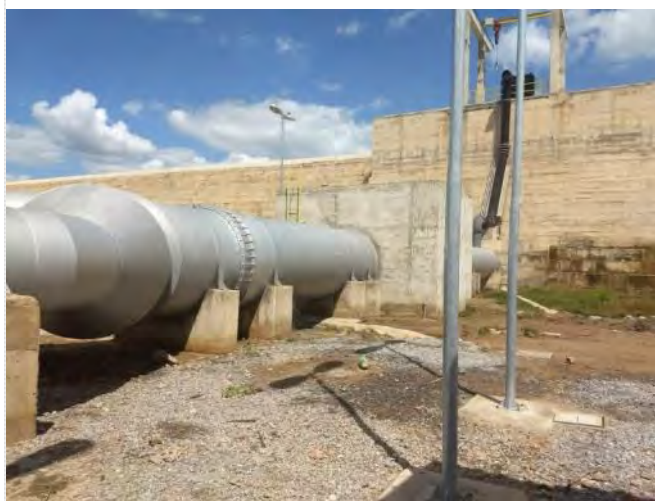
Figura 6.10 - Barragem Muquém – Válvula Dispersora
