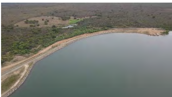
Figura 11.22 - Barragem Barreiro – Crista e Talude de Montante
