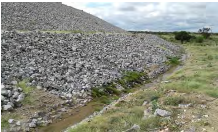
Figura 2.15 – Barragem Areias - Talude de Jusante
