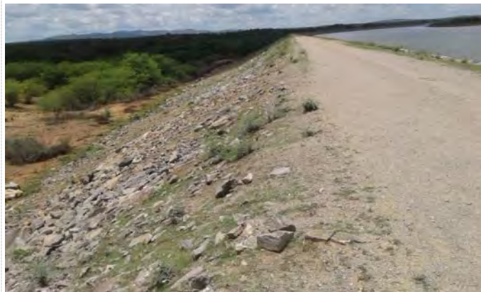
Figura 7.6 - Barragem Cacimba Nova – Talude Jusante
