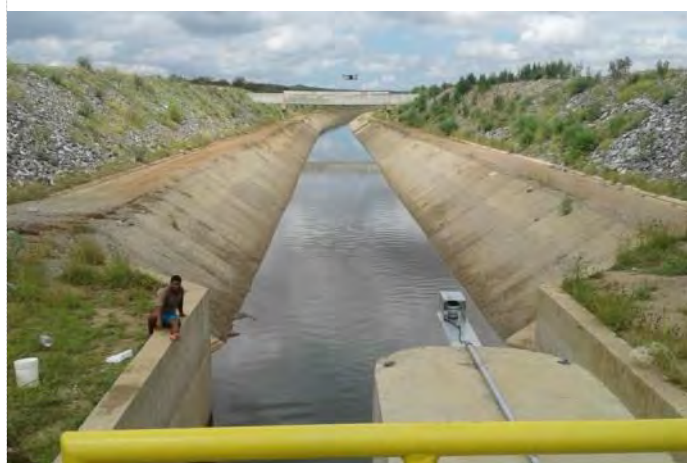
Figura 19.10 – Estrutura de Controle Adutora Monteiro - Canal de entrada
