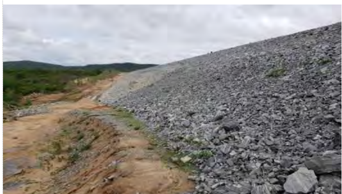
Figura 9.11 - Barragem Copiti – Talude de Jusante 1
