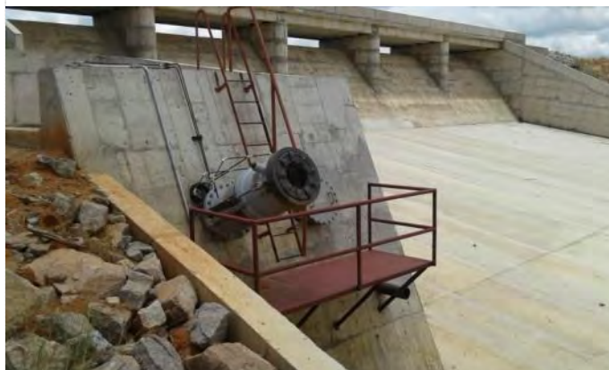
Figura 13.12 - Barragem Barro Branco - Válvula Dispersora e Vertedor
