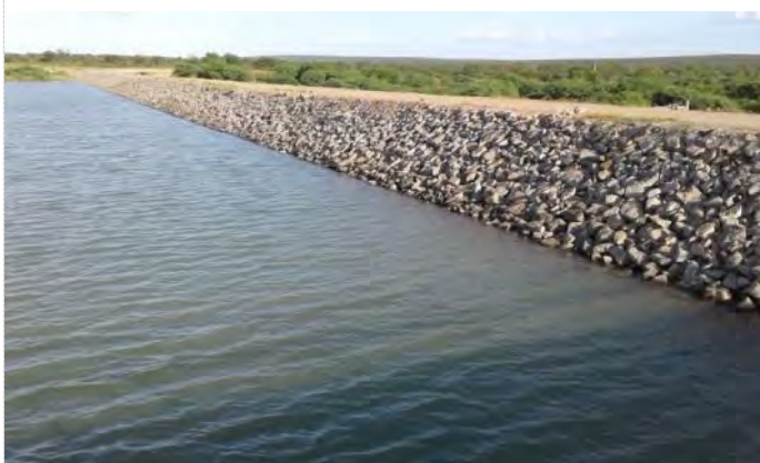
Figura 4.7 - Barragem Mandantes – Talude de Montante
