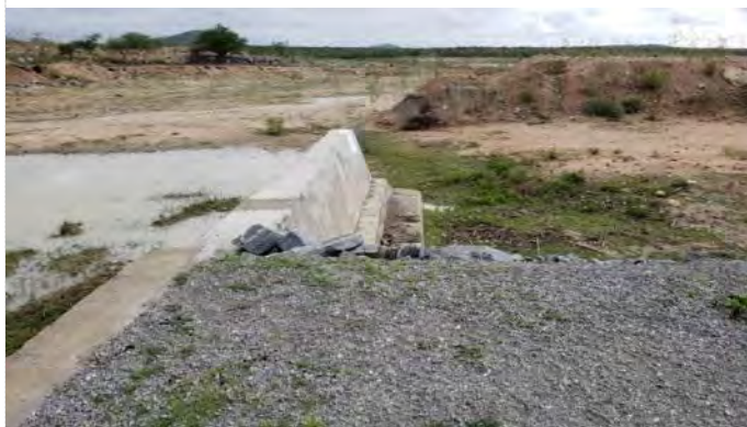
Figura 9.22 - Barragem Copiti – Vertedor não finalizado
