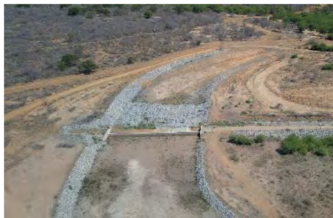
Figura 4.28 - Barragem Mandantes - Canal de Restituição do Vertedor
