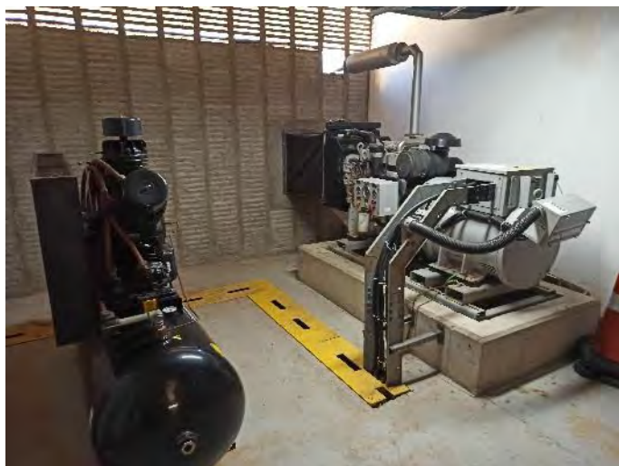
Figura 23.65 – EBV-3 – Compressor e gerador a diesel
