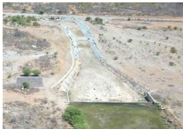
Figura 2.39 – Barragem Areias - Canal de Restituição do Vertedor
