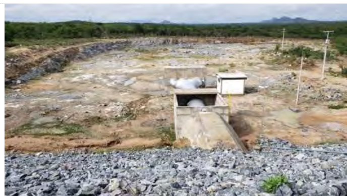
Figura 9.26 - Barragem Copiti – Canal de Restituição da TUD
