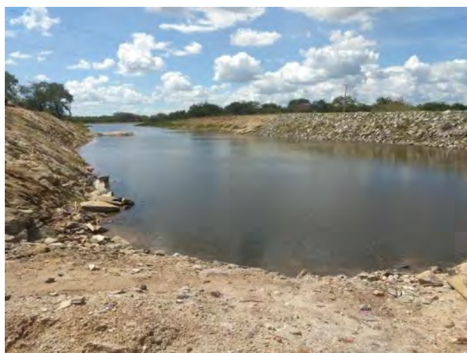
Figura 6.15 - Barragem Muquém – Canal de Restituição da TUD
