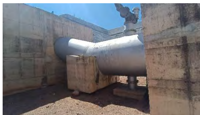
Figura 21.38 – EBV-1 – Adutora de Recalque
