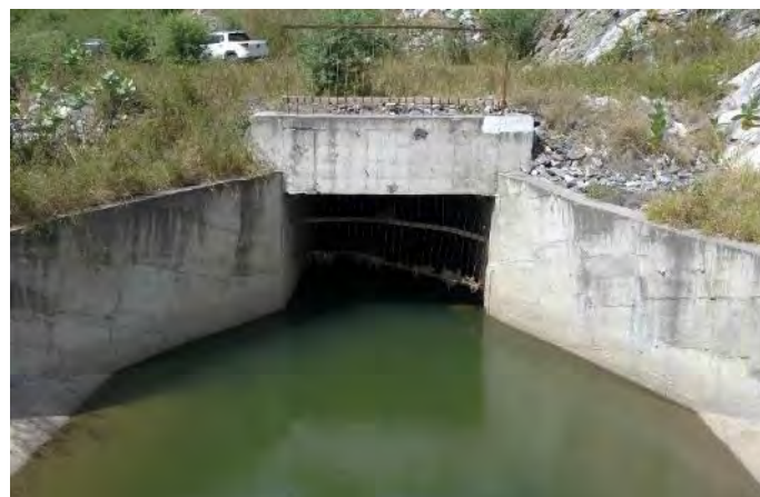
Figura 18.5 – Emboque da Galeria
