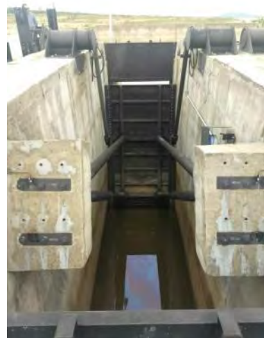
Figura 9.62 - Estrutura de Controle Copiti – Comporta
