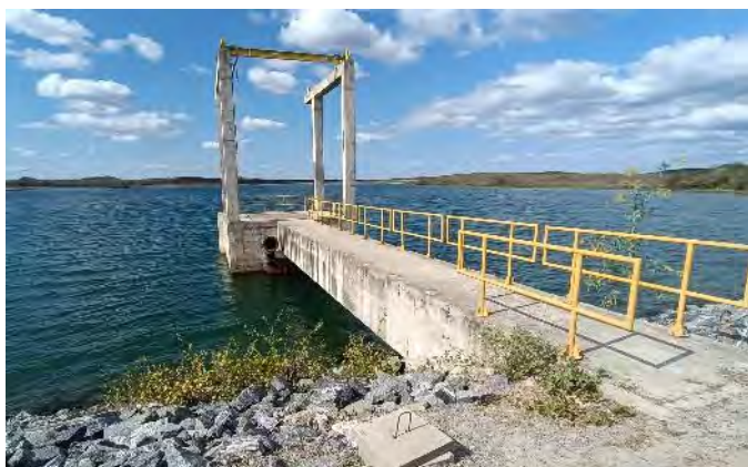
Figura 9.39 - Barragem Copiti – Torre da TUD
