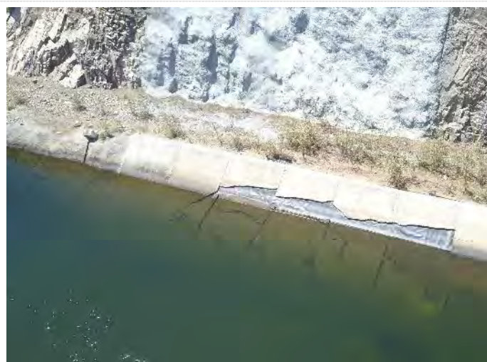
Figura 22.64 – EBV-2 – Deslocamentos forebay montante
