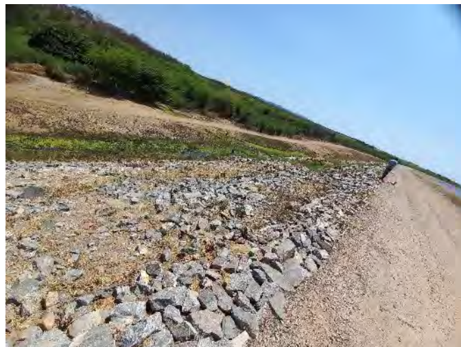
Figura 7.26 - Barragem Cacimba Nova – Talude de justante
