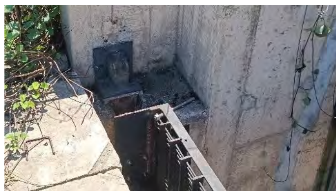
Figura 2.59 – Estrutura de Controle Areias - Grades
