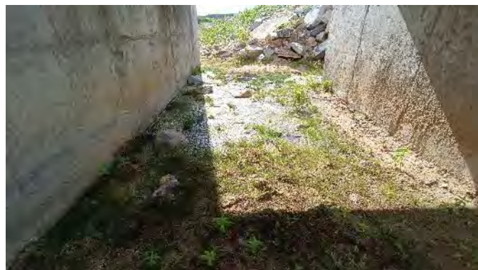
Figura 9.38 - Barragem Copiti – Surgência de água na região dos blocos de ancoragem da tubulação de adução da TUD
