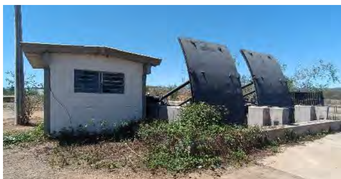
Figura 2.58 – Estrutura de Controle Areias - Comportas
