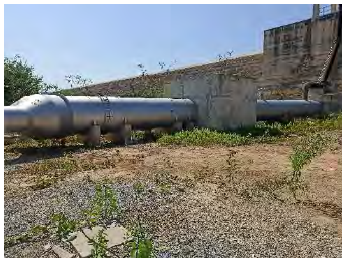
Figura 6.30 - Barragem Muquém – Válvula Dispersora
