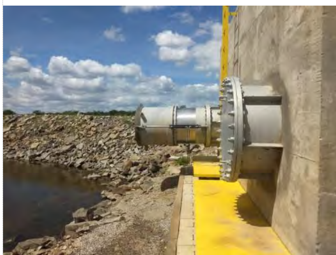
Figura 6.9 - Barragem Muquém – Válvula Dispersora
