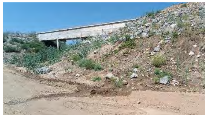
Figura 16.5 – Aqüeduto Jacaré – Surgência de Água
