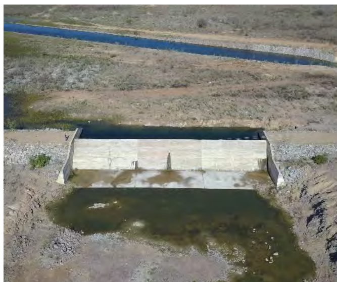
Figura 5.34 - Barragem Salgueiro – Vertedor
