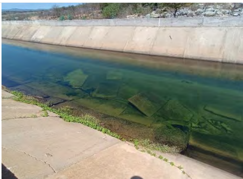
Figura 15.2 – CN10 – WBS 2213 - Desplacamentos
