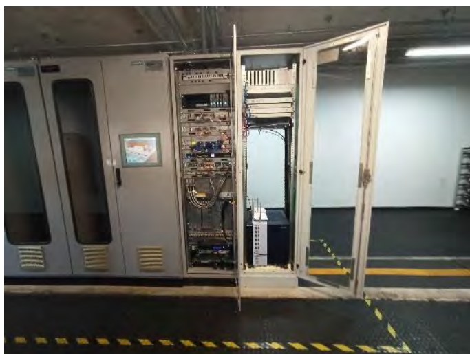
Figura 21.51 – EBV-1 – Painel de comunicação
