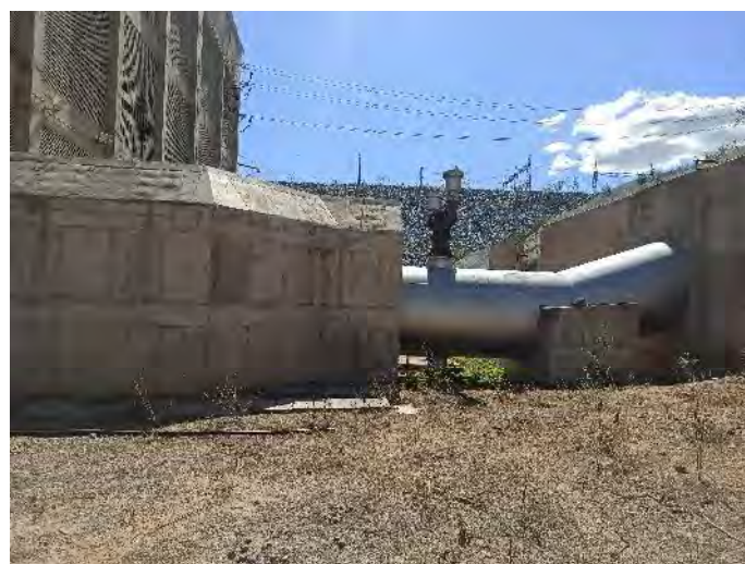
Figura 23.56 –EBV-3 – Adutora de Recalque
