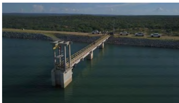
Figura 3.6 – Barragem Braúnas - Torre da TUD
