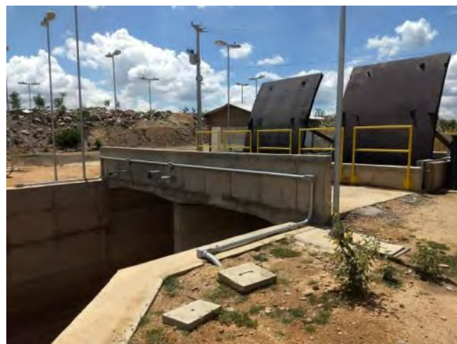
Figura 6.52 - Estrutura de Controle Muquém – Comportas
