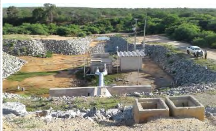
Figura 4.10 - Barragem Mandantes – Torre da TUD
