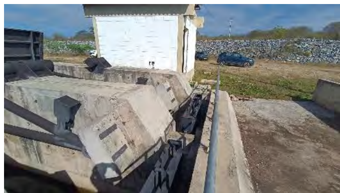
Figura 11.49 - Estrutura de Controle Barreiro – Comportas
