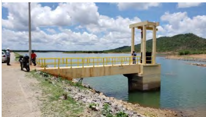
Figura 7.33 - Barragem Cacimba Nova – Torre da TUD
