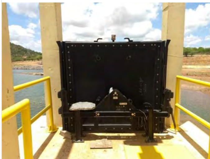
Figura 7.14 - Barragem Cacimba Nova – Comporta stop-log da TUD
