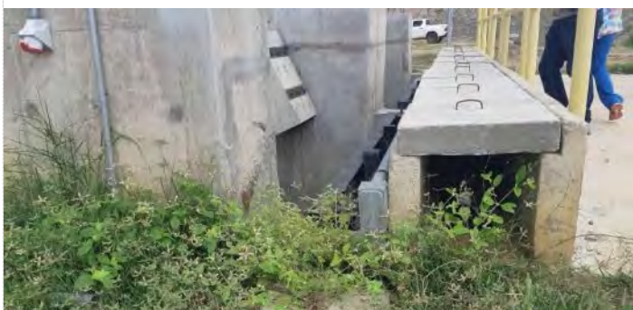
Figura 3.45 – Barragem Braúnas - Vão das comportas stop-log
