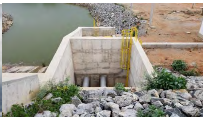
Figura 10.12 - Barragem Moxotó – Caixa de Saída da TUD
