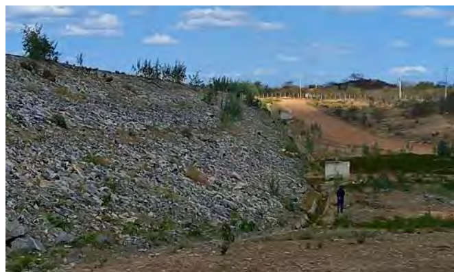
Figura 8.26 - Barragem Bagres – Talude de Jusante
