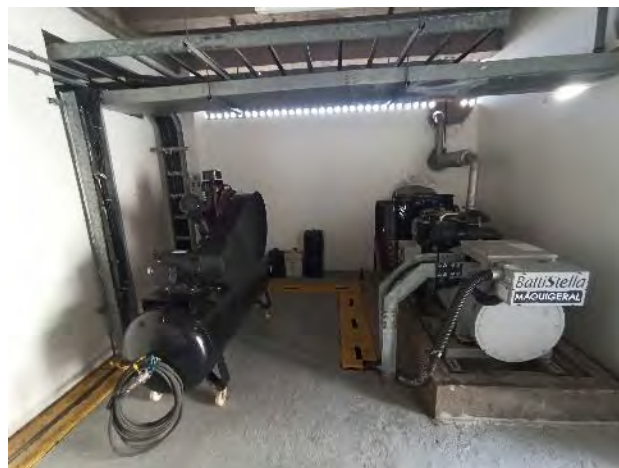
Figura 21.42 – EBV-1 – Compressor e gerador a diesel
