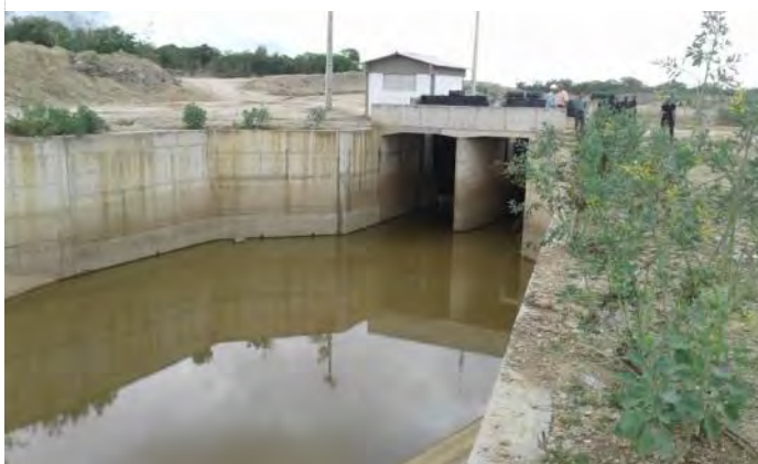
Figura 8.48 - Estrutura de Controle Bagres – Canal de Entrada
