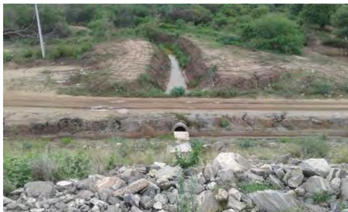
Figura 11.19 - Barragem Barreiro – Saída da Drenagem do pé de Jusante do Talude
