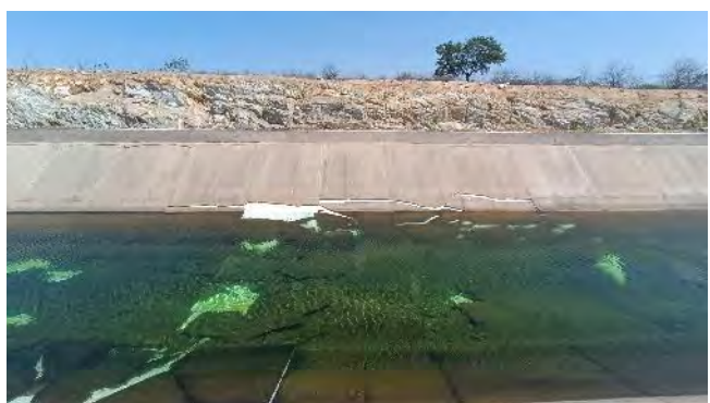
Figura 14.8 – CN09 – WBS 2212 – Cortes na manta de PVC
