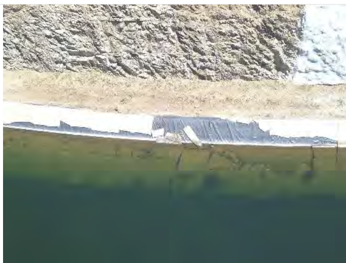
Figura 22.63 – EBV-2 – Deslocamentos forebay montante
