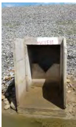
Figura 6.21 - Barragem Muquém – Talude de Justante (medidor de vazão)
