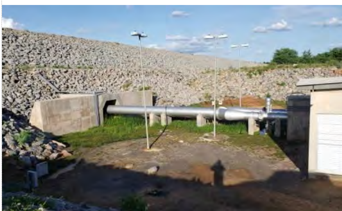
Figura 4.11 - Barragem Mandantes – Válvula Dispersora
