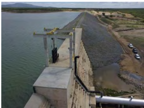
Figura 6.7 - Barragem Muquém – Talude de Justante
