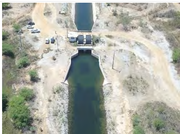
Figura 2.54 – Estrutura de Controle Areias - Canal de Entrada
