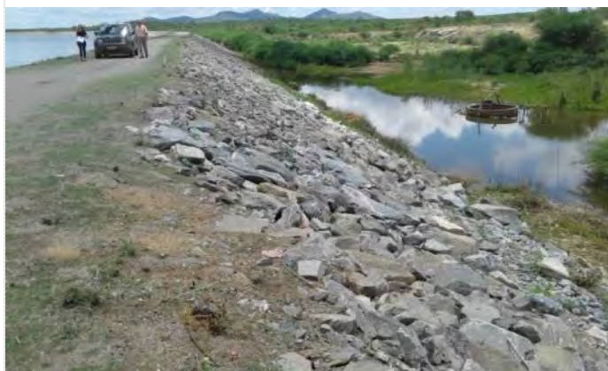
Figura 7.8 - Barragem Cacimba Nova – Talude de jusante (saturação)
