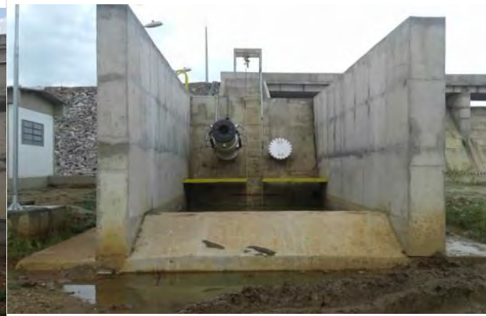
Figura 11.16 - Barragem Barreiro – Válvula Dispersora 2
