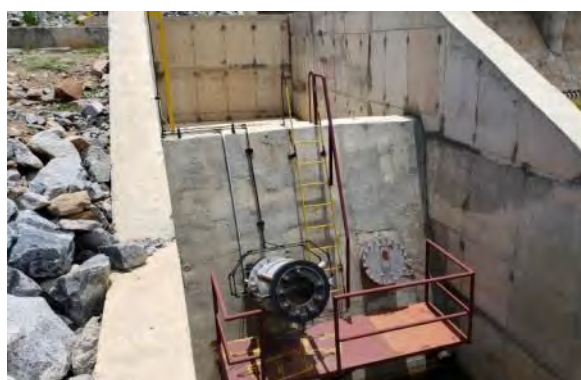
Figura 12.12 - Barragem Campos – Válvula Dispersora 2
