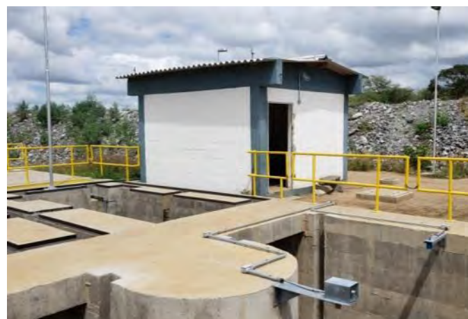
Figura 19.4 – Estrutura de Controle Adutora Monteiro - Medidores de Nível
