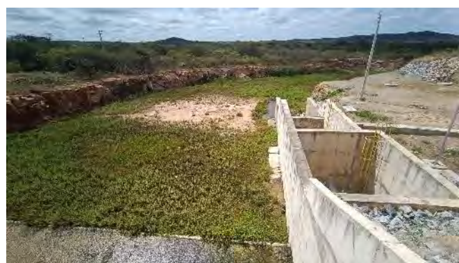
Figura 12.34 - Barragem Campos – Canal de Restituição do Vertedor
