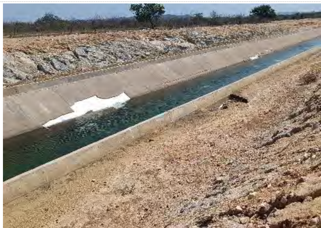
Figura 14.6 – CN09 – WBS 2212 - Desplacimento
