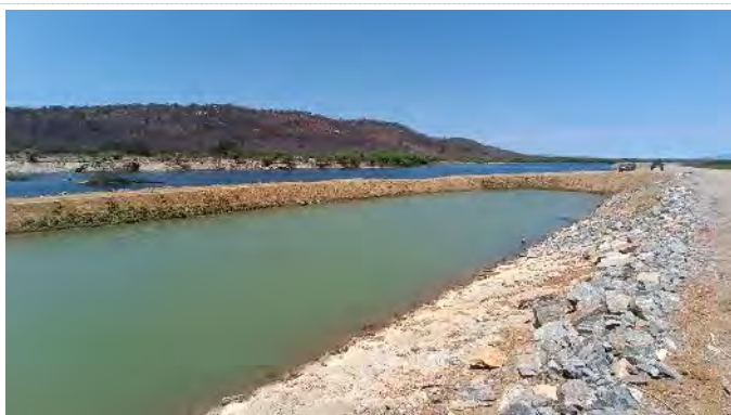
Figura 7.25 - Barragem Cacimba Nova – Talude de justante
