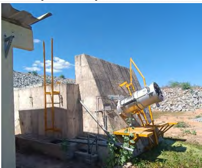
Figura 4.24 - Barragem Mandantes – Válvula Dispersora
