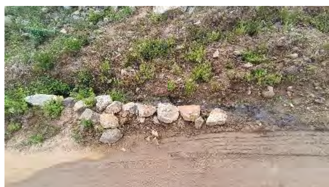
Figura 11.27 - Barragem Barreiro – Surgência no talude de jusante
