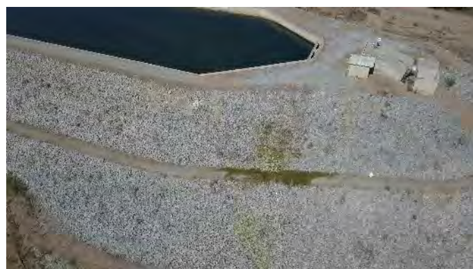
Figura 23.39 – EBV-3 – Sugência no forebay de jusante
