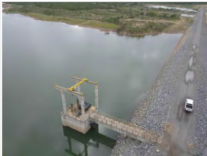
Figura 9.6 - Barragem Copiti – Torre da TUD
