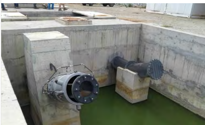
Figura 2.17 – Barragem Areias - Válvula Dispersora
