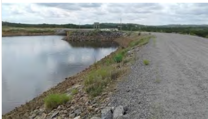
Figura 13.5 - Barragem Barro Branco – Crista e Talude de Montante
