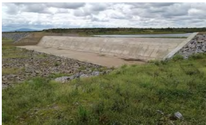
Figura 3.19 – Barragem Braúñas - Vertedor
