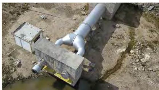
Figura 9.49 - Barragem Copiti – Válvula Dispersora
