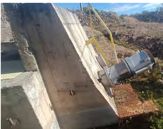
Figura 5.27 - Barragem Salgueiro – Válvula Dispersora
