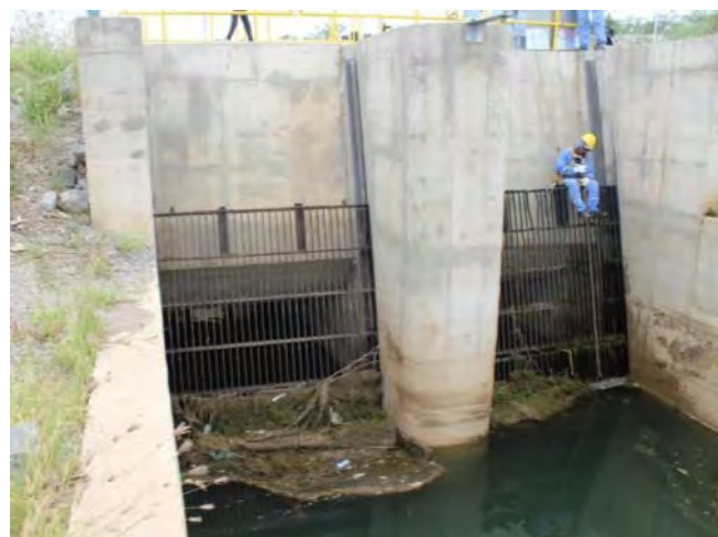
Figura 19.6 – Estrutura de Controle Adutora Monteiro - Grades das comportas
