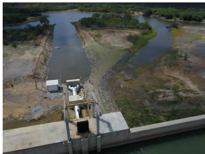
Figura 6.20 - Barragem Muquém – Canal de Restituição TUD e Vertedor
