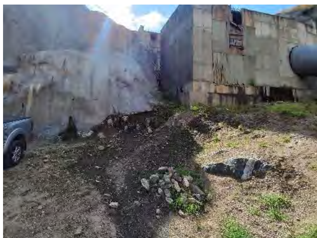
Figura 26.55 –EBV-6 – Umidade no pé do talude
