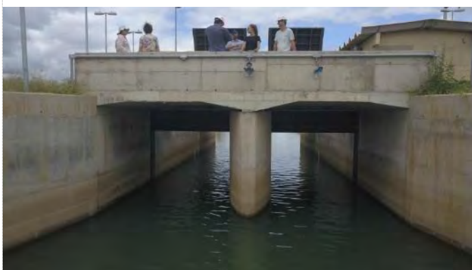
Figura 2.44 – Estrutura de Controle Areias – Canald e Saída
