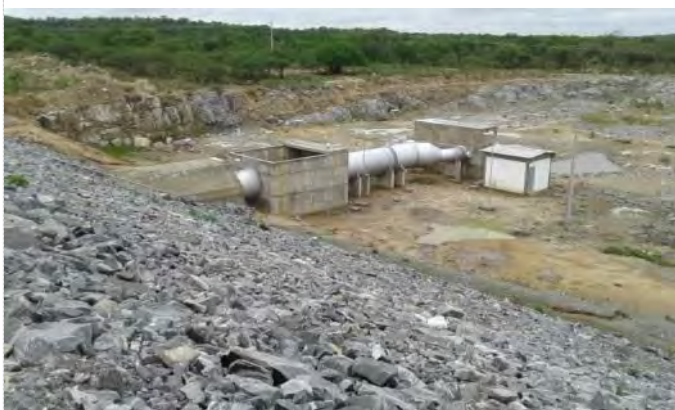
Figura 9.23 - Barragem Copiti – Válvula Dispersora
