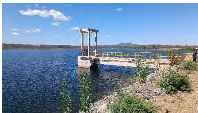
Figura 4.23 - Barragem Mandantes – Torre da TUD
