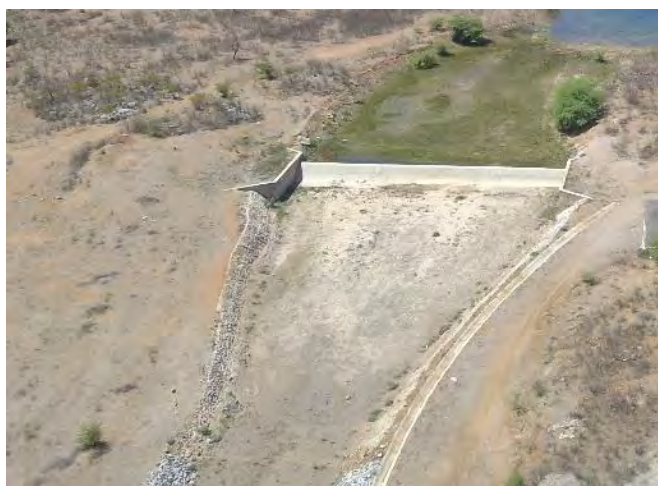
Figura 2.38 – Barragem Areias - Vertedor
