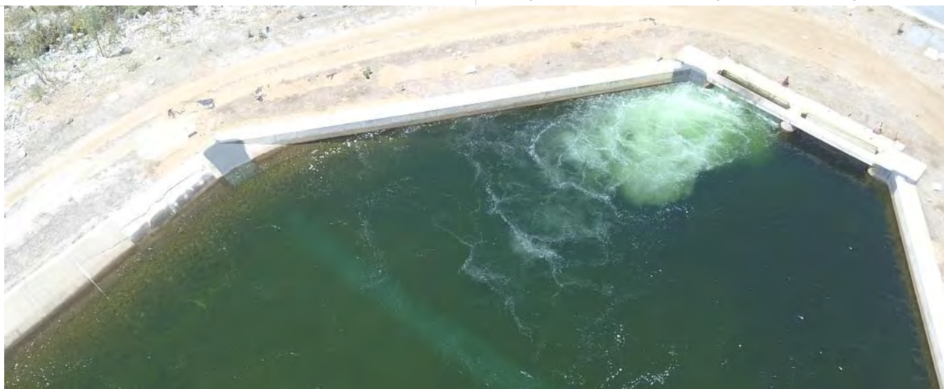
Figura 22.65 – EBV-2 – Trincas forebay de jusante
