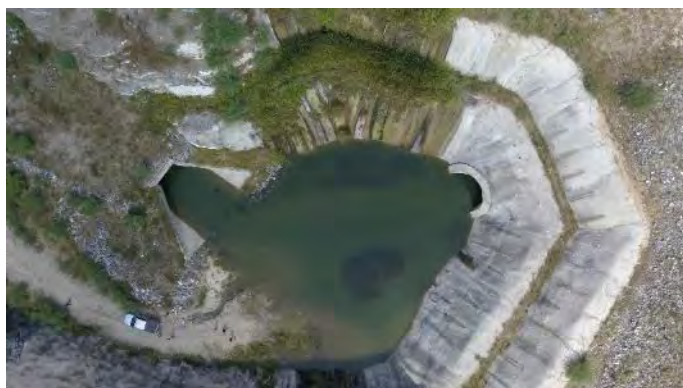
Figura 18.2 – Emboque da Galeria e Desemboque do Túnel, respectivamente
