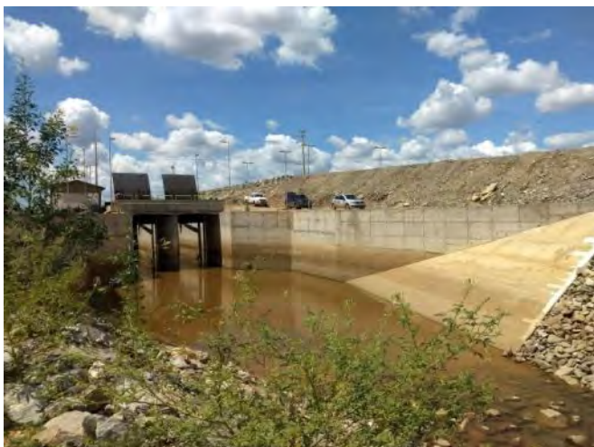
Figura 6.45 - Estrutura de Controle Muquém – Canal de Entrada
