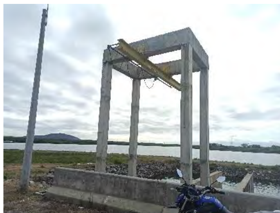
Figura 11.31 - Barragem Barreiro – TUD sem Talha elétrica
