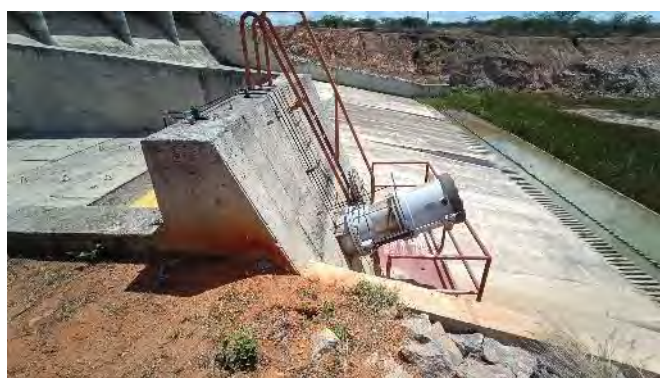
Figura 13.22 - Barragem Barro Branco – Válvula Dispersora e Vertedor
