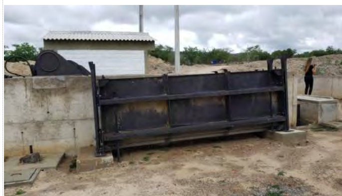
Figura 8.55 - Estrutura de Controle Bagres – Comporta stop-log
