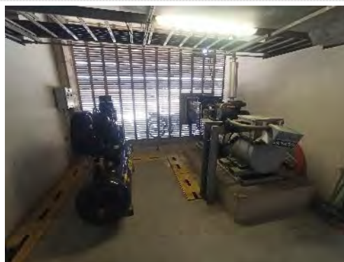
Figura 22.50 – EBV-2 – Sala do compressor e do gerador a diesel
