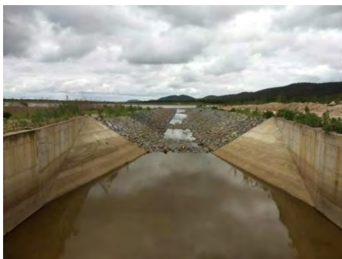
Figura 8.53 – Estrutura de Controle Bagres – Canal de Saída
