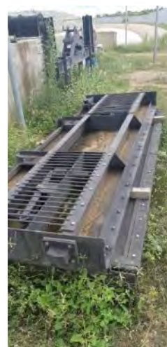
Figura 3.48 – Barragem Braúnas - Grades
