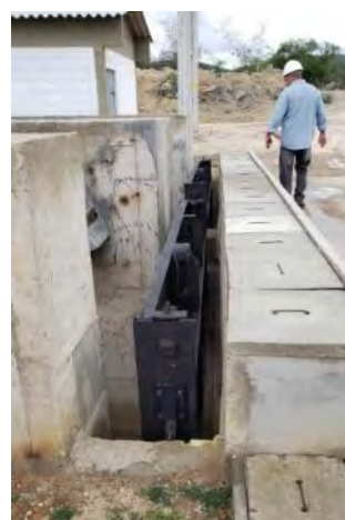
Figura 8.55 - Estrutura de Controle Bagres – Comporta stop-log
