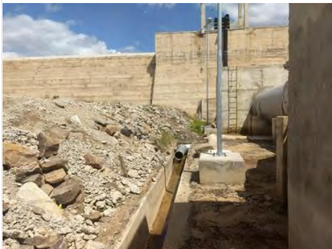
Figura 6.13 - Barragem Muquém – Drenagem de fundo
