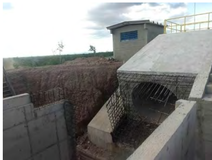
Figura 23.23 –EBV-3 – Adutora de Recalque (espera)
