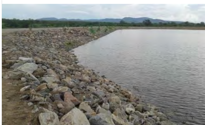
Figura 11.5 - Barragem Barreiro – Crista e Talude de Montante
