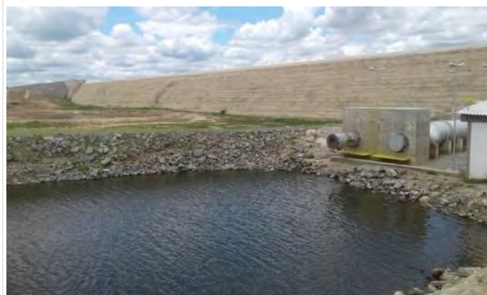
Figura 6.16 - Barragem Muquém – Canal de Restituição TUD
