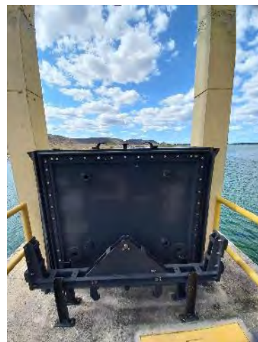
Figura 8.32 - Barragem Bagres – Comporta stop-log na TUD
