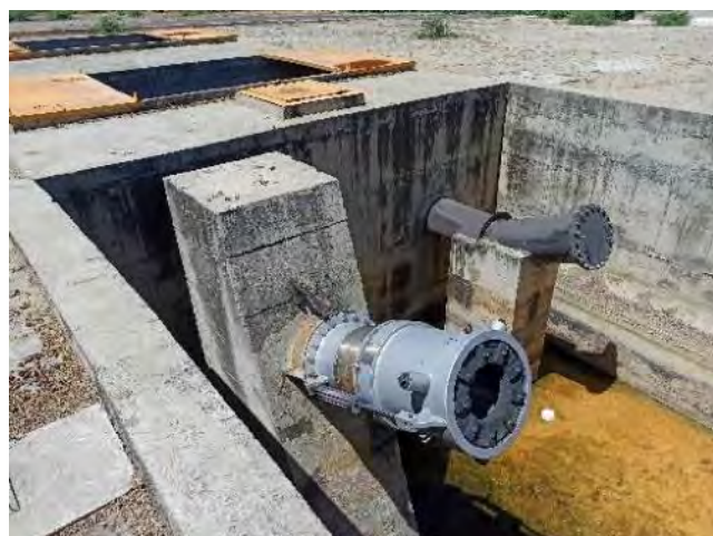
Figura 2.36 – Barragem Areias - Válvula Dispersora
