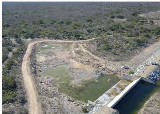
Figura 5.32 - Barragem Salgueiro – Canal de Restituição do Vertedor
