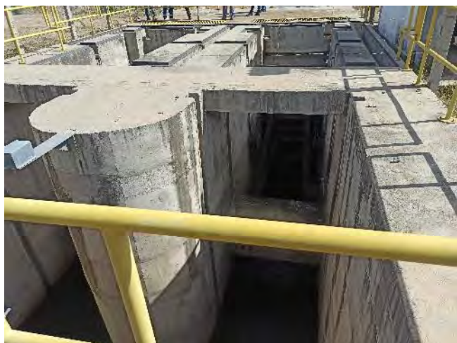
Figura 19.21 – Estrutura de Controle Adutora Monteiro - Ausência dos Medidores de Nível
