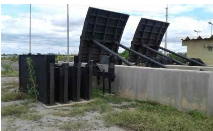
Figura 2.48 – Estrutura de Controle Areias - Comportas
