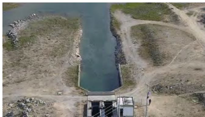
Figura 9.68 - Estrutura de Controle Copiti – Canal de Entrada
