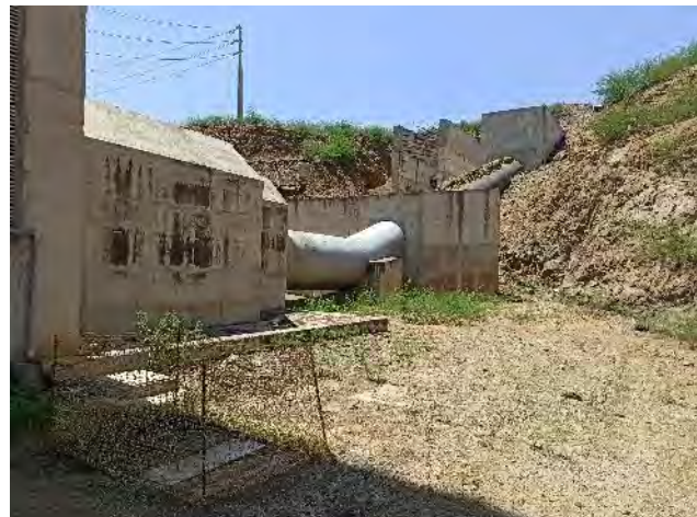
Figura 24.62 – EBV-4 – Adutora de Recalque
