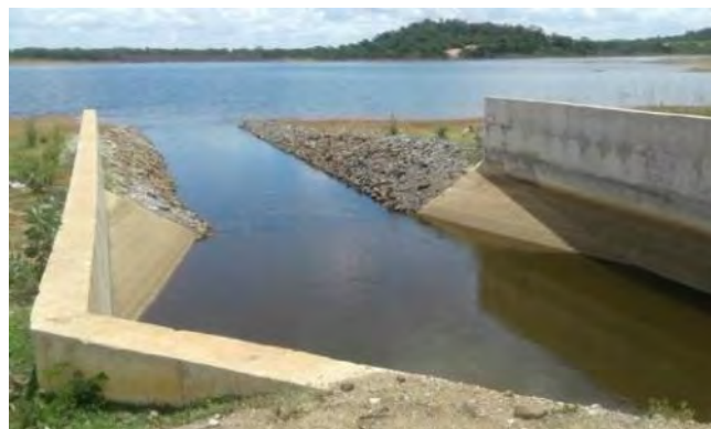
Figura 12.38 - Estrutura de Controle Campos – Canal de Entrada 2
