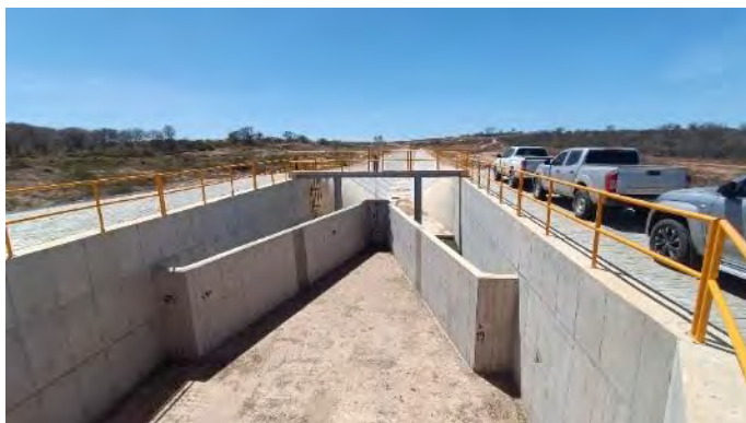
Figura 28-43 – Estrutura de Controle KM 30 – Estrutura hidráulica tipo "bico de pato"
