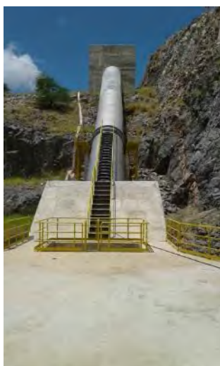
Figura 27-13 – EBI-3 – Adutora de Recalque
