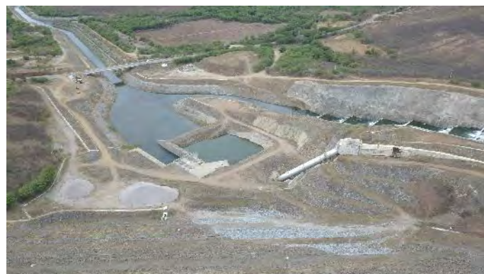
Figura 8-32 – Barragem Jati - Canal de restituição do vertedouro
