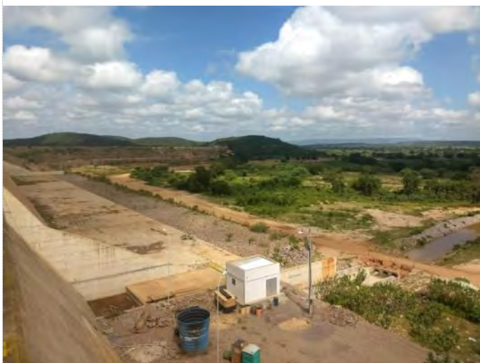
Figura 10-15 - Barragem Porcos – Canal de Restituição do Vertedor
