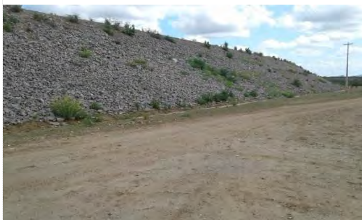
Figura 2-13 – Barragem Tucutu - Talude de Jusante
