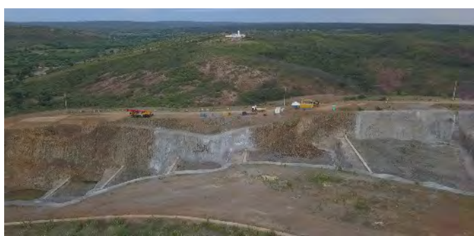
Figura 8-13 – Barragem Jati - Soleira do vertedouro
