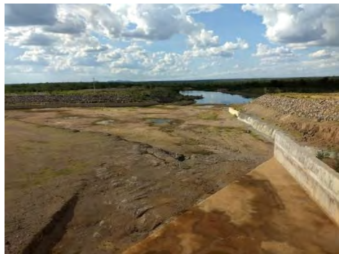
Figura 4-14 – Barragem Serra do Livramento - Canal de Restituição do Vertedor
