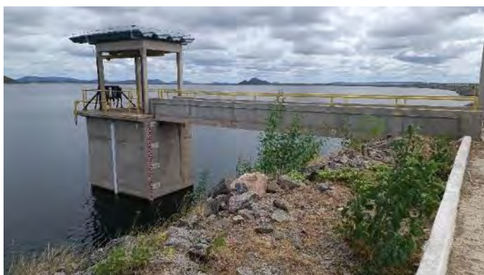
Figura 4-24 – Barragem Serra do Livramento - Torre da TUD
