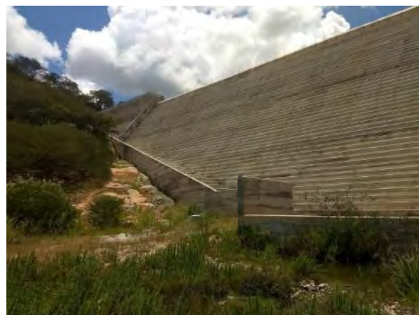
Figura 6-8 – Barragem Negreiros – Vertedor
