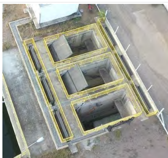
Figura 10-64 - Estrutura de Controle Porcos - Comportas stop-log
