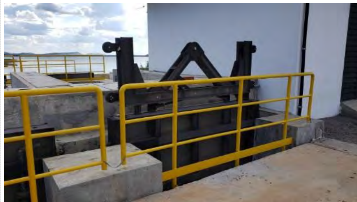
Figura 4-41 – Barragem Serra do Livramento - Viga Pescadora
