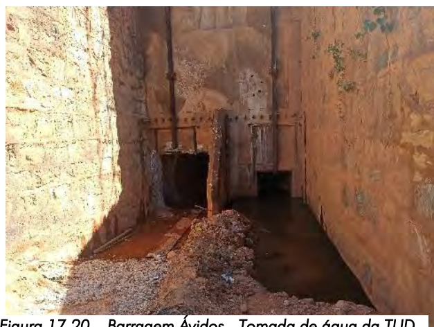
Figura 17-20 – Barragem Ávidos - Tomada de água da TUD
