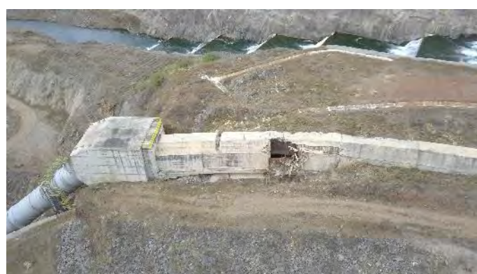
Figura 8-18 – Barragem Jati - Galeria de adução rompida
