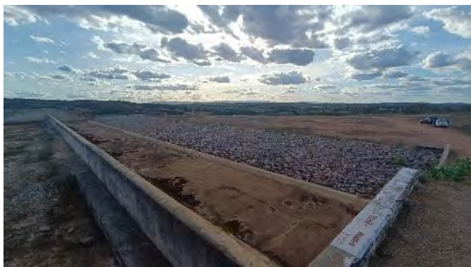
Figura 13-27 - Barragem Bois – Vertedor entre Boi I e Boi II
