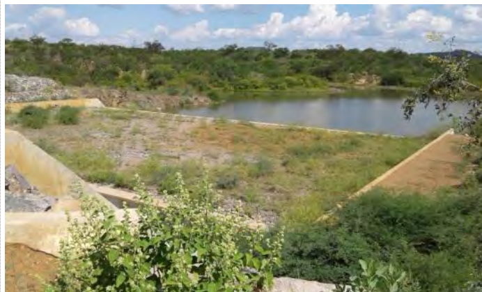
Figura 5-16 – Barragem Mangueira - Canal de Restituição do Vertedor
