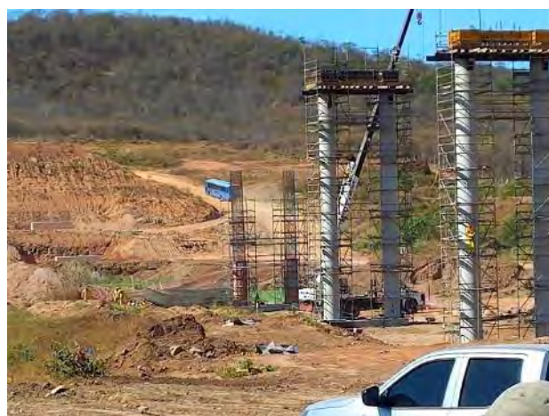
Figura 28-48 – Execução de Aqueduto
