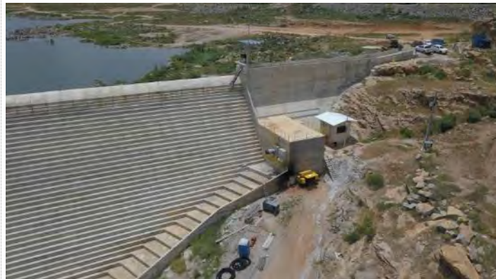
Figura 6-6 – Barragem Negreiros – Vista aérea vertedor
