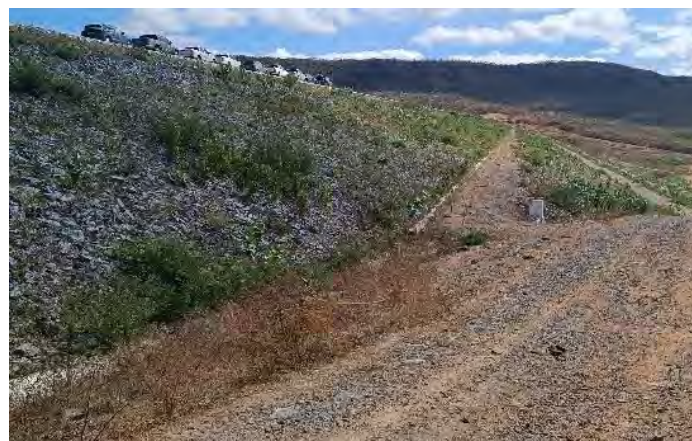
Figura 15-24 - Barragem Boa Vista – Talude de Jusante
