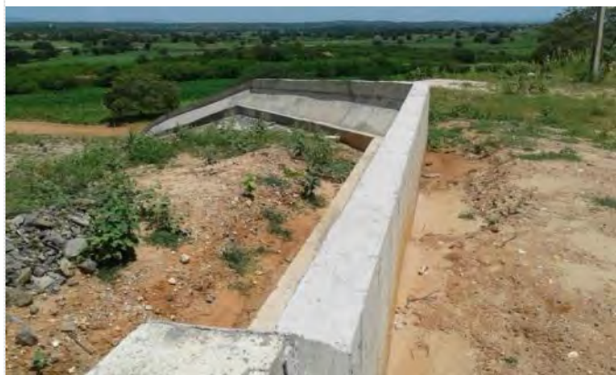
Figura 13-16 - Barragem Bois – Vertedor Dique Boi I (muro do canal de restituição)
