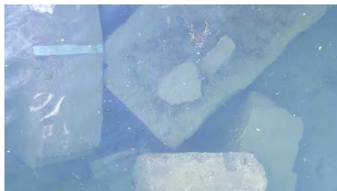
Figura 6-60 –Estrutura de Controle Negreiros – Detritos no canal
