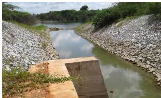
Figura 16-12 - Barragem Caiçara – Canal de Restituição da TUD
