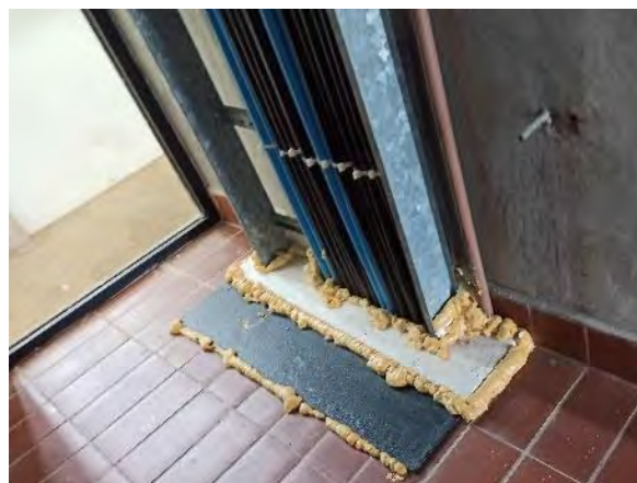
Figura 25-34 – EBI-1 – Organização de Cabos entre Pavimentos
