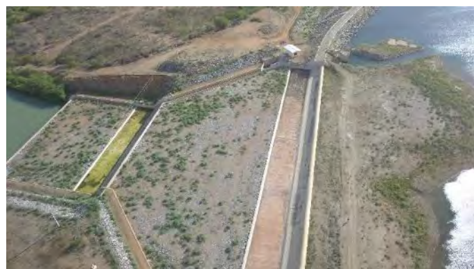
Figura 5-37 – Barragem Mangueira - Canal de Restituição do Vertedor
