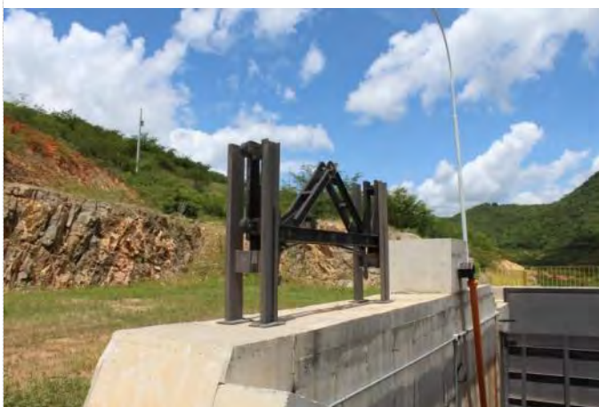
Figura 16-37 - Estrutura de Controle Caiçara – Viga Pescadora
