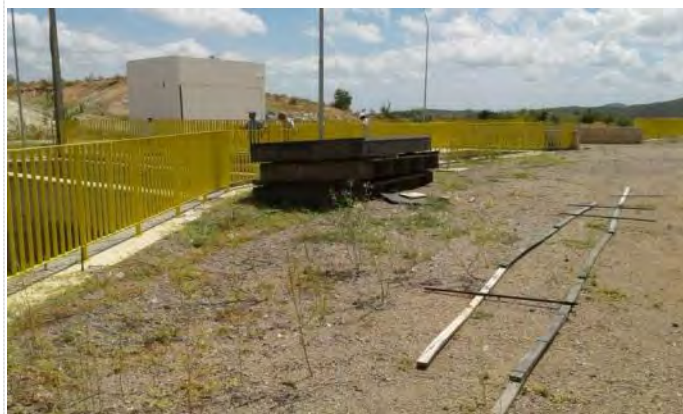
Figura 10-46 - Estrutura de Controle Porcos – Comportas stop-log
