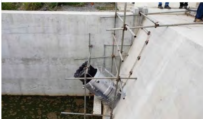
Figura 2-17 – Barragem Tucutu - Válvula Dispersora
