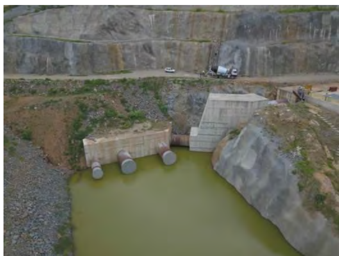
Figura 9-15 - Barragem Atalho – Tubulação de espera da PCH
