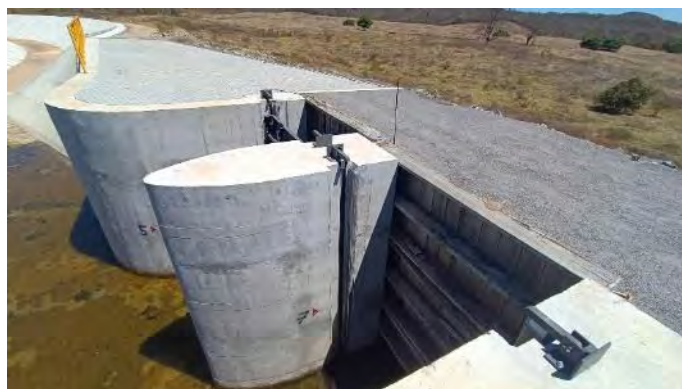
Figura 28-44 – Estrutura de Controle KM 30 – Comportas
