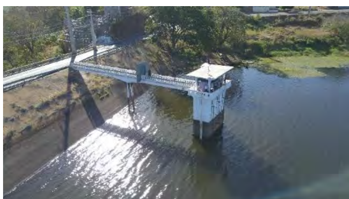
Figura 18-5 – Barragem São Gonçalo – Torre da Tomada d'água
