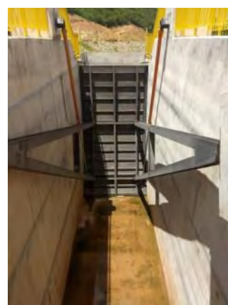
Figura 13-42 - Estrutura de Controle Bois – Comporta
