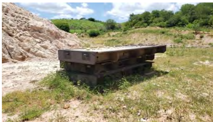
Figura 13-43 - Estrutura de Controle Bois – Comportas stop-log
