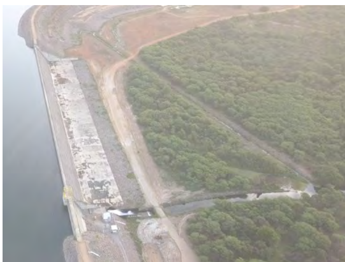
Figura 10-33 - Barragem Porcos – Canal de Restituição do Vertedor
