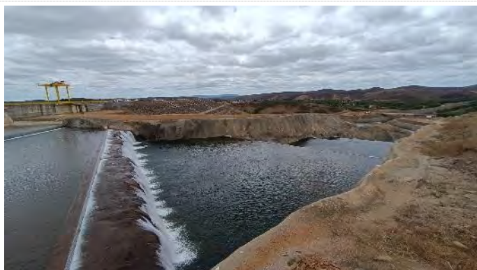
Figura 8-27 – Barragem Jati - Recorte na soleira do vertedouro
