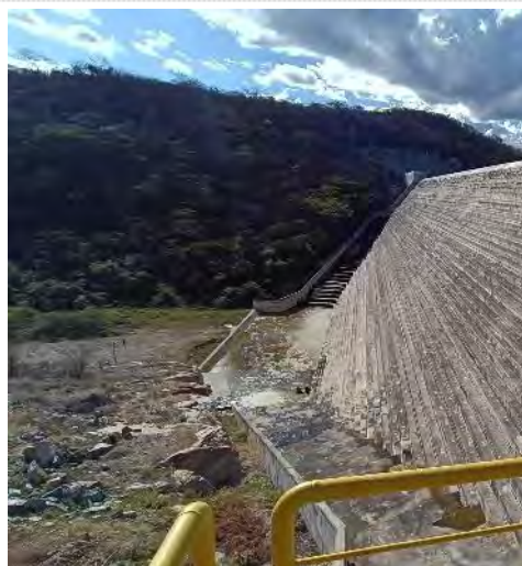
Figura 6-26 – Barragem Negreiros - Canal de Restituição do Vertedor
