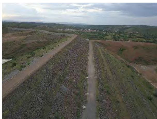
Figura 8-6 – Barragem Jati - Talude de jusante
