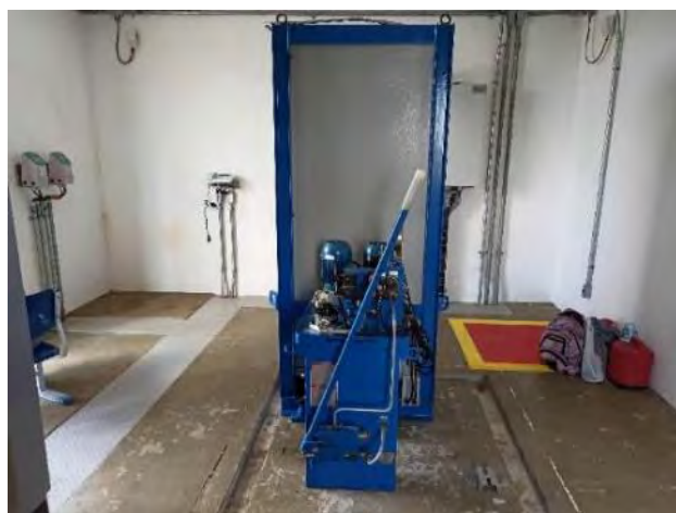
Figura 3-29 – Barragem Terra Nova – Unidade Hidráulica
