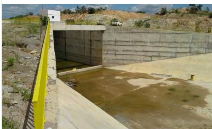
Figura 10-39 - Estrutura de Controle Porcos – Canal de Saída
