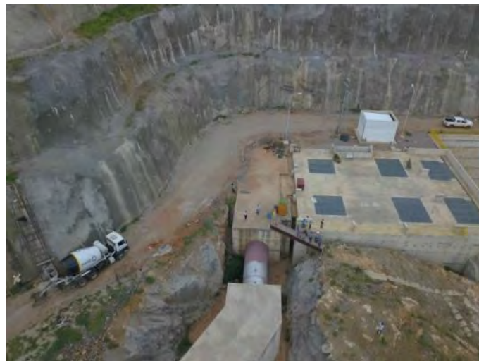
Figura 9-14 - Barragem Atalho – Ligação com a PCH (futura)
