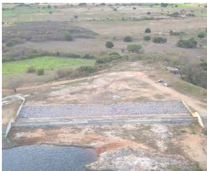
Figura 13-29 - Barragem Bois – Canal de Restituição do vertedor
