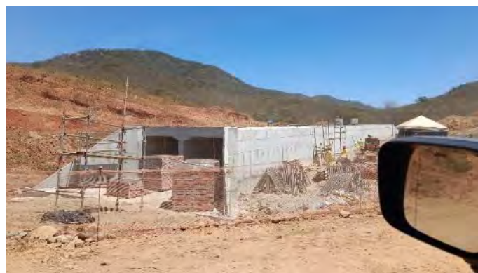
Figura 28-4 – Execução de Bueiro
