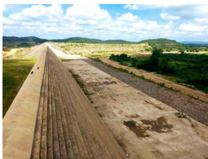
Figura 10-14 - Barragem Porcos – Vertedor
