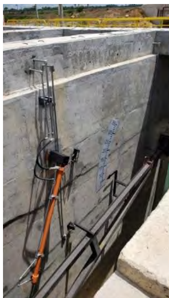
Figura 6-51 – Estrutura de Controle Negreiros – Régua de abertura da comporta
