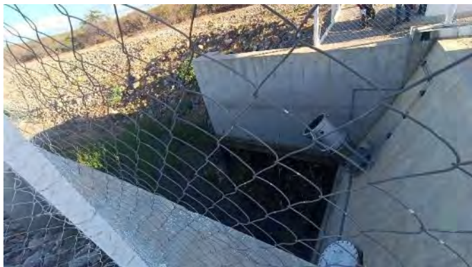
Figura 2-36 – Barragem Tucutu - Válvula Dispersora
