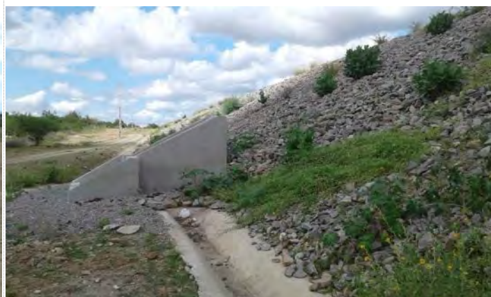
Figura 2-14 – Barragem Tucutu - Talude de Jusante e Medidor de Vazão
