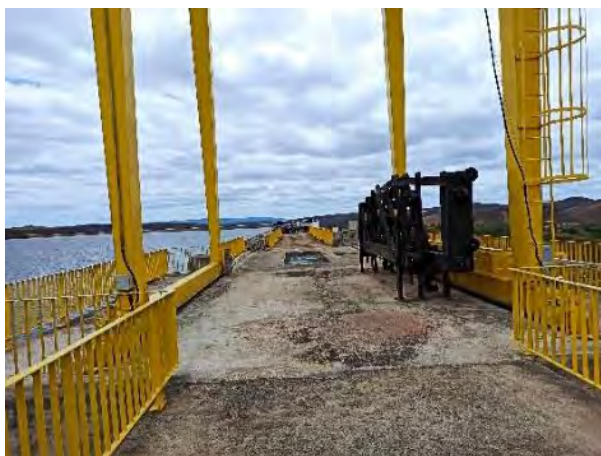
Figura 8-25 – Barragem Jati - talude de Montante – Barragem Jati - Viga pescadora
