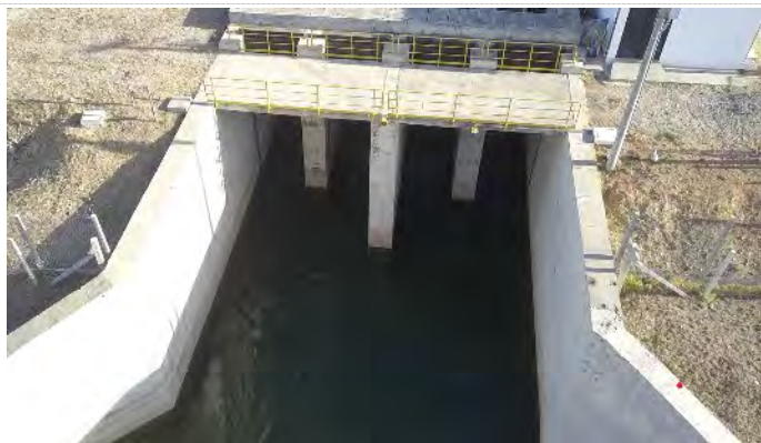
Figura 6-61 – Estrutura de Controle Negreiros – Canal de Saída
