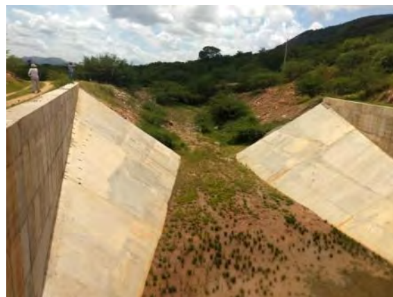
Figura 16-36 - Estrutura de Controle Caiçara – Canal de Saída
