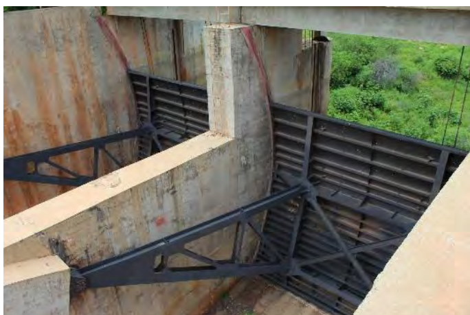
Figura 17-11 - Barragem Ávidos – Comportas do vertedouro
