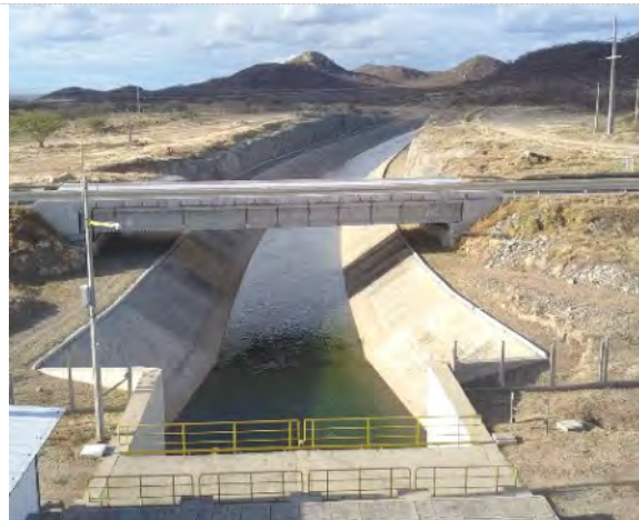
Figura 6-62 – Estrutura de Controle Negreiros - Canal de Saída
