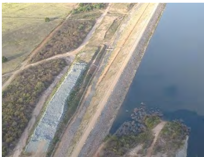
Figura 11. 11-9 - Barragem Cana Brava – Crista e Talude de Montante
