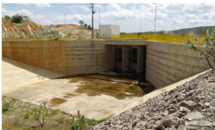
Figura 10-37 - Estrutura de Controle Porcos – Canal de Entrada
