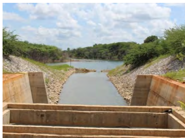
Figura 16-34 - Estrutura de Controle Caiçara – Canal de Entrada
