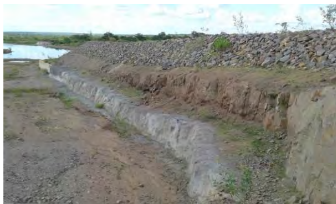
Figura 4-17 – Barragem Serra do Livramento - Canal de restituição da TUD
