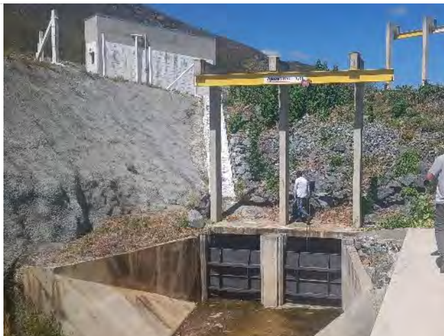
Figura 14-19–Barragem Morros – Comporta no canal de saída da tomada d'água
