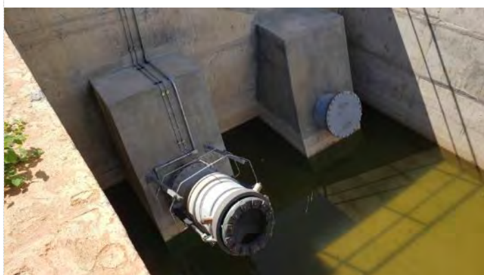
Figura 5-13 – Barragem Mangueira - Válvula Dispersora
