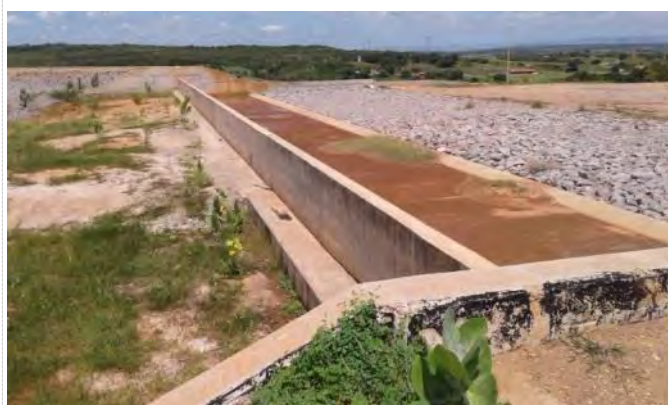
Figura 13-13 - Barragem Bois – Vertedor entre Boi I e Boi II
