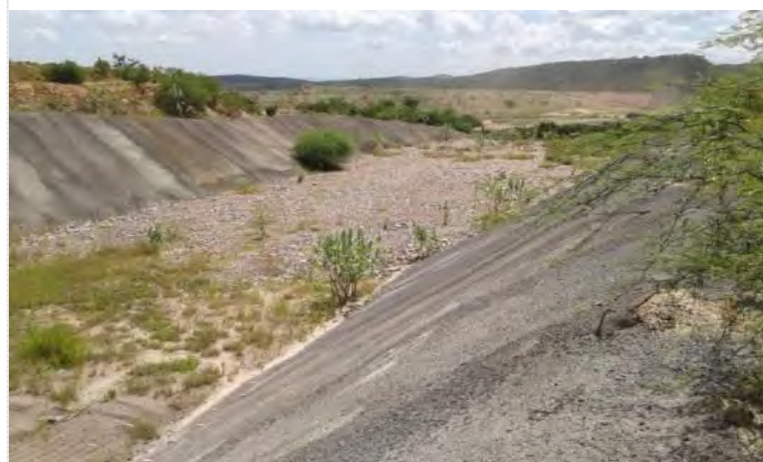
Figura 10-40 - Estrutura de Controle Porcos – Canal de Saída
