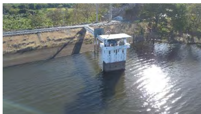
Figura 18-6 – Barragem São Gonçalo – Torre da Tomada d'água
