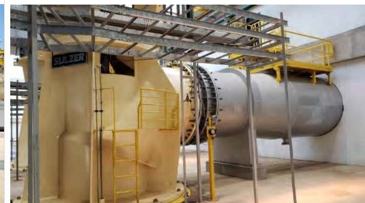
Figura 25-10 – EBI-1 – Bombas instaladas
