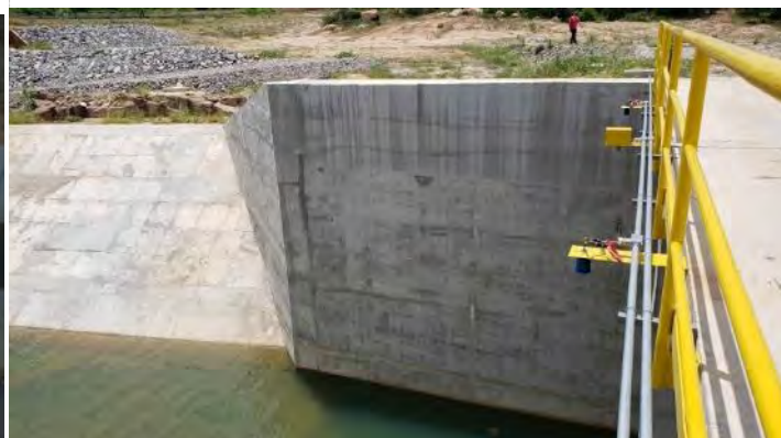
Figura 6-44 – Estrutura de Controle Negreiros – Medidores de vazão
