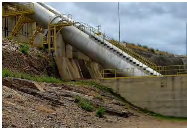
Figura 25-42 – EBI-1 – Tubulação de recalque
