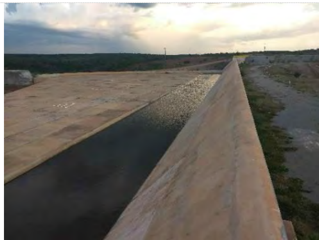
Figura 8-14 – Barragem Jati - Soleira do vertedouro
