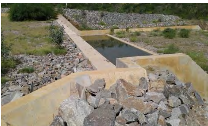
Figura 5-15 – Barragem Mangueira - Canal de Restituição do Vertedor
