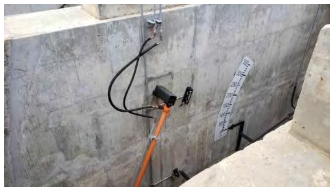
Figura 4-43 – Barragem Serra do Livramento - Régua de abertura das comportas
