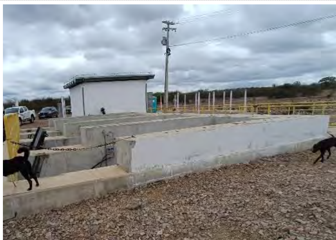
Figura 2-63 – Estrutura de Controle Tucutu – Guarda corpo não instalado
