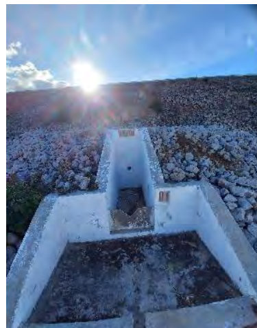
Figura 2-31 – Barragem Tucutu - Talude de Jusante e Medidor de vazão
