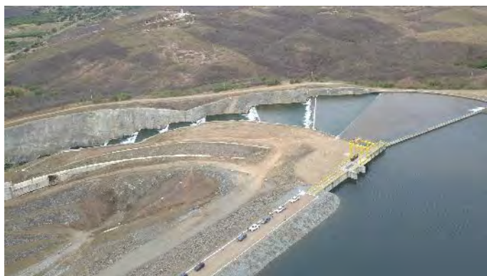
Figura 8-31 – Barragem Jati – Canal de restituição do vertedouro
