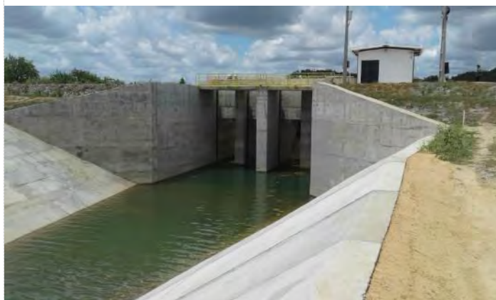
Figura 6-47 – Estrutura de Controle Negreiros – Canal de Saída
