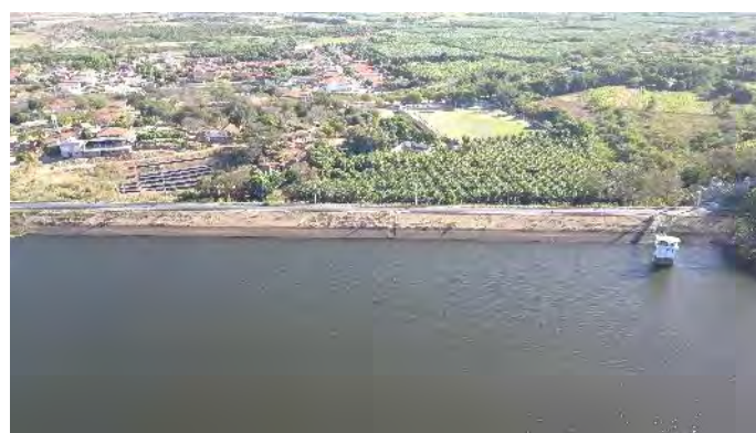
Figura 18-9 - Barragem São Gonçalo – Talude de Montante
