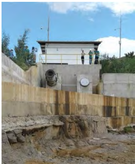
Figura 4-15 – Barragem Serra do Livramento - Válvula Dispersora
