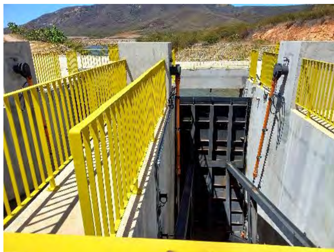
Figura 28-28 – Estrutura de controle no Res. Caiçara – Comporta
