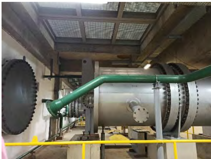
Figura 27-52 – EBI-3 – Conduto MB-02 Desacoplado
