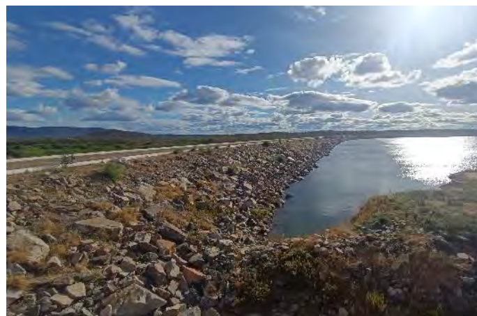
Figura 5-27 – Barragem Mangueira - Talude de Montante
