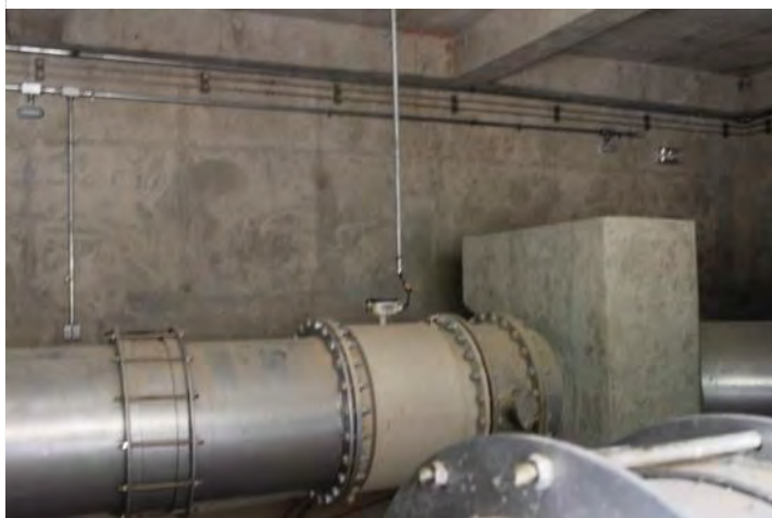
Figura 6-15 – Barragem Negreiros - Válvula Dispersora
