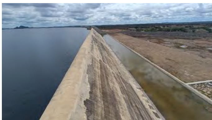
Figura 4-28 – Barragem Serra do Livramento - Vertedor
