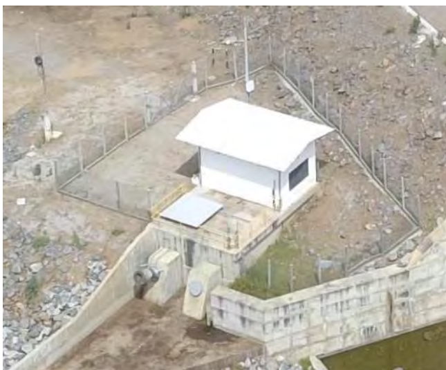
Figura 4-32 – Barragem Serra do Livramento - Válvula Dispersora
