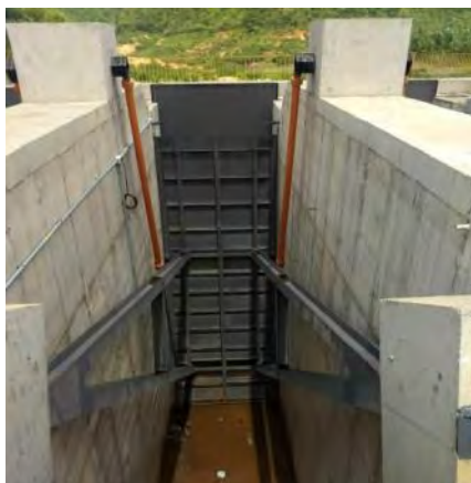
Figura 16-39 - Estrutura de Controle Caiçara - Comporta
