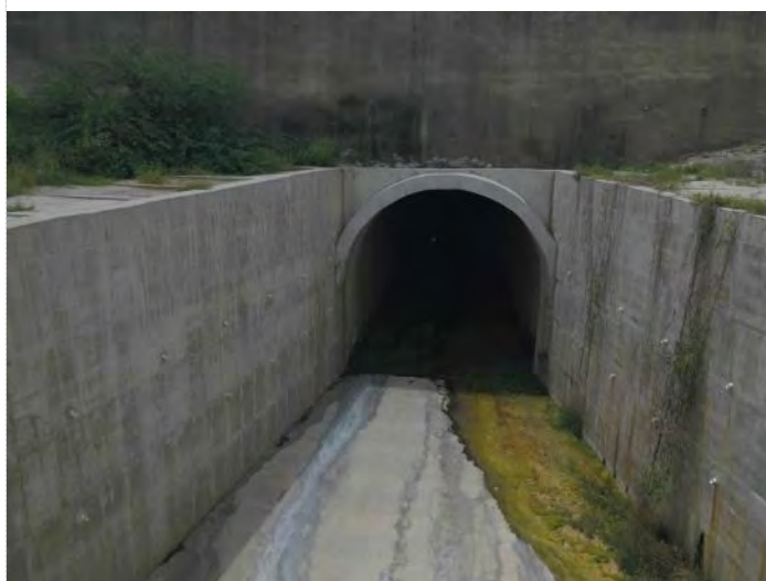
Figura 21-4 – Túnel Cuncas II – Emboque
