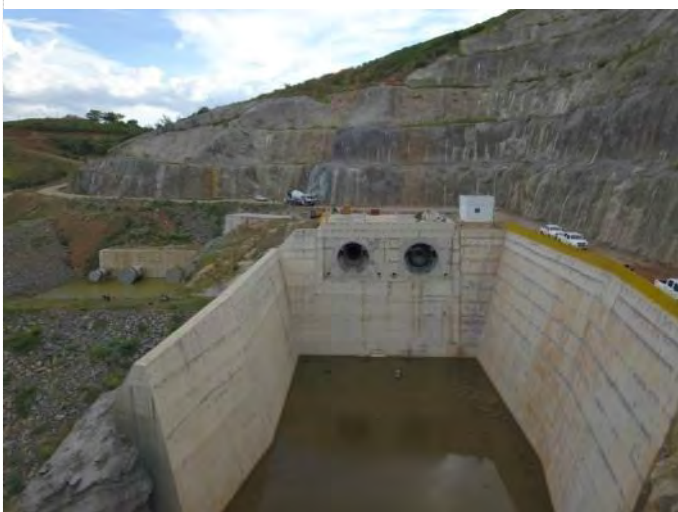
Figura 9-13 - Barragem Atalho – Válvula Dispersora
