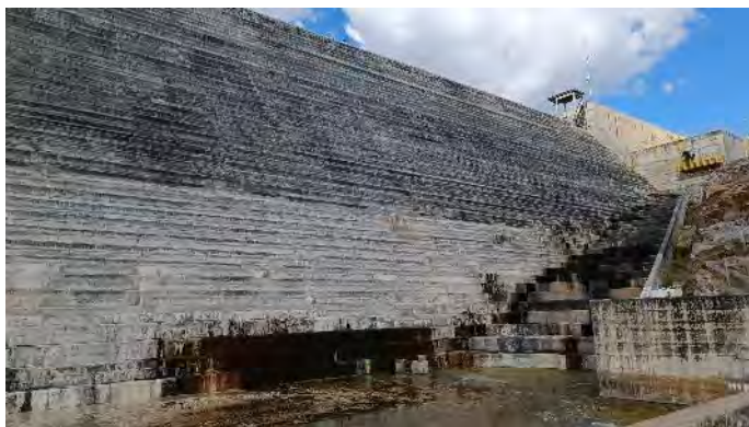
Figura 6-23 – Barragem Negreiros - Vertedor
