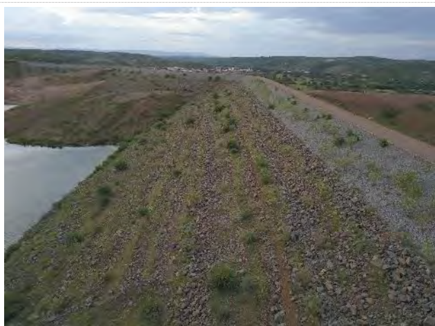
Figura 8-5 – Barragem Jati - Talude de montante
