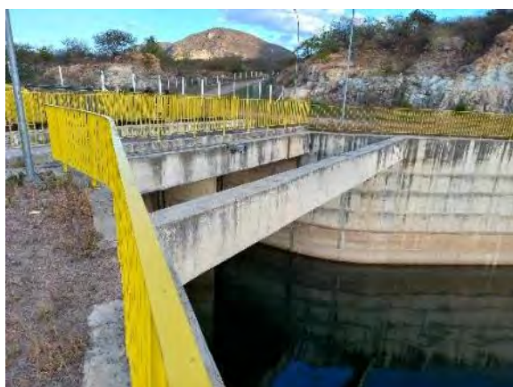
Figura 10-51 - Estrutura de Controle Porcos – Canal de Entrada
