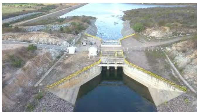
Figura 10-55 - Estrutura de Controle Porcos - Acesso ao Canal de Entrada
