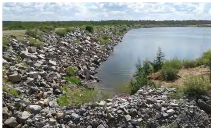
Figura 5-10 – Barragem Mangueira - Talude de Montante
