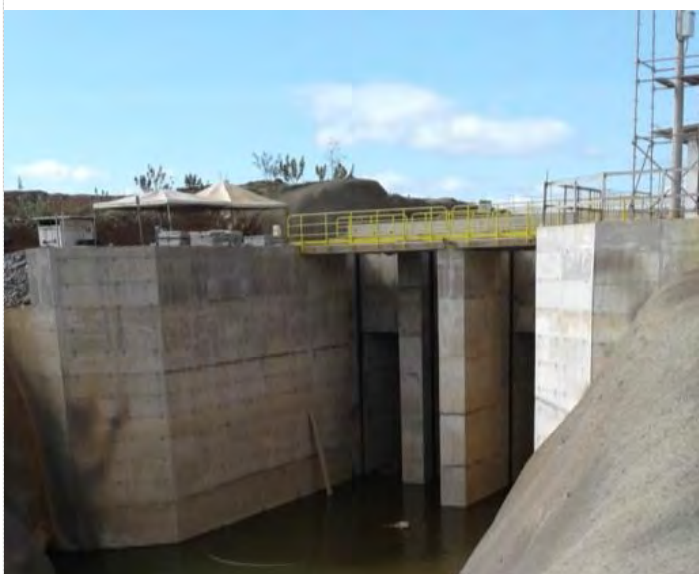
Figura 7-35 - Estrutura de Controle Milagres – Canal de Entrada
