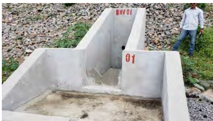
Figura 2-15 – Barragem Tucutu – Medidor de Vazão
