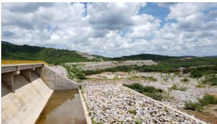
Figura 16-17 - Barragem Caiçara – Canal de Restituição do Vertedor
