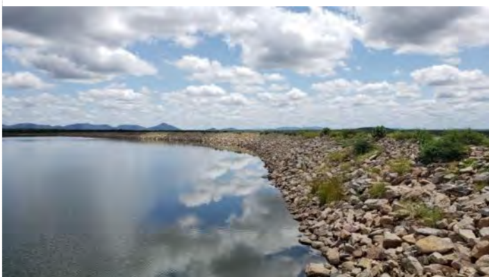
Figura 2-11 – Barragem Tucutu - talude de Montante
