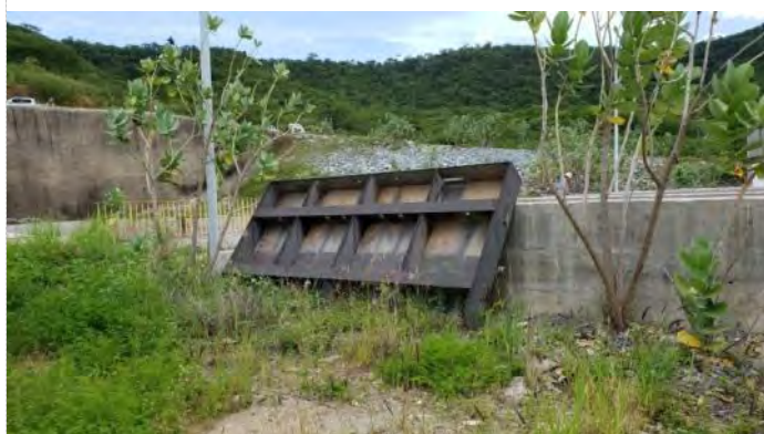
Figura 15-39 - Estrutura de Controle Boa Vista – Comporta stop-log
