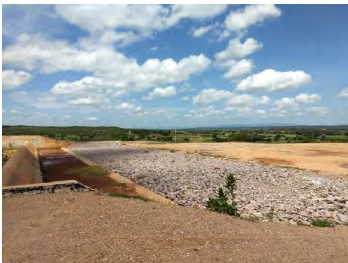
Figura 13-15 - Barragem Bois – Canal de Restituição do vertedor
