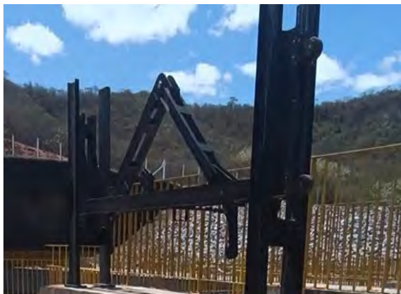
Figura 15-53 - Estrutura de Controle Boa Vista – Viga pescadora
