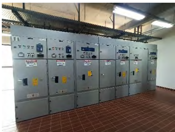
Figura 25-33 – EBI-1 – Painéis de Média Tensão
