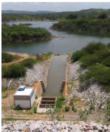
Figura 16-11 - Barragem Caiçara – Canal de Restituição da TUD
