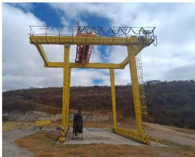
Figura 9-24 - Barragem Atalho – Pórtico da tomada de água
