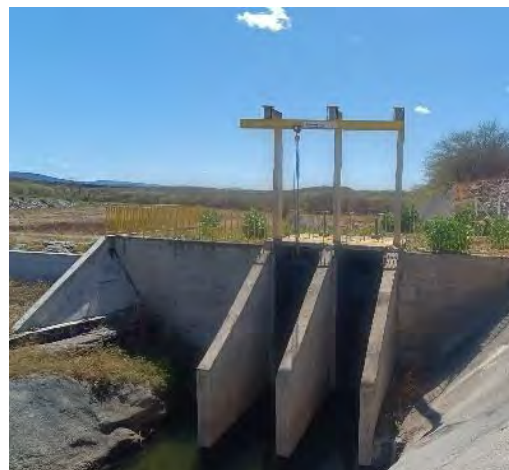
Figura 14-20–Barragem Morros – Comporta no canal de entrada da tomada d'água
