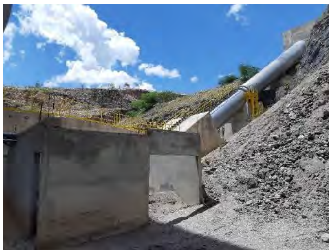
Figura 27-35 – EBI-3 – Estrutura de concreto armado incompleta no arranque do conduto
