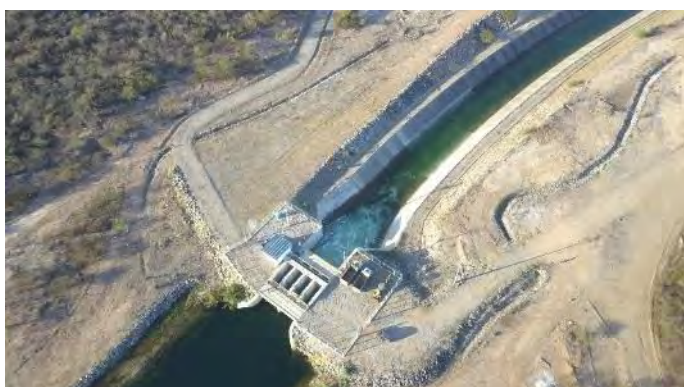
Figura 2-59 – Estrutura de Controle Tucutu – Canal de Saída
