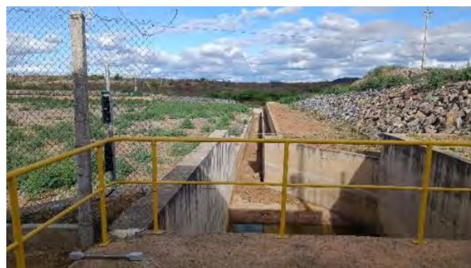
Figura 5-39 – Barragem Mangueira - Canal de Restituição do Vertedor
