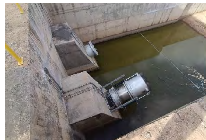
Figura 5-31 – Barragem Mangueira - Válvula Dispersora
