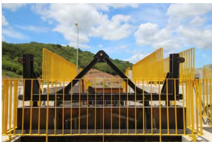
Figura 13-41 - Estrutura de Controle Bois – Comporta stop-log e viga pescadora
