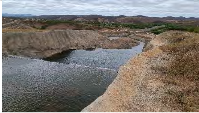
Figura 8-28 – Barragem Jati - Recorte na soleira do vertedouro
