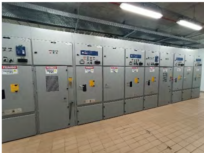
Figura 27-48 – EBI-3 – Painéis de Média Tensão
