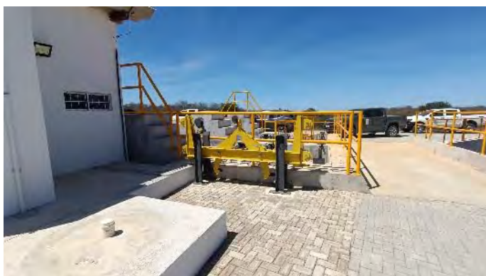
Figura 28-41 – Estrutura de Controle KM 30 – Viga Pescadora
