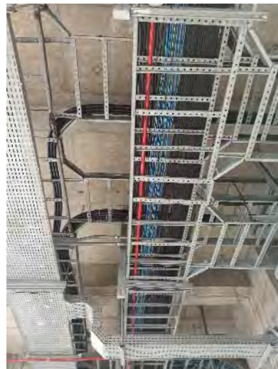
Figura 27-49 – EBI-3 – Cabos em Eletroleitos
