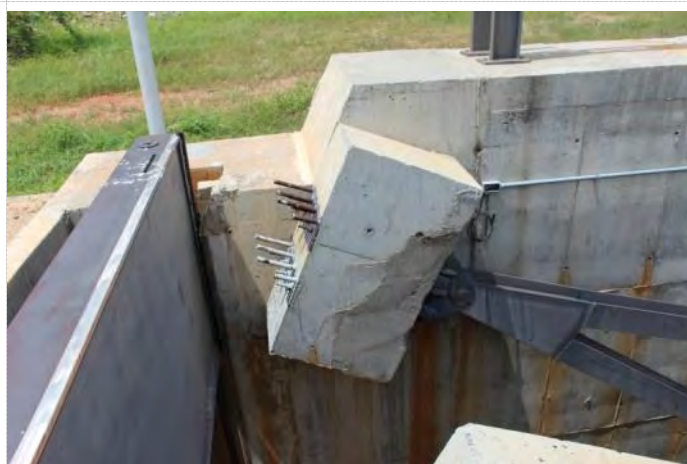
Figura 16-44 - Estrutura de Controle Caiçara - Viga Munhão
