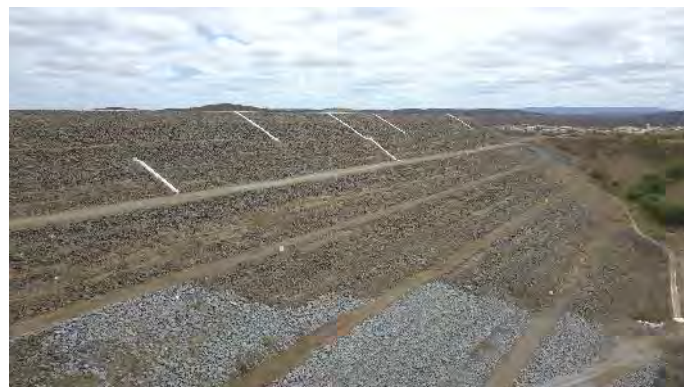
Figura 8-20 – Barragem Jati - Talude de jusante
