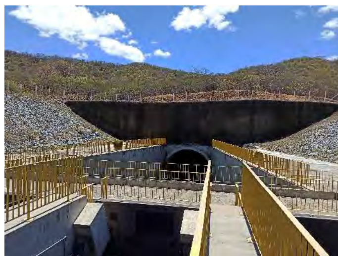
Figura 21-15 – Túnel Cuncas II – Emboque
