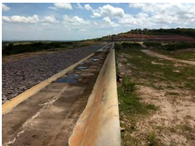
Figura 12-7 - Barragem Cipó - Vertedor
