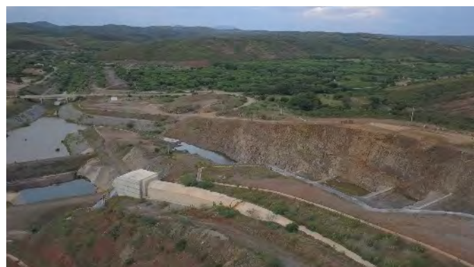
Figura 8-16 – Barragem Jati - Canal de restituição do vertedouro
