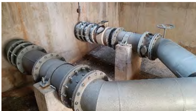
Figura 15-33 - Barragem Boa Vista – Válvula Dispersora
