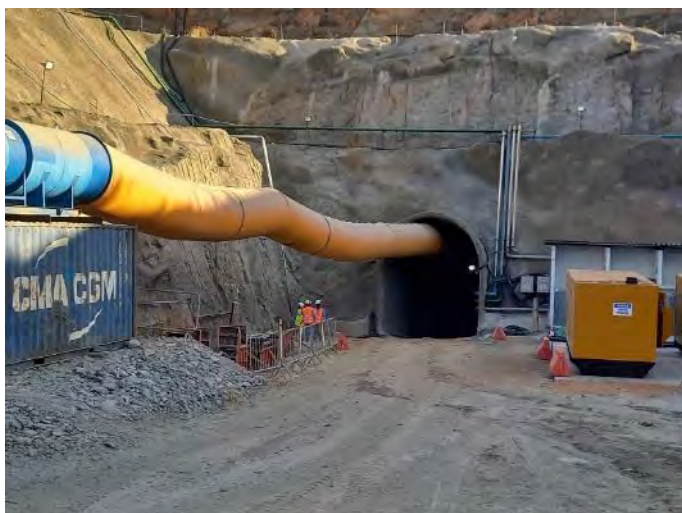
Figura 28-58 – Túnel Major Sales – Janela do Túnel
