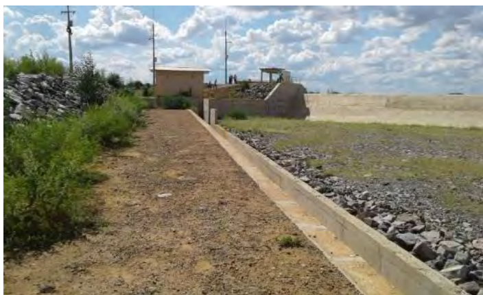
Figura 5-19 – Barragem Mangueira - Canal de Restituição do Vertedor
