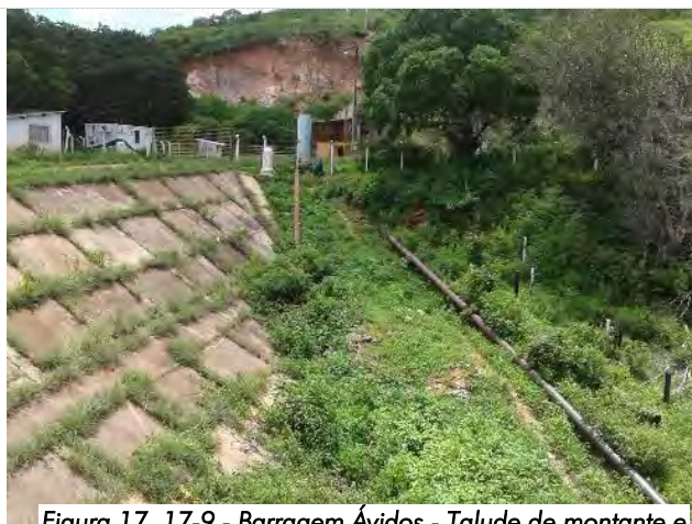
Figura 17. 17-9 - Barragem Ávidos - Talude de montante e adutora
