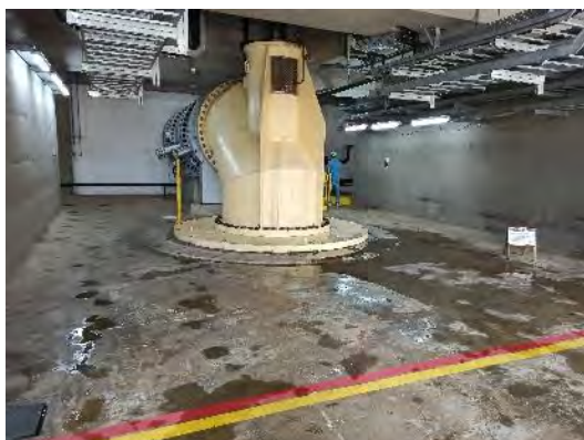
Figura 26-35 – EBI-2 – Vazamento MB02
