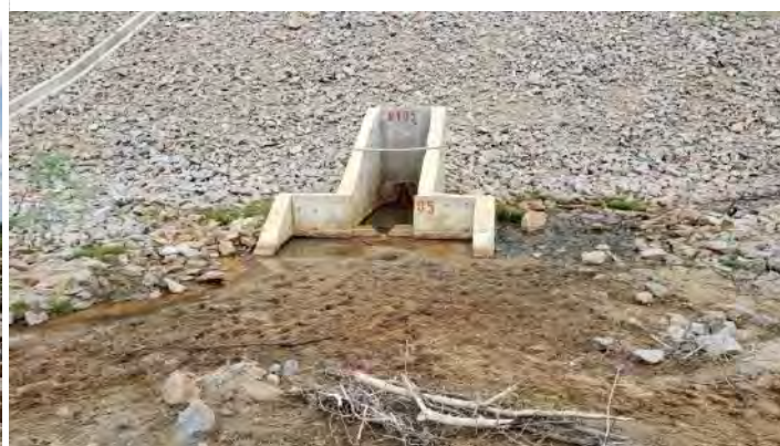
Figura 2-12 – Barragem Tucutu - Talude de Jusante e Medidor de Vazão
