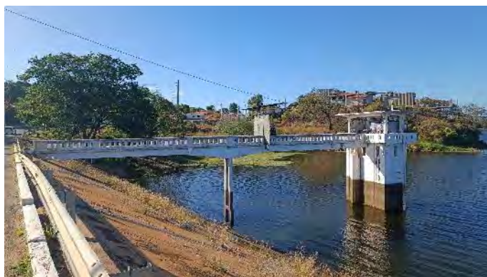
Figura 18-10 – Barragem São Gonçalo – Torre da Tomada d'água
