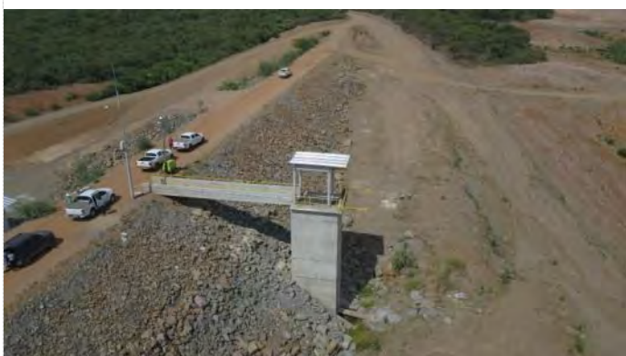
Figura 7-9 - Barragem Milagres – Torre da TUD
