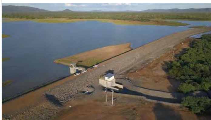
Figura 3-5 – Barragem Terra Nova - Torre da TUD
