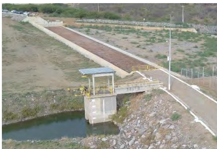
Figura 5-22 – Barragem Mangueira - Torre da TUD
