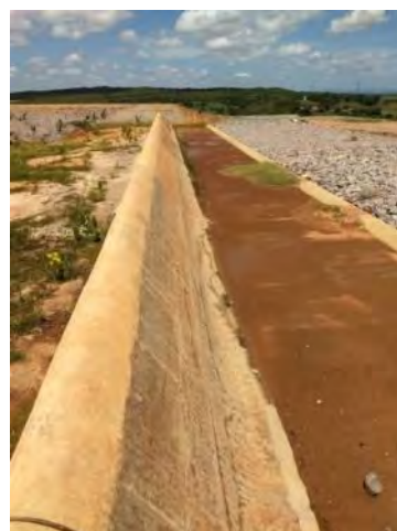
Figura 13-10 - Barragem Bois – Vertedor entre Boi I e Boi II
