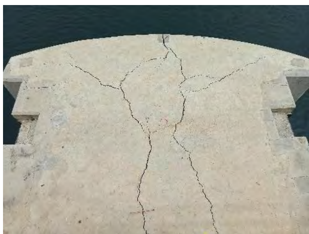
Figura 26-33 – EBI-2 – Rachadura piso junto a Comportas
