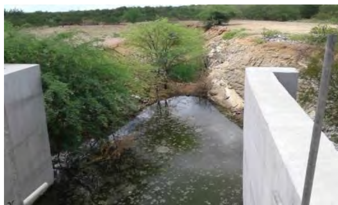
Figura 2-18 – Barragem Tucutu - Canal de Restituição da TUD
