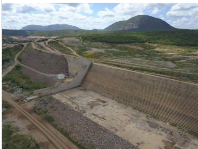
Figura 10-13 - Barragem Porcos - Vertedor
