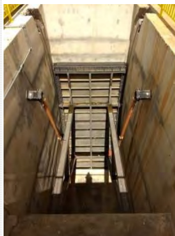
Figura 10-48 - Estrutura de Controle Porcos – Comporta
