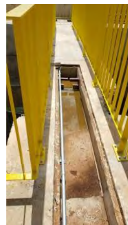
Figura 10-48 - Estrutura de Controle Porcos – Comporta
