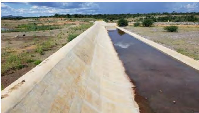
Figura 5-17 – Barragem Mangueira - Vertedor
