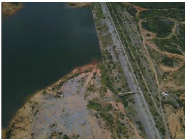
Figura 15-5 - Barragem Boa Vista – Crista e Talude de Montante
