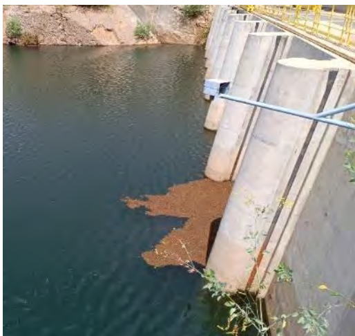
Figura 25-41 – EBI-1 – Material suspenso no canal de entrada
