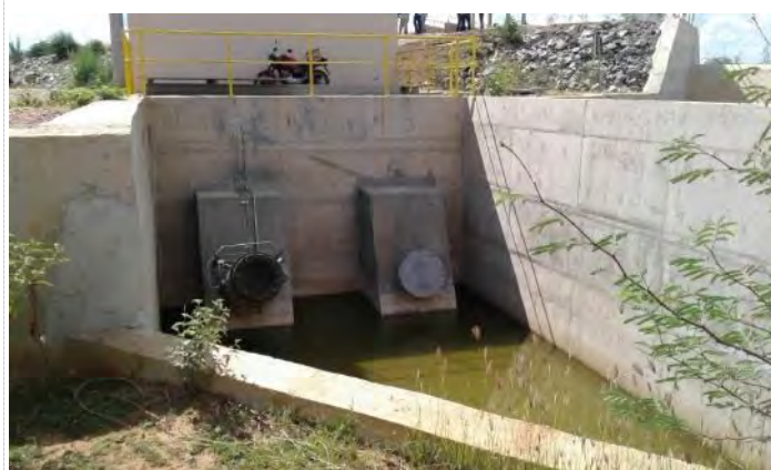
Figura 5-14 – Barragem Mangueira - Válvula Dispersora
