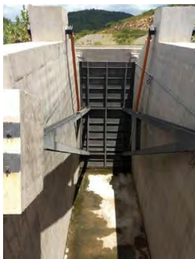
Figura 21-8 – Túnel Cuncas II – Comporta
