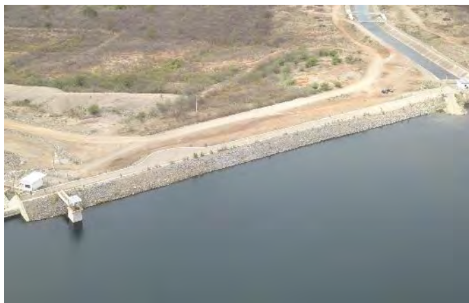
Figura 4-26 – Barragem Serra do Livramento - Talude de Montante
