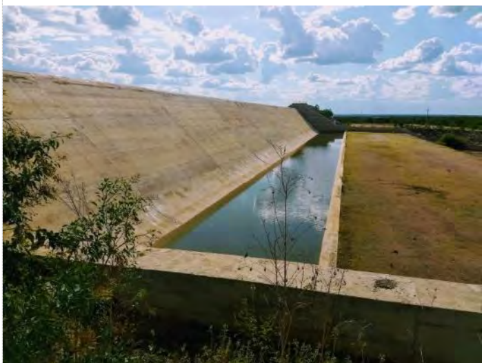
Figura 4-13 – Barragem Serra do Livramento - Vertedor
