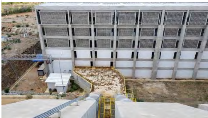
Figura 25-20 – EBI-1 – Adutoras de Recalque
