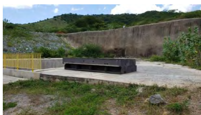
Figura 15-40 - Estrutura de Controle Boa Vista – Comporta stop-log
