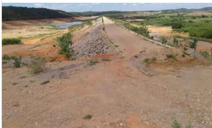
Figura 11-5 - Barragem Cana Brava Crista e Talude de Montante
