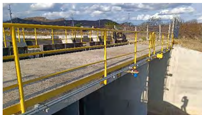
Figura 6-56 – Estrutura de Controle Negreiros – Medidores de vazão
