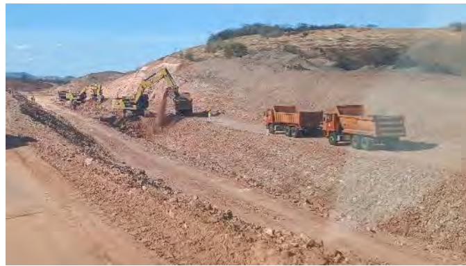
Figura 28-8 – Execução de canal
