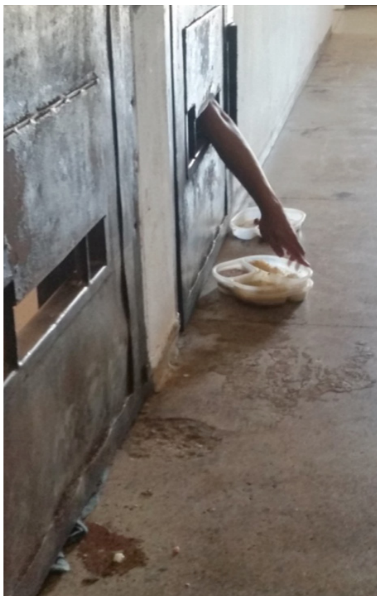
Figura 15 – Alimentação e Isolamento em Unidade do Socioeducativo de TO
