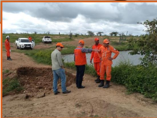
Rebaixamento dos vertedouros de três barragens, localizadas na Fazenda Senhor do Bonfim para evitar novos rompimentos.
