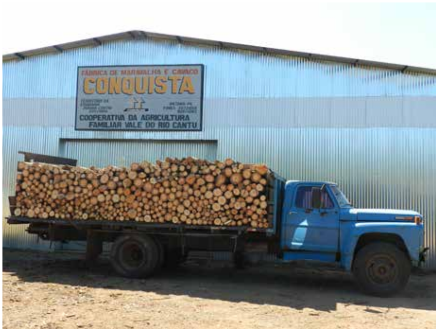
FIGURA 10 – Projeto de processamento da madeira por associação de agricultores familiares. Fábrica de Cavaco e Maravalha implementada com recursos do PRONAT em Iretama - PR.
