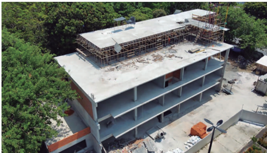
Projeto OCARA - Construção do Centro de Conhecimento
