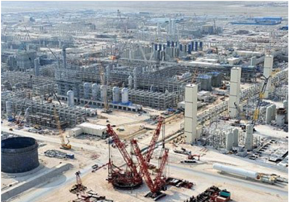
Figura 16 – Construção da ASU do Pearl GTL Project
