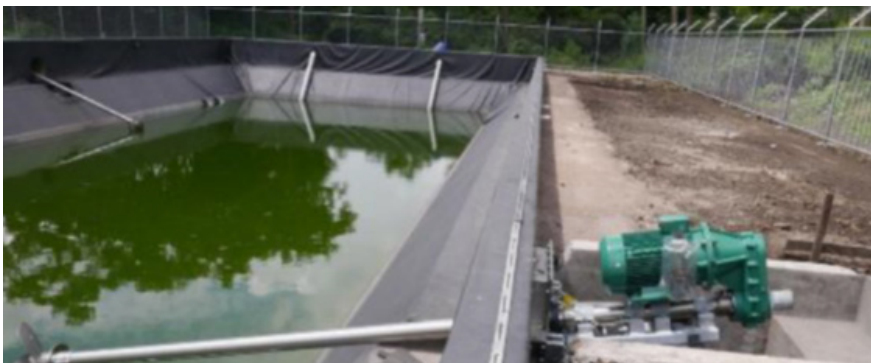
Figura 54 – Lagoa Anaeróbica com Misturador em Construção
