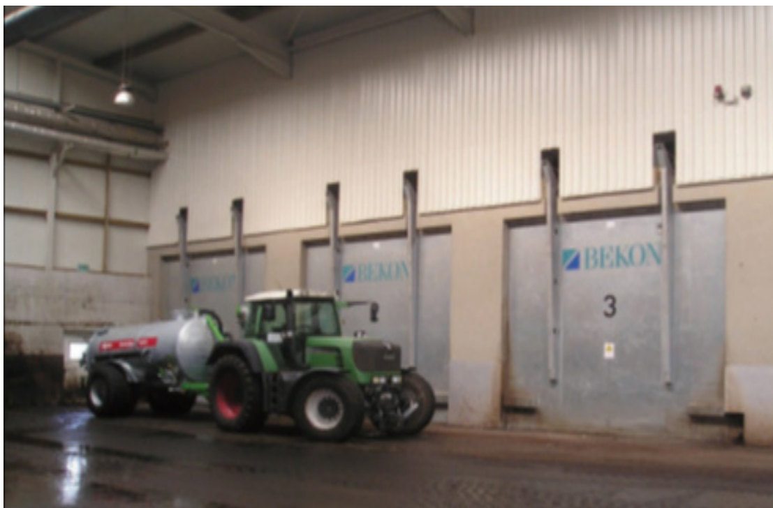
Figura 51 – Biodigestor de Garagem
