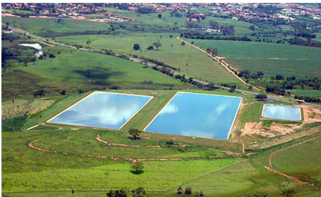
Figura 31 – Tratamento Secundário de Esgotos – Sistema Australiano
