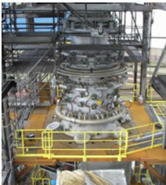
Figura 31 – Forno HIsarna em Instalação
