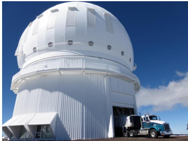
Figura 1.6.1 - Caminhão descarregando o instrumento SPIRou no prédio do observatório CFHT localizado no topo do vulcão Mauna Kea no Haváí (© M.Lacombe - IRAP/OMP).
