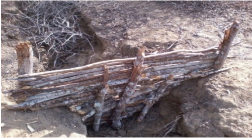
Implantação de 15 unidades Tratamento Linear com “Ramos de Faxina”
