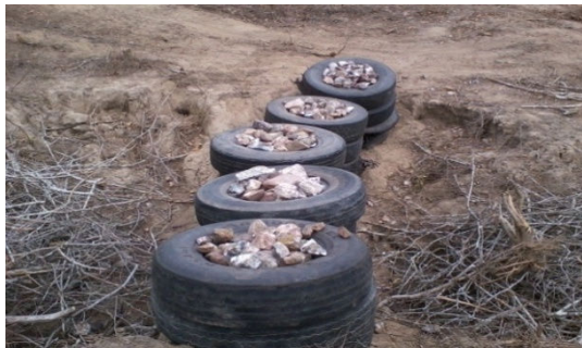
Implantação de 15 unidades tipo: Represa com pneus usados cheio com pedras
