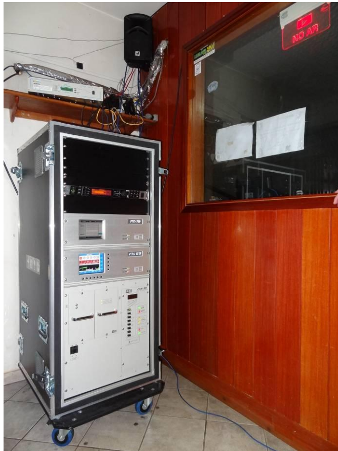
Figura 4 – Visão do transmissor HD Radio
