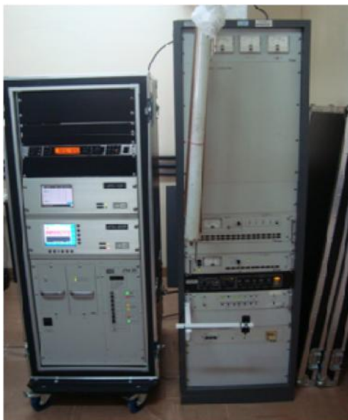
Figura 3 – Visão do transmissor HD Radio (esq.) e o transmissor FM (dir.)
