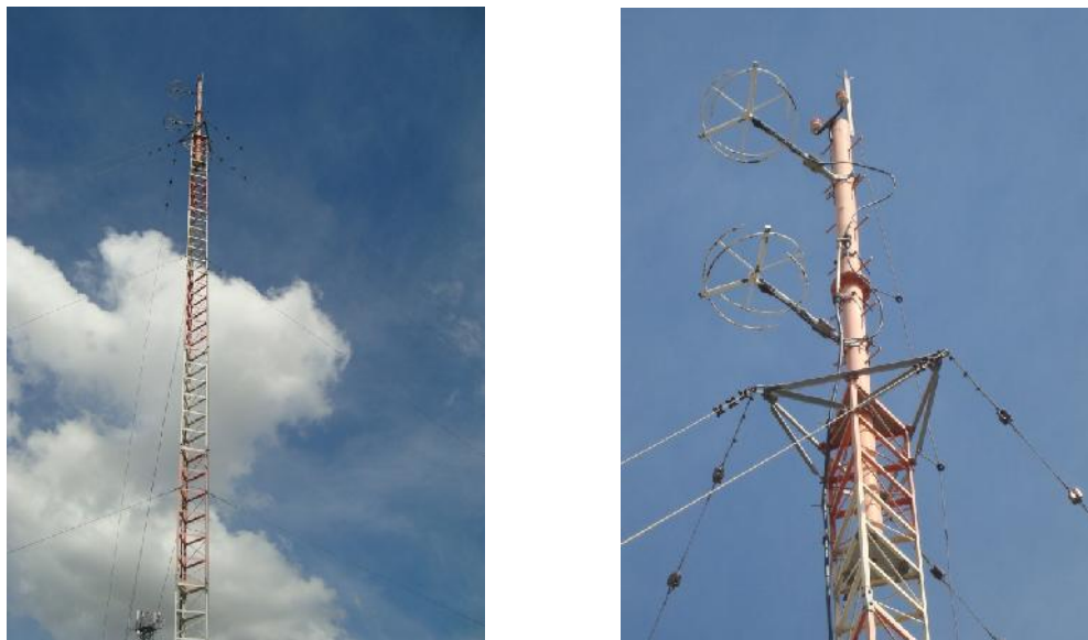
Figura 6 – Visão do mastro (esq.) e detalhe da antena de dois elementos (dir.) da emissora UFMG Educativa utilizada nos testes
