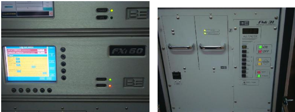
Figura 5 – Detalhe do excitador (esq.) e dos amplificadores (dir.).
