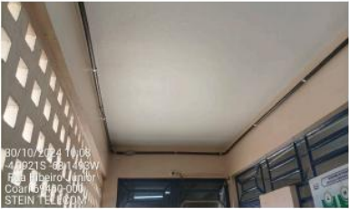
Fotos da infraestrutura de passagem de cabos (Tubulação)
