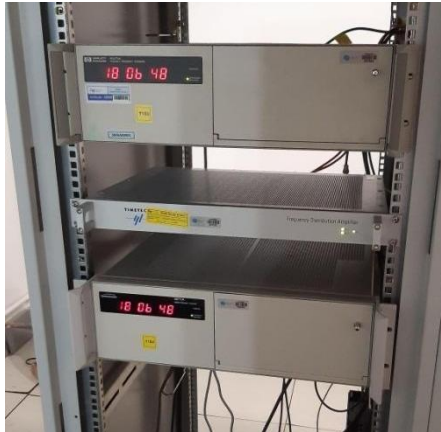
Figura 20: Padrões atômicos de feixe de césio. Fonte: Autoria própria, 2024.
