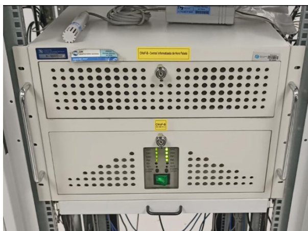
Figura 27: Equipamento de transmissão da hora falada atual. Fonte: Autoria própria, 2024.
